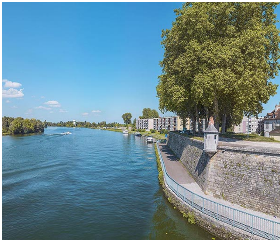
Vue du bastion en amont du pont.
