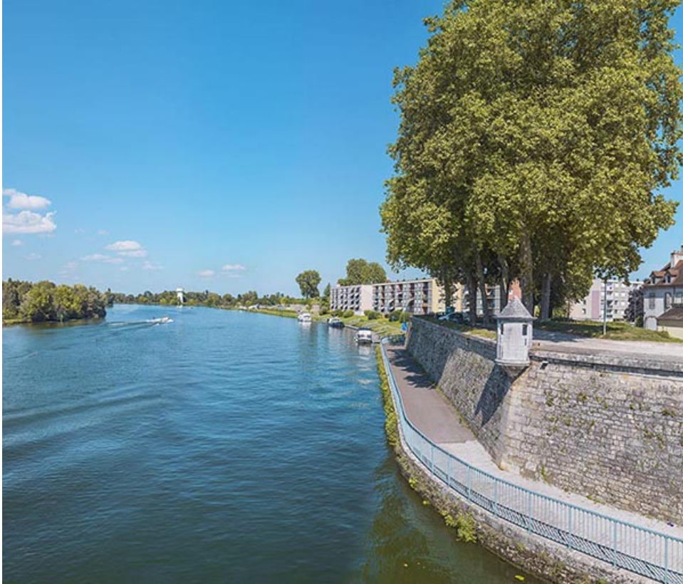
Vue du bastion en amont du pont.
