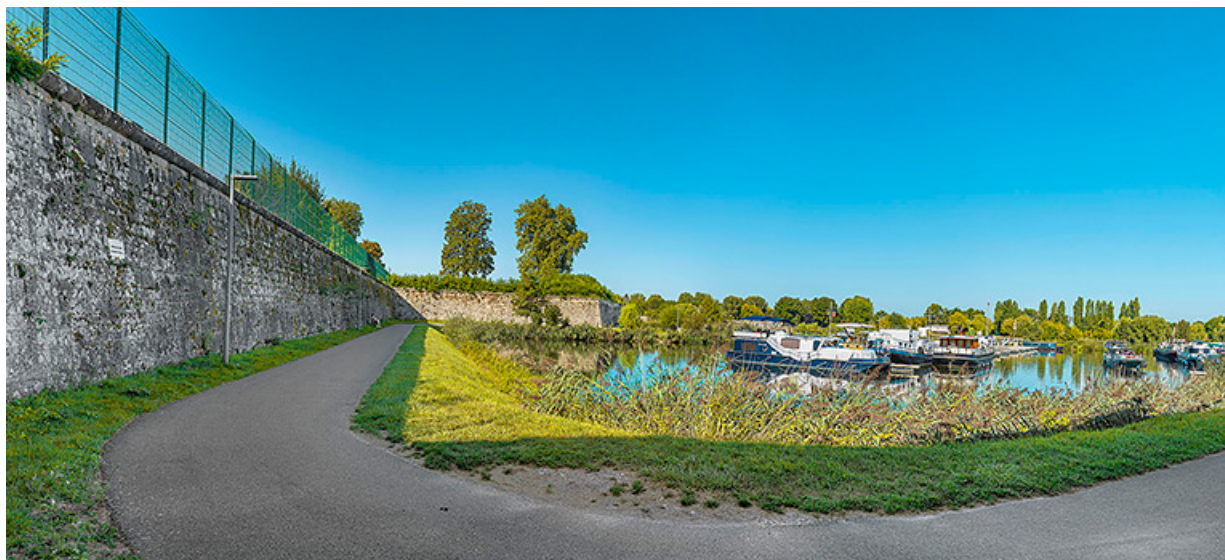
La courtine reliant les bastions Royal et du Béchaux, le port de plaisance et le bastion en arrière-plan.
