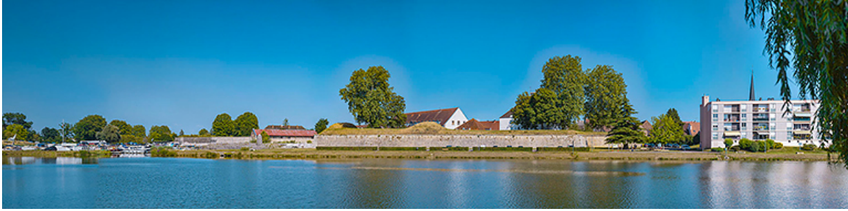
Le bastion, vu depuis la rive droite de la Saône.
