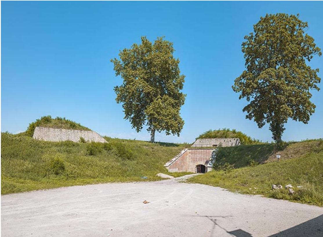
Vue générale du bastion depuis sa gorge.
