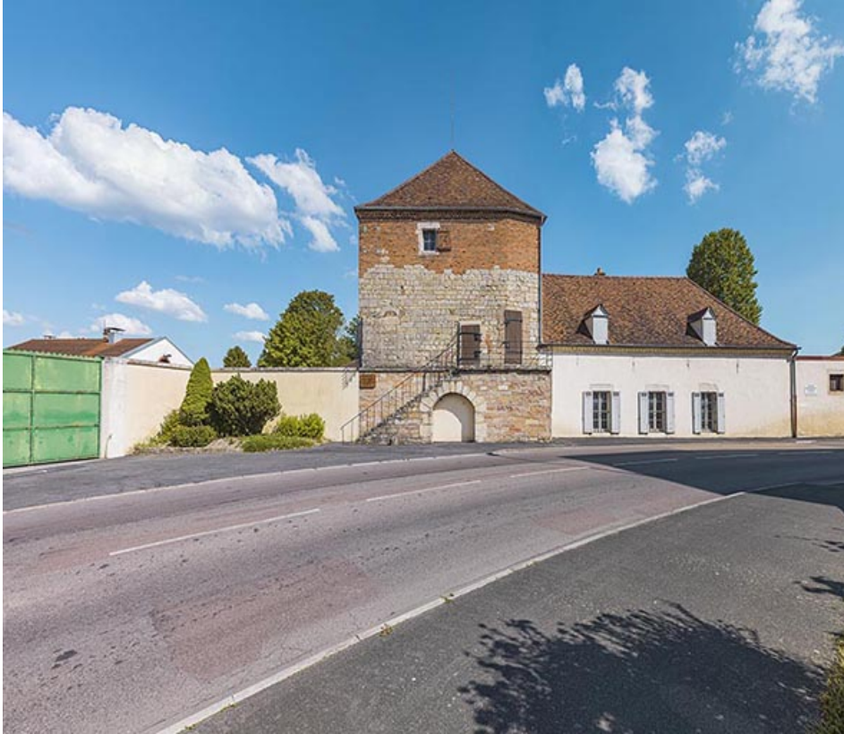
La tour Belvoir, face côté gorge.
