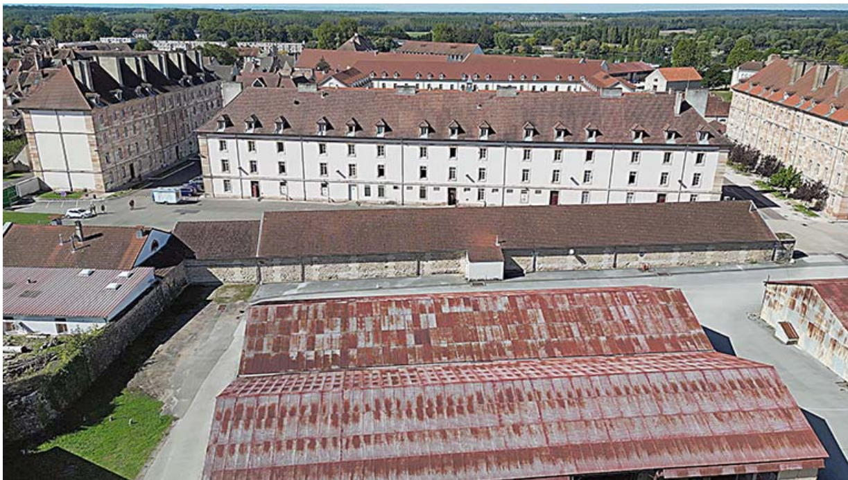
Vue aérienne du rempart reliant les bastions du Gouverneur et du Cygne.
