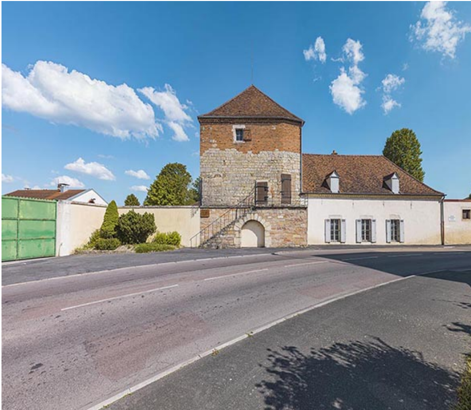
La tour Belvoir, face côté gorge.
