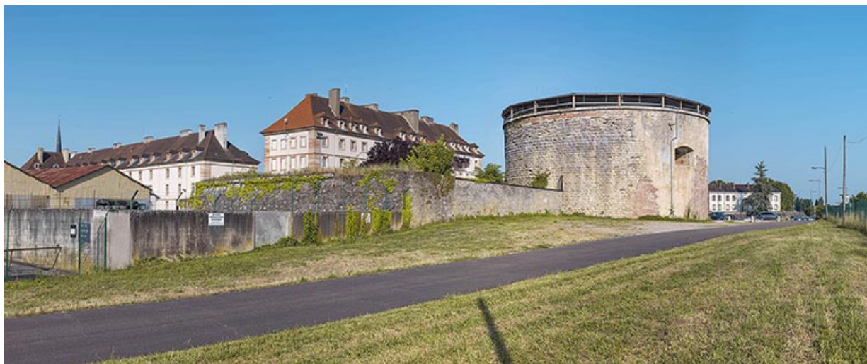
La tour et une partie de l'ancien bastion.
