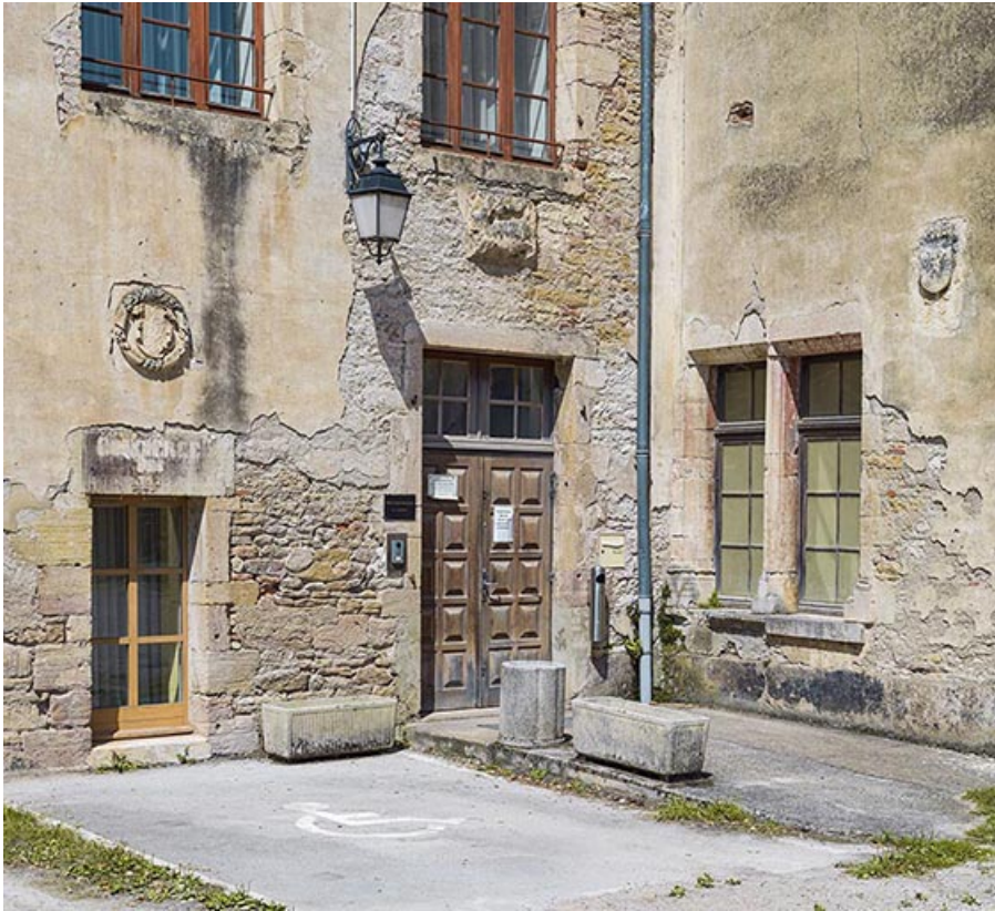
Murs à l'angle du logis du gouverneur et des casernes ouest.
