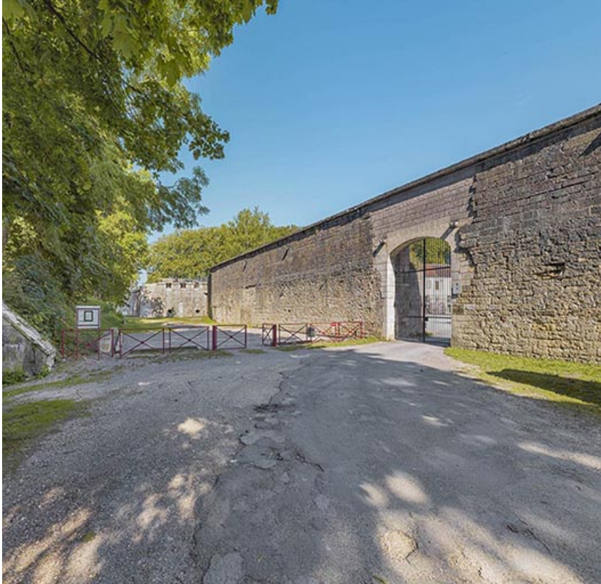
Porte de secours et la courtine sud du château.
