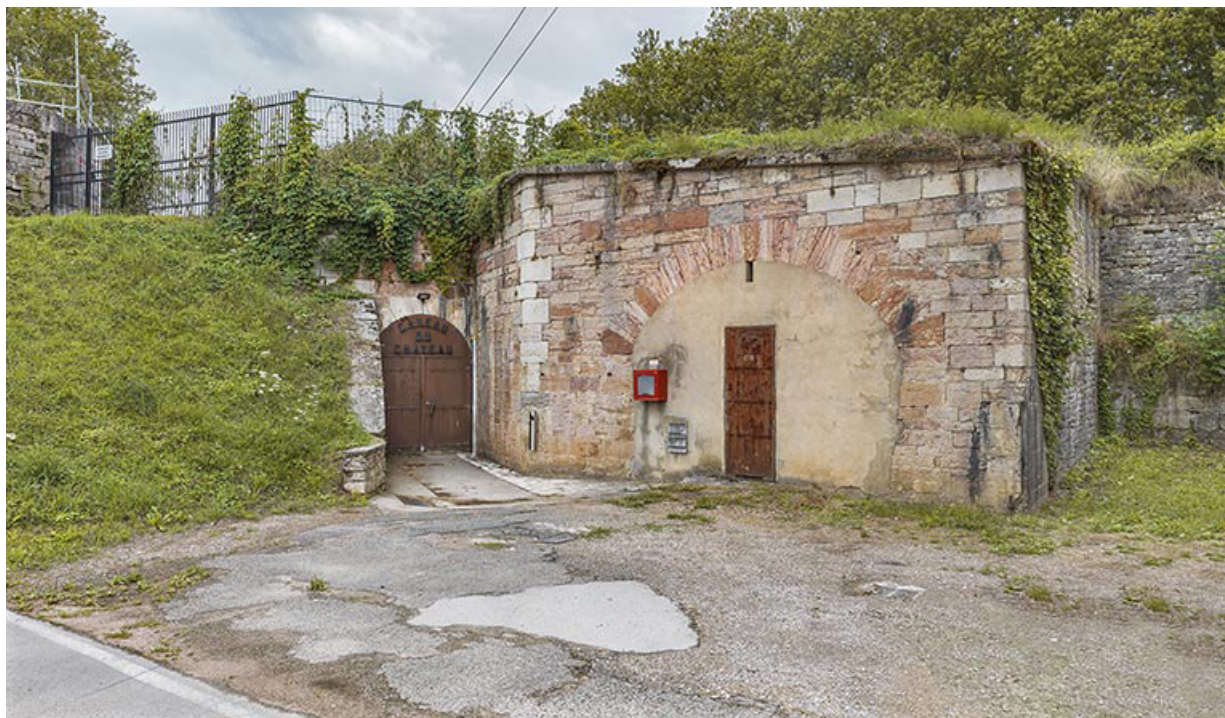
Entrée de la tour Beauregard transformée en bastion.
