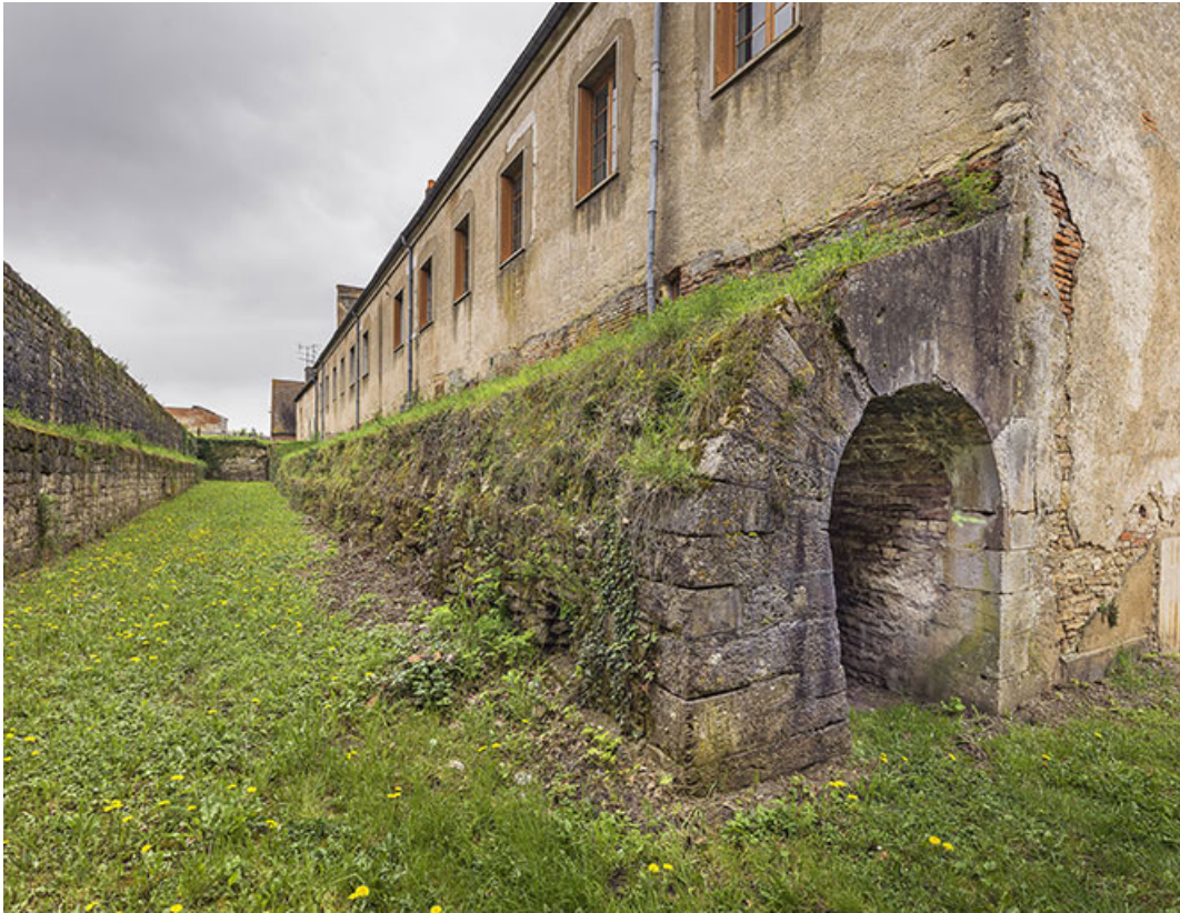
La galerie voûtée reliant la tour basse des Moulins au bastion de la tour Beauegard. 21, Auxonne, 1 rue du Château
