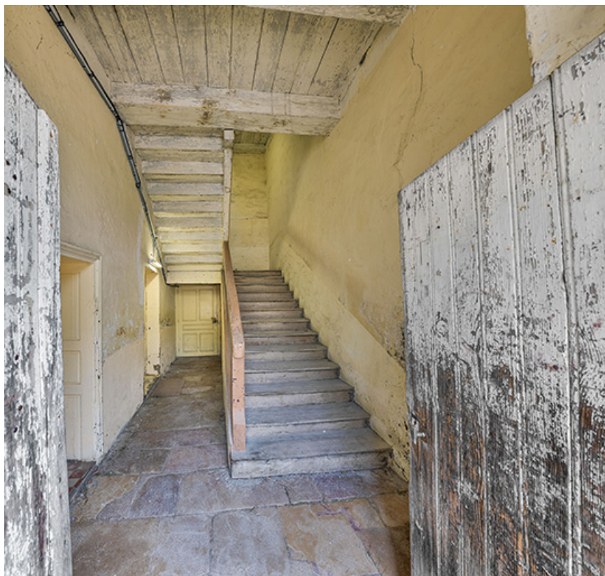
Caserne Vauban : cage d'escalier au rez-de-chaussée.
