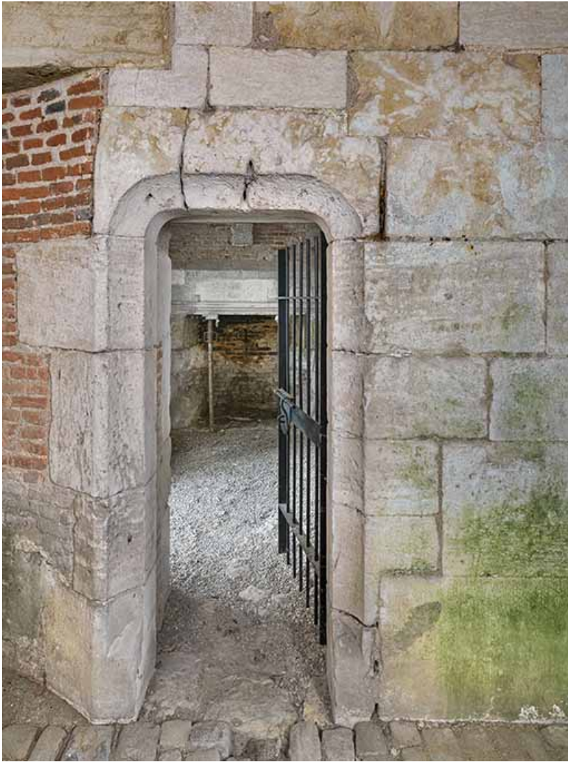
Pavillon d'entrée : entrée du corps de garde.
