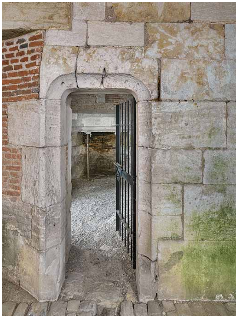
Pavillon d'entrée : entrée du corps de garde.
