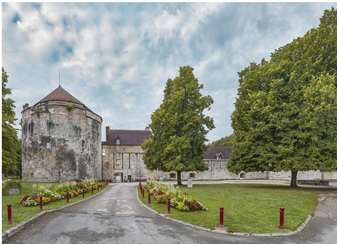
Entrée principale du château : vue d'ensemble.
