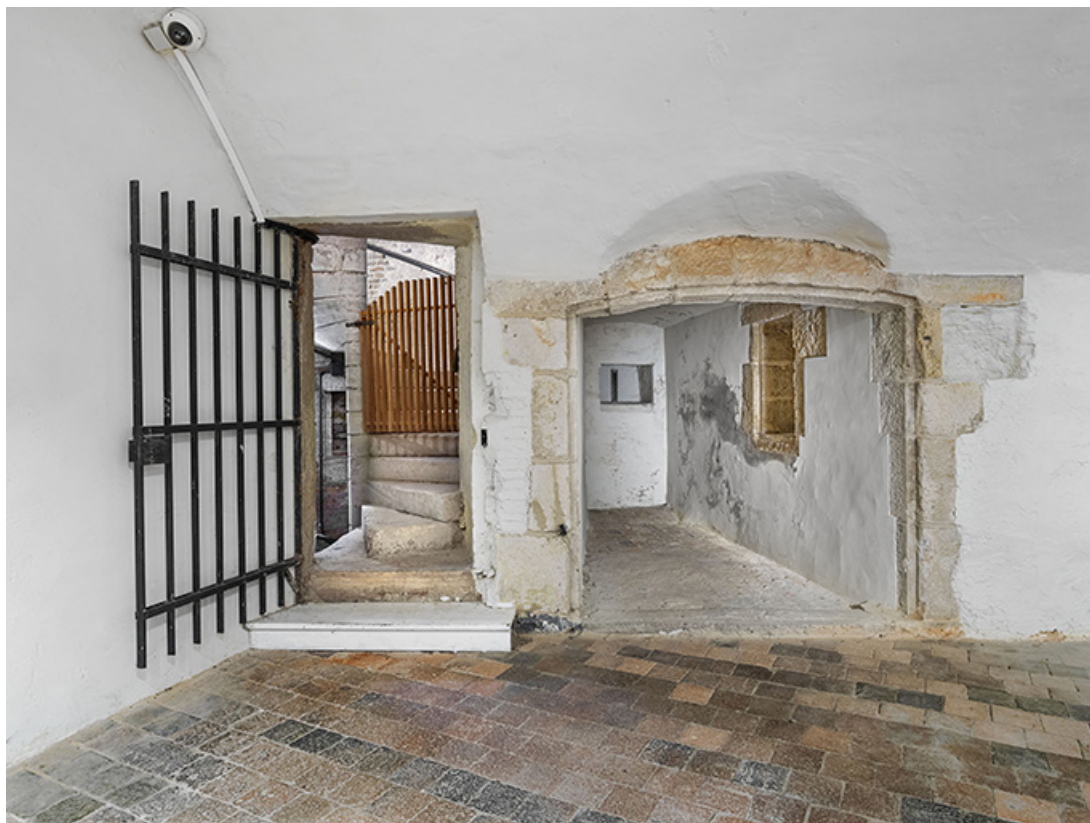
Tour Notre-Dame : porte d'accès au premier niveau.
