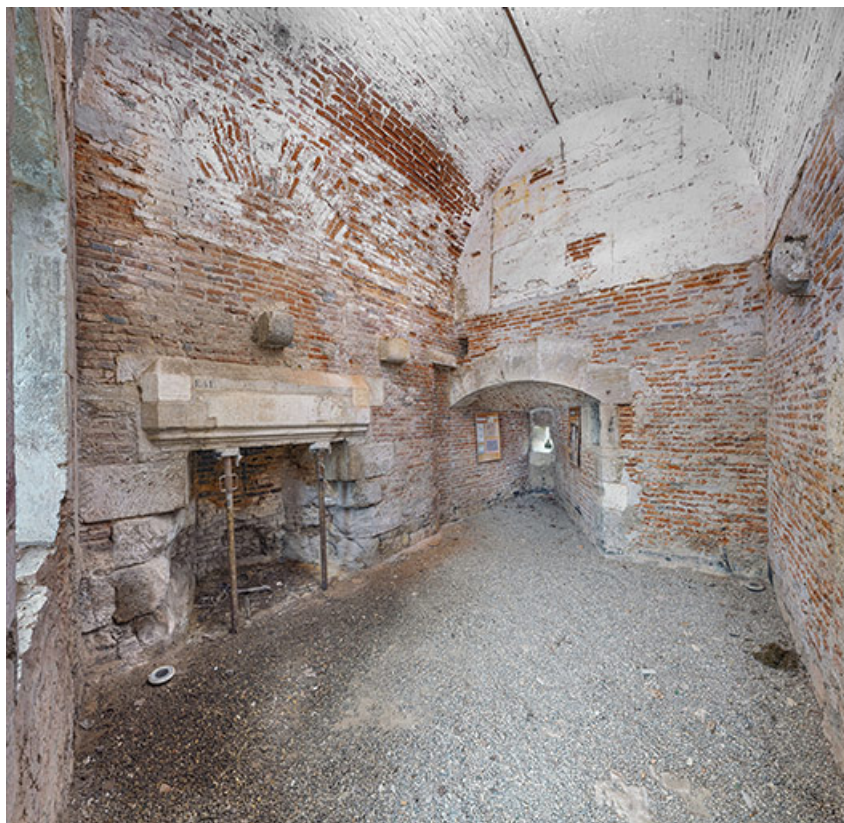
Pavillon d'entrée et son corps de garde : vue d'ensemble.
