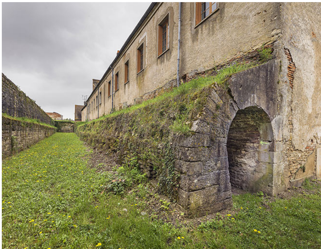
La galerie voûtée reliant la tour basse des Moulins au bastion de la tour Beauegard.
