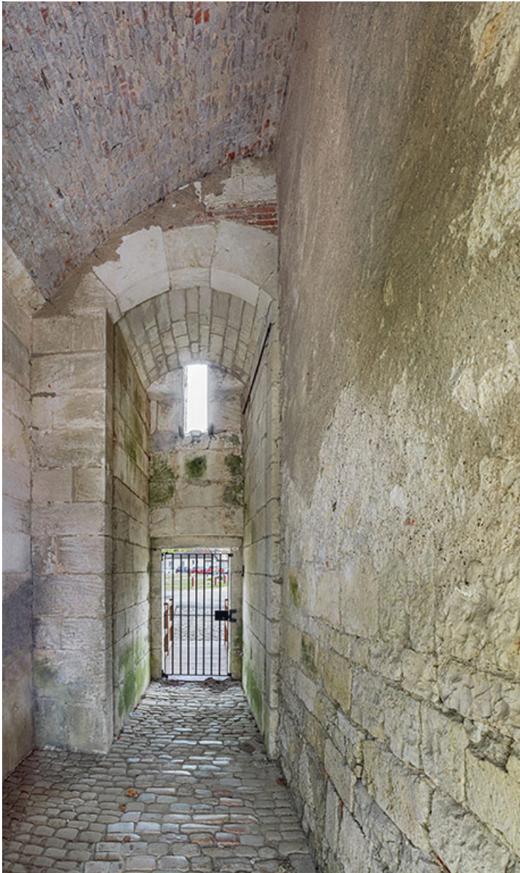
Pavillon d'entrée : passage piéton.
