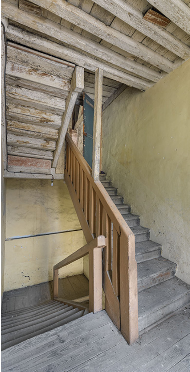
Caserne Vauban : cage d'escalier au 1er étage.
