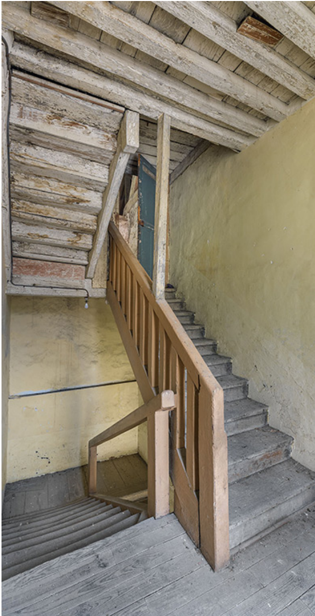
Caserne Vauban : cage d'escalier au 1er étage.
