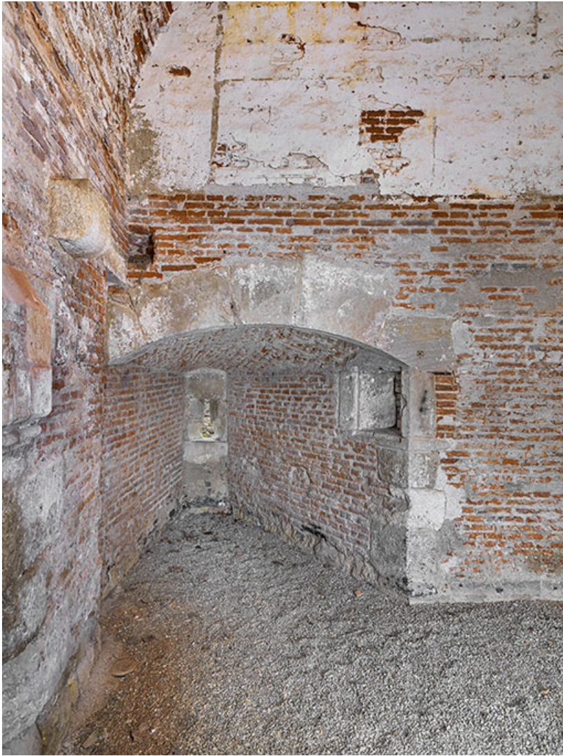
Pavillon d'entrée : poste de garde et de tir du corps de garde.
