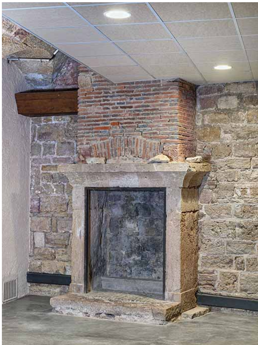
Tour Beauregard : cheminée, rez-de-chaussée. 21, Auxonne, 1 rue du Château
