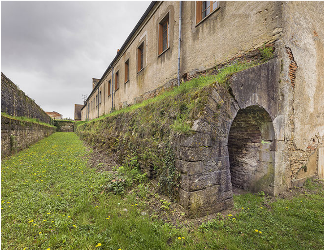
La galerie voûtée reliant la tour basse des Moulins au bastion de la tour Beauegard. 21, Auxonne, 1 rue du Château
