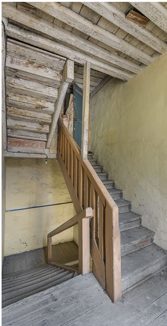
Caserne Vauban : cage d'escalier au 1er étage.
