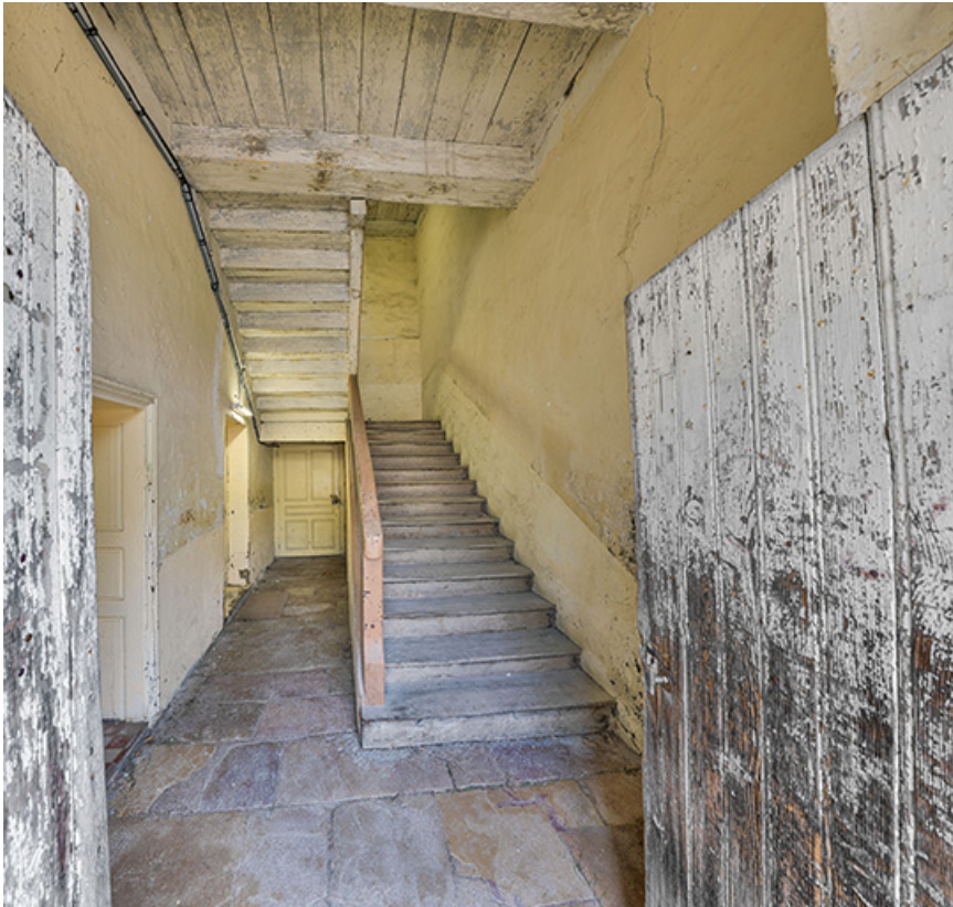
Caserne Vauban : cage d'escalier au rez-de-chaussée.
