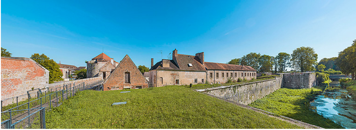
Vue depuis le terre-plein de la tour basse des Moulins.
