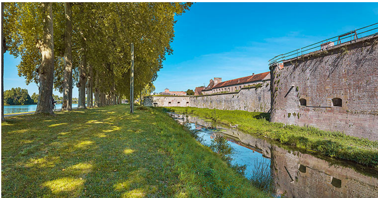
Le front ouest du château. Au premier plan, la tour Beauregard transformée en bastion au 19e siècle. 21, Auxonne, 1 rue du Château
