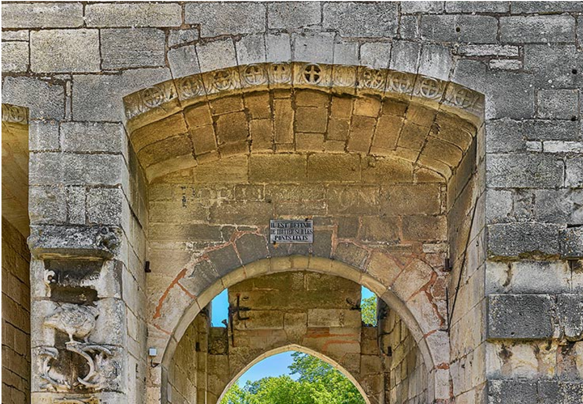
Voûte de la partie cochère du passage de la porte.
