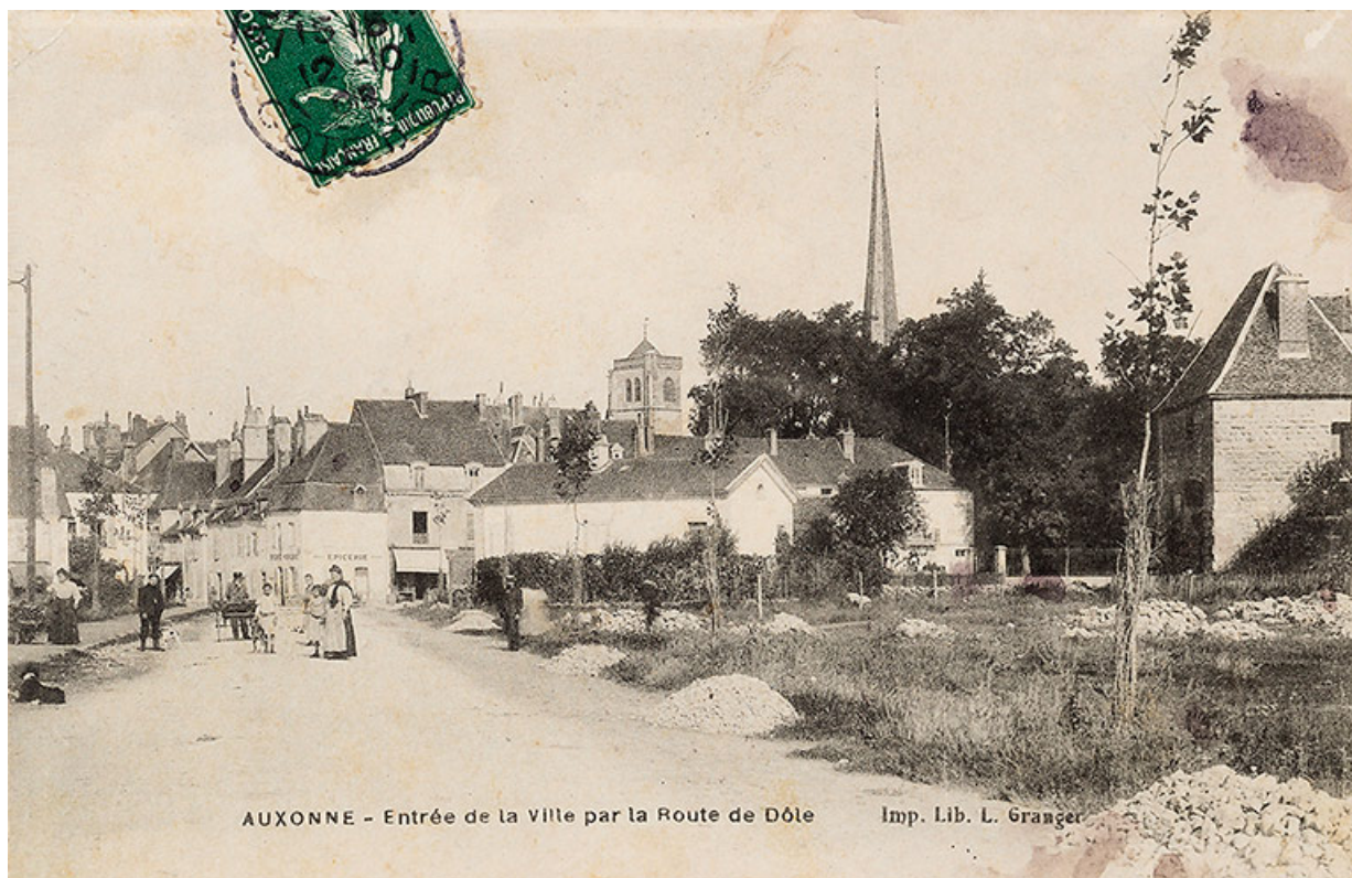
Auxonne - Entrée de la ville par la route de Dole. S.d.
