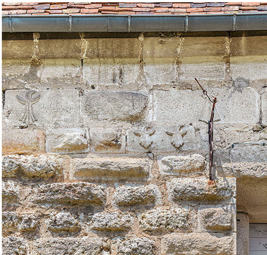
La maçonnerie en bossage de la porte.
