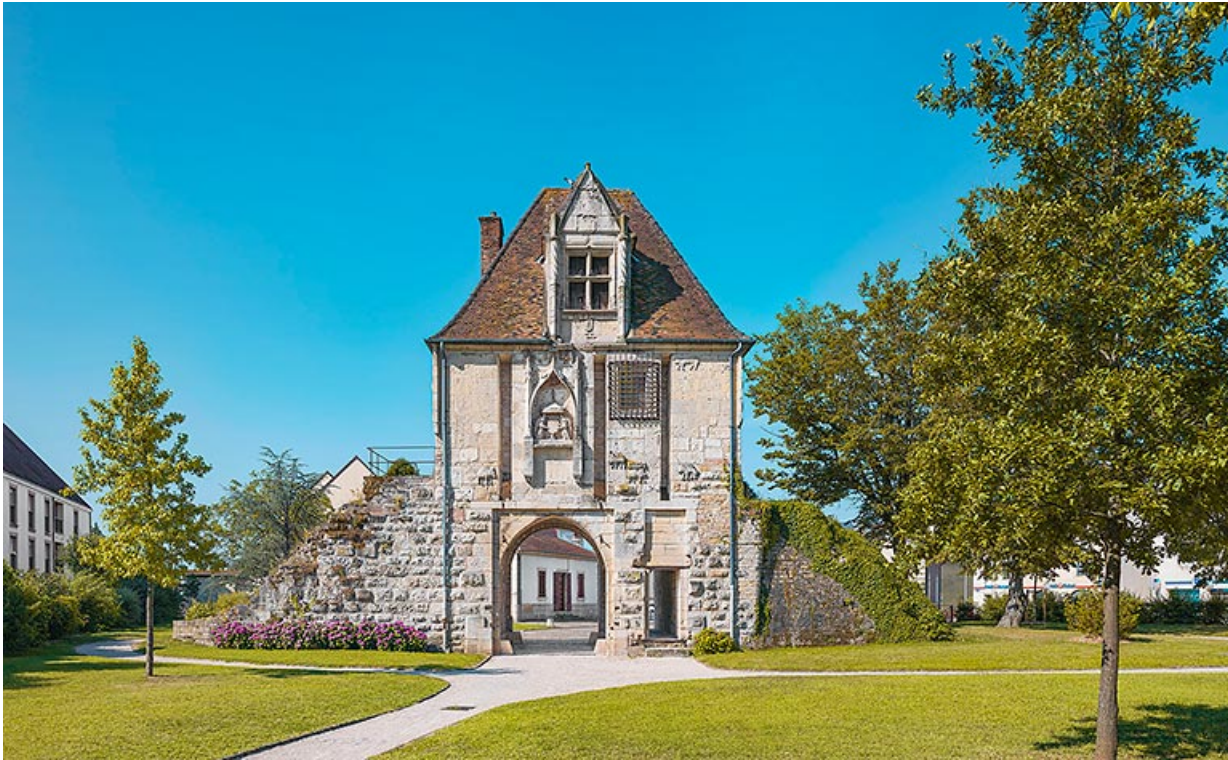
La porte entourée des vestiges des murs du flanc gauche du bastion.
