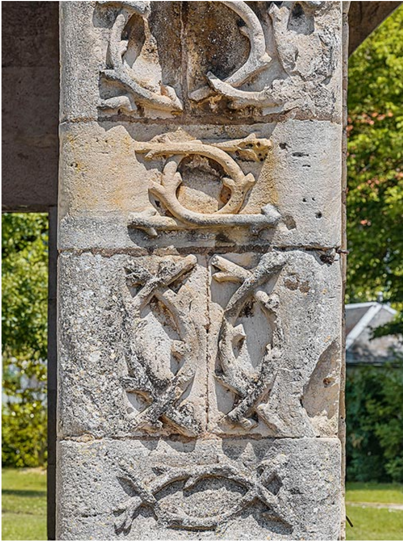
Trumeau séparant le passage cocher et piéton de la porte.
