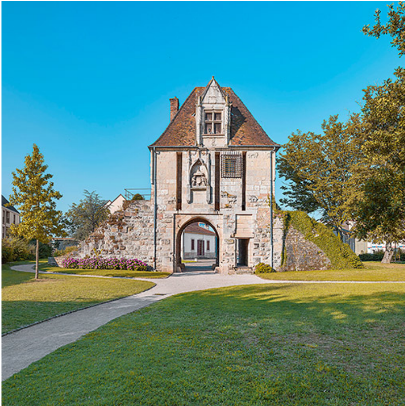
Vue générale de la façade côté campagne.
