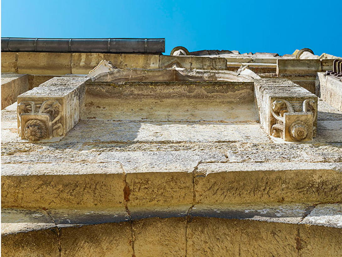
Base des piliers supportant les pinacles.
