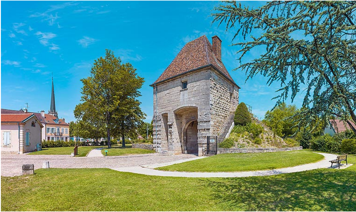
La porte côté ville : vue de trois quarts droite. 21, Auxonne boulevard Pasteur
