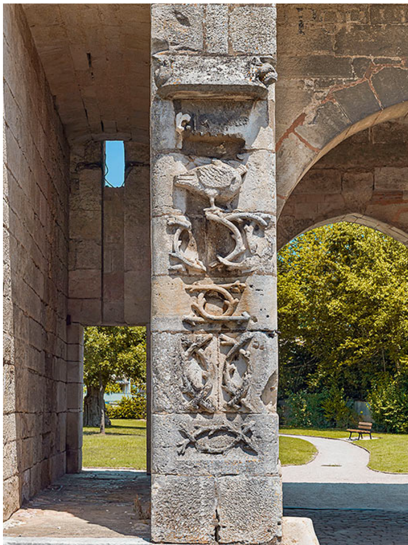
Pilier séparant les parties piétonne et cochère de la porte, côté ville. 21, Auxonne boulevard Pasteur
