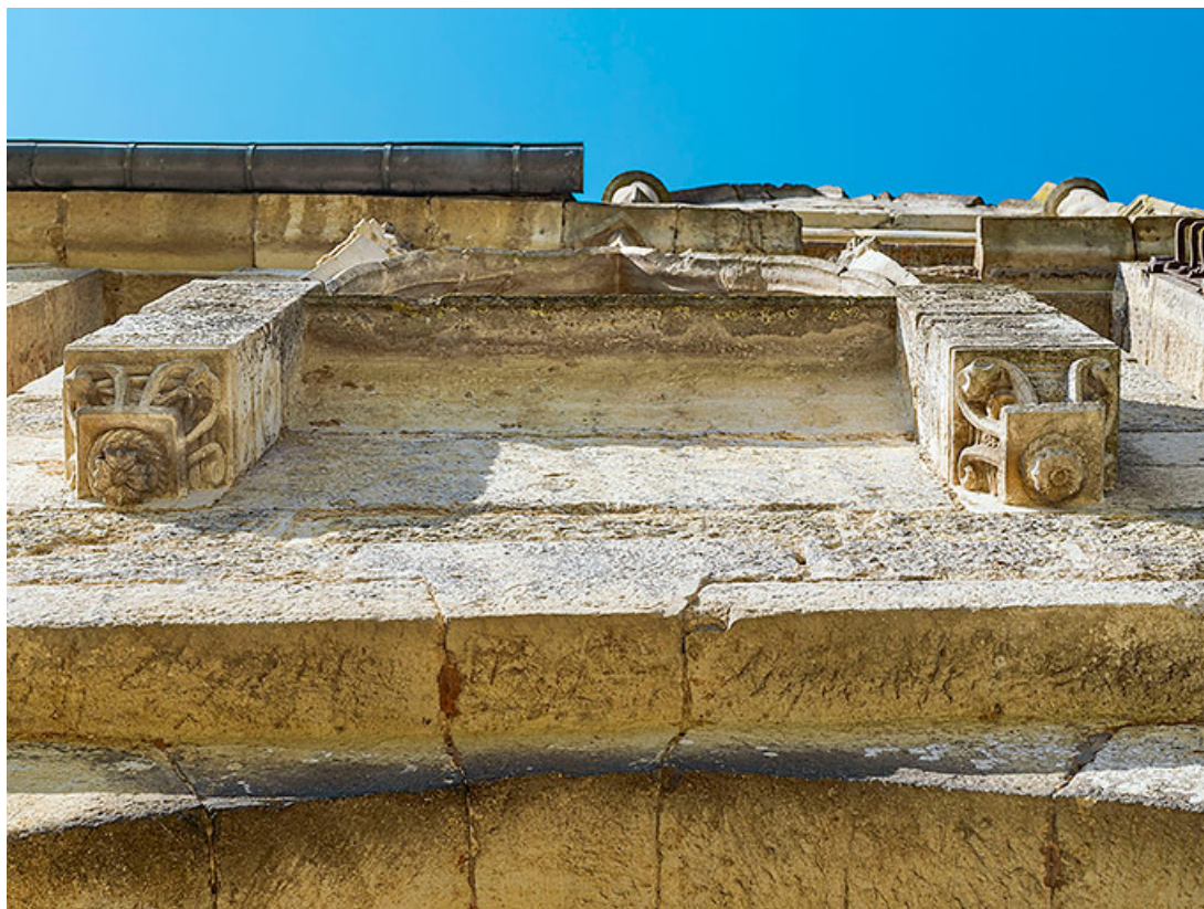
Base des piliers supportant les pinacles.
