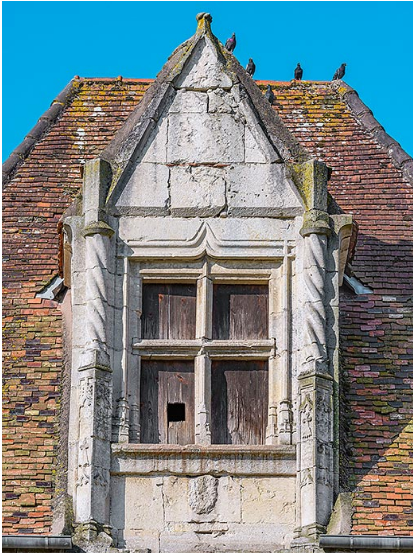
Vue de la baie à meneau.
