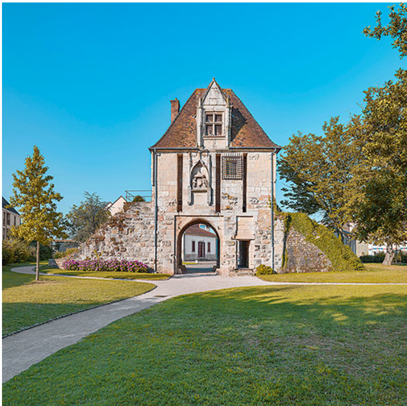
Vue générale de la façade côté campagne.
