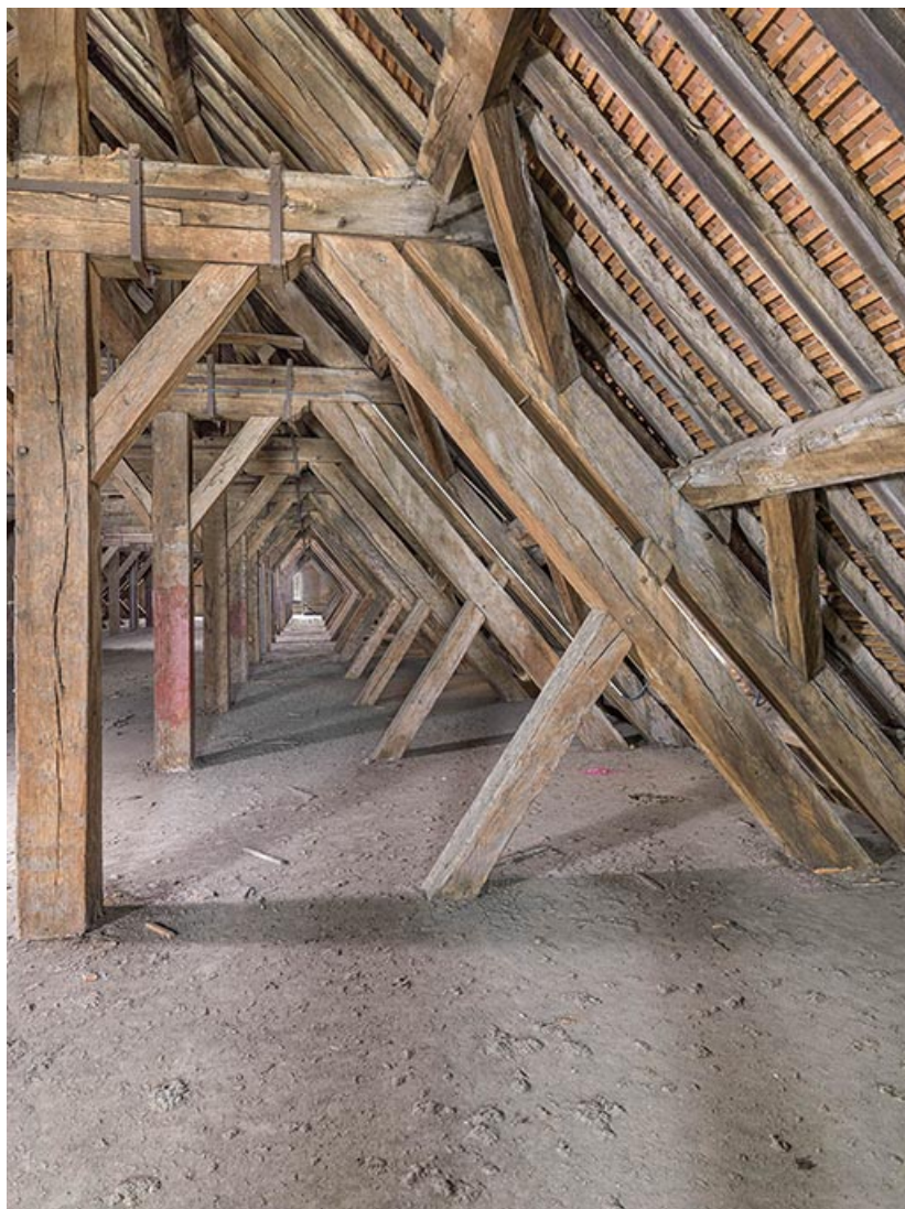
Détail de la charpente à chevrons-portant-fermes.
