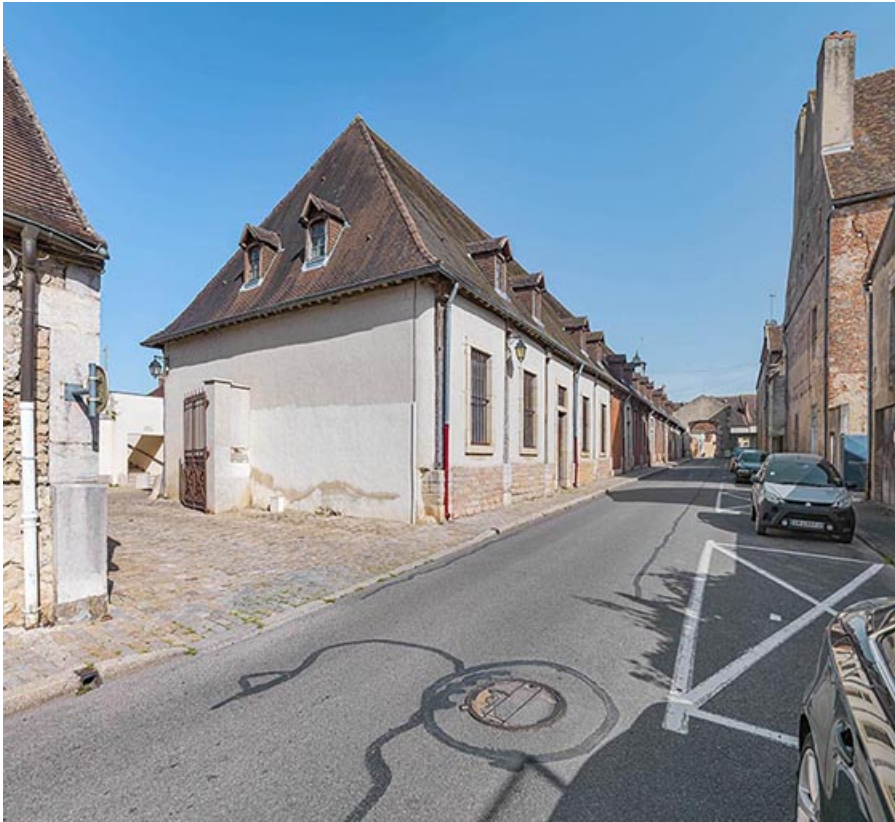
Le hangar depuis la rue des Halles.
