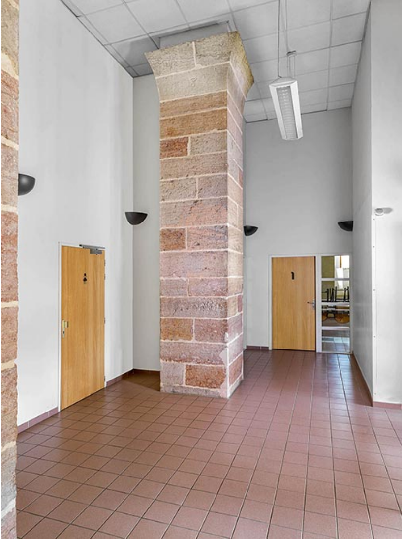
Détail d'un des piliers. 21, Auxonne rue des Halles
