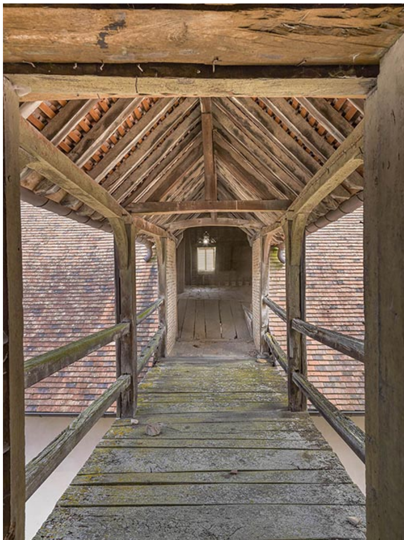
Passerelle reliant les grandes halles aux grandes forges.
