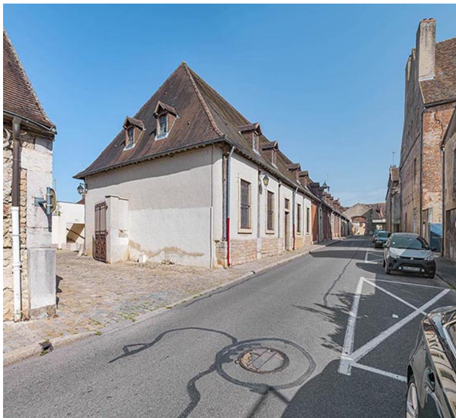
Le hangar depuis la rue des Halles.
