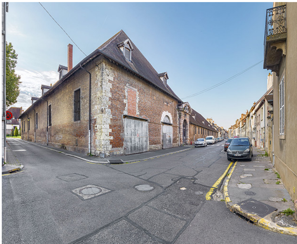
Les grandes forges depuis la rue Vauban. 21, Auxonne rue des Halles
