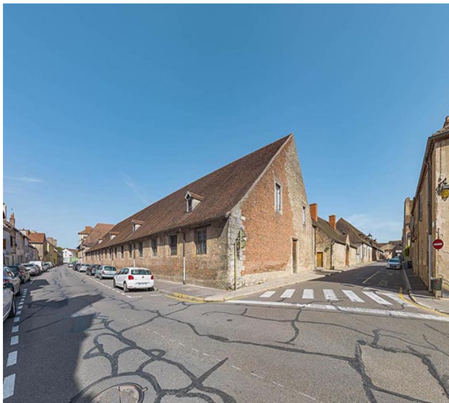
Les grandes halles depuis la rue Vauban.
