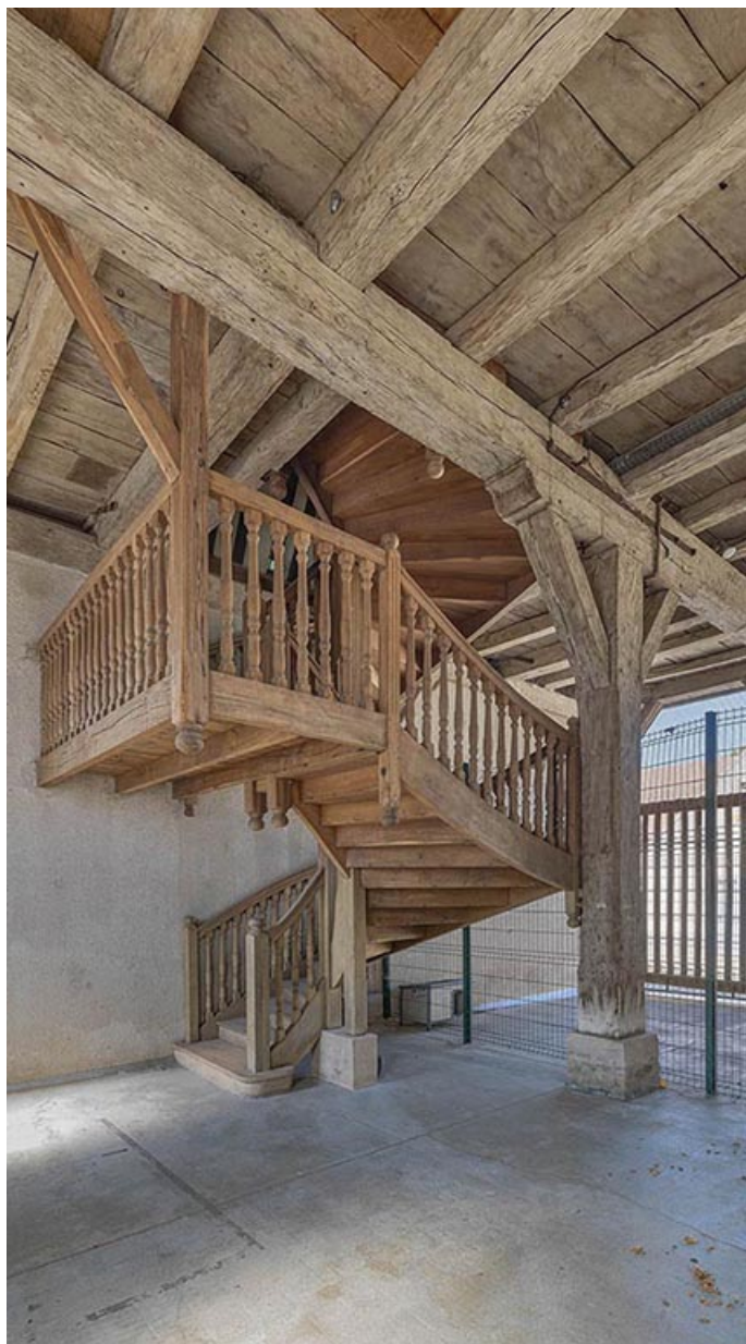
Escalier desservant l'étage supérieur du hangar.
