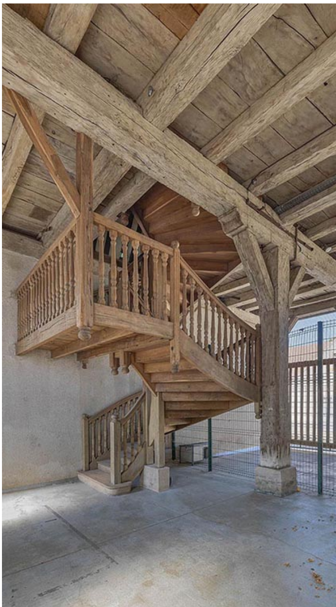
Escalier desservant l'étage supérieur du hangar.
