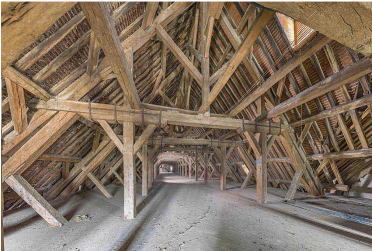
Charpente des grandes halles.
