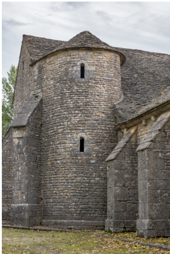
Tourelle d'escalier côté nord.
