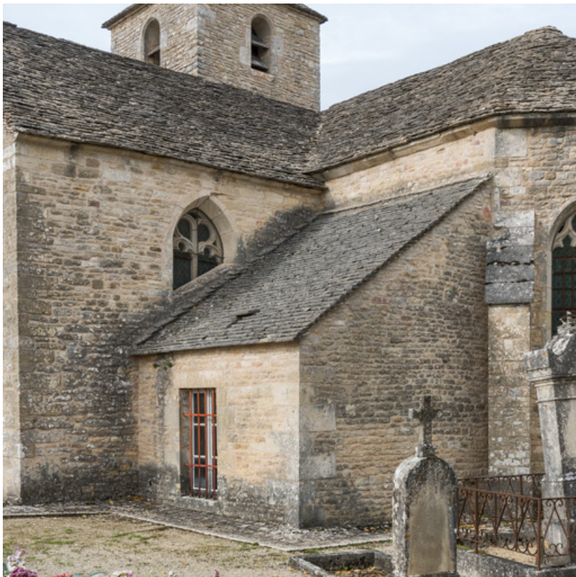
Détail de la toiture côté nord.
