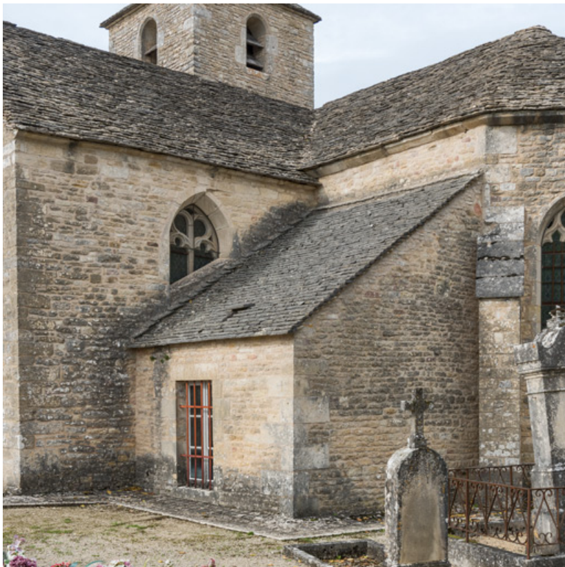
Détail de la toiture côté nord.
