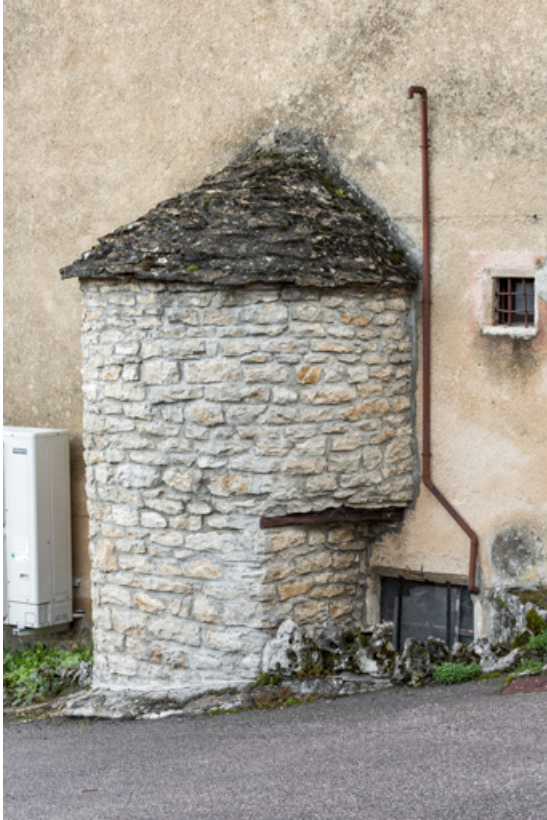
Vue du four à pain côté sud-ouest.
