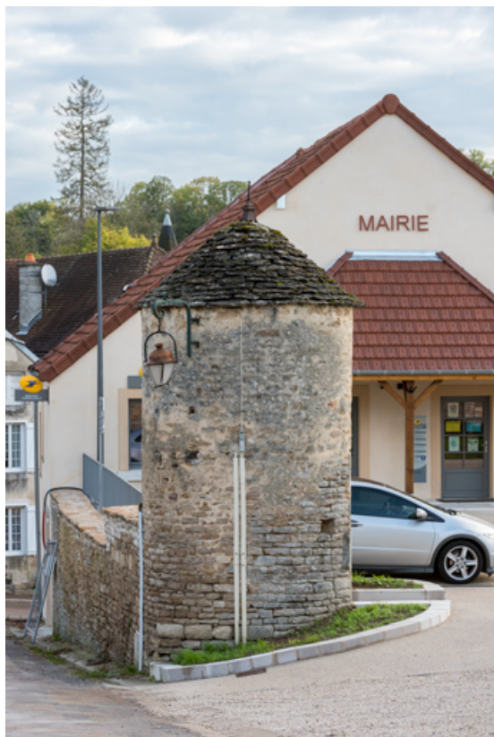
Vue d'ensemble côté ouest.
