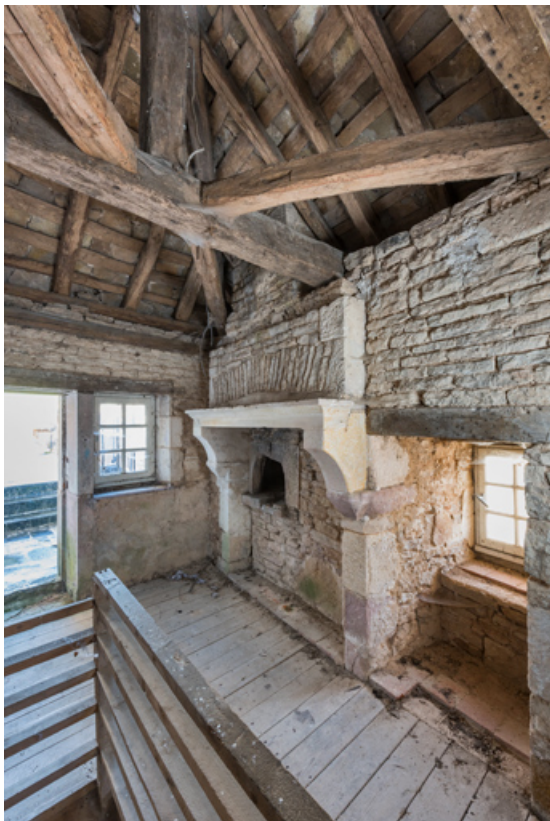
Vue intérieure de la cheminée.
