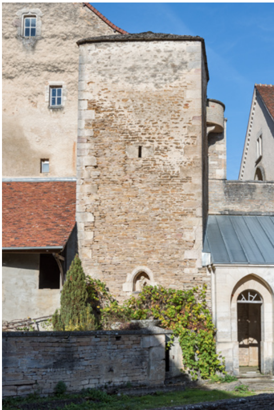
Vue de la façade nord-ouest.
