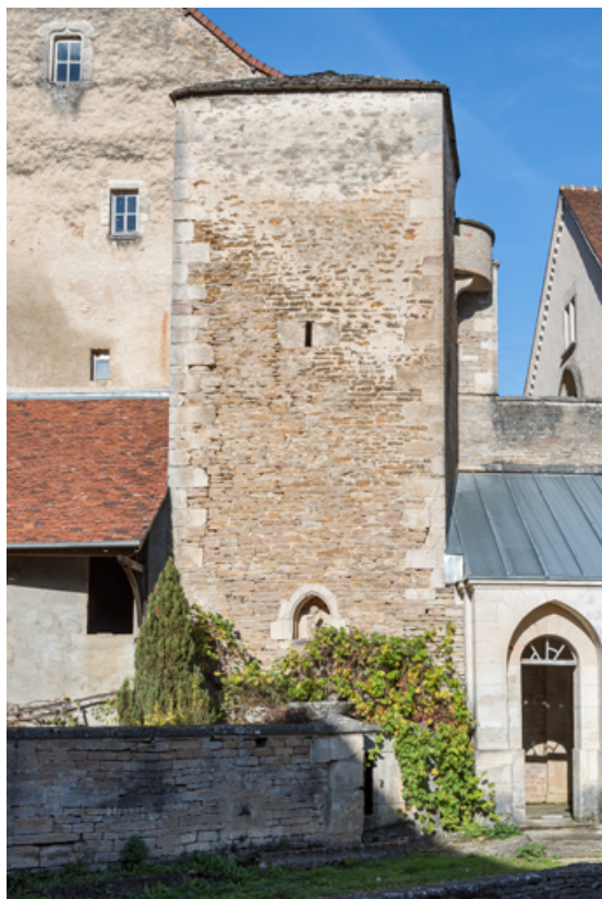
Vue de la façade nord-ouest.
