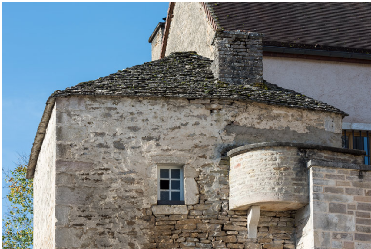
Vue de la toiture depuis l'ouest.
