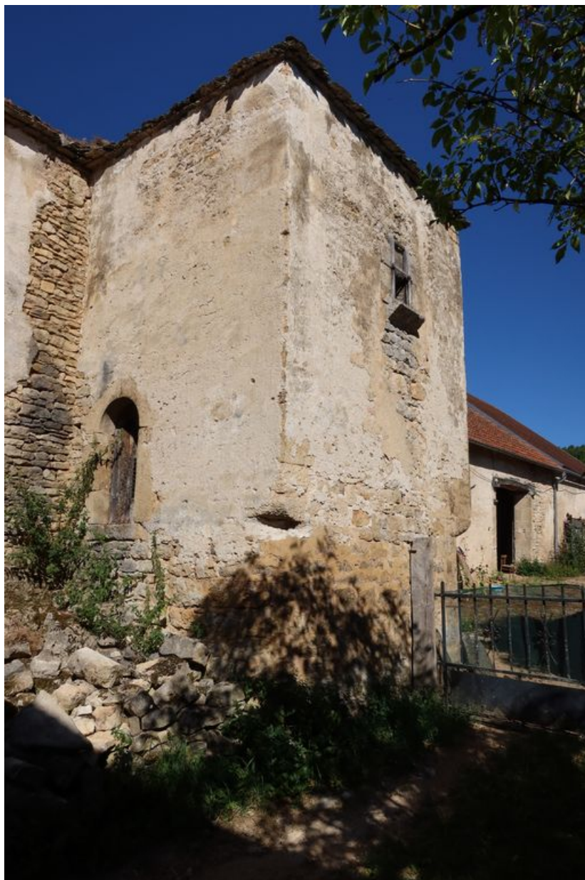
Détail du pigeonnier depuis le sud-est. 21, Bure-les-Templiers, 1 rue de Champey
