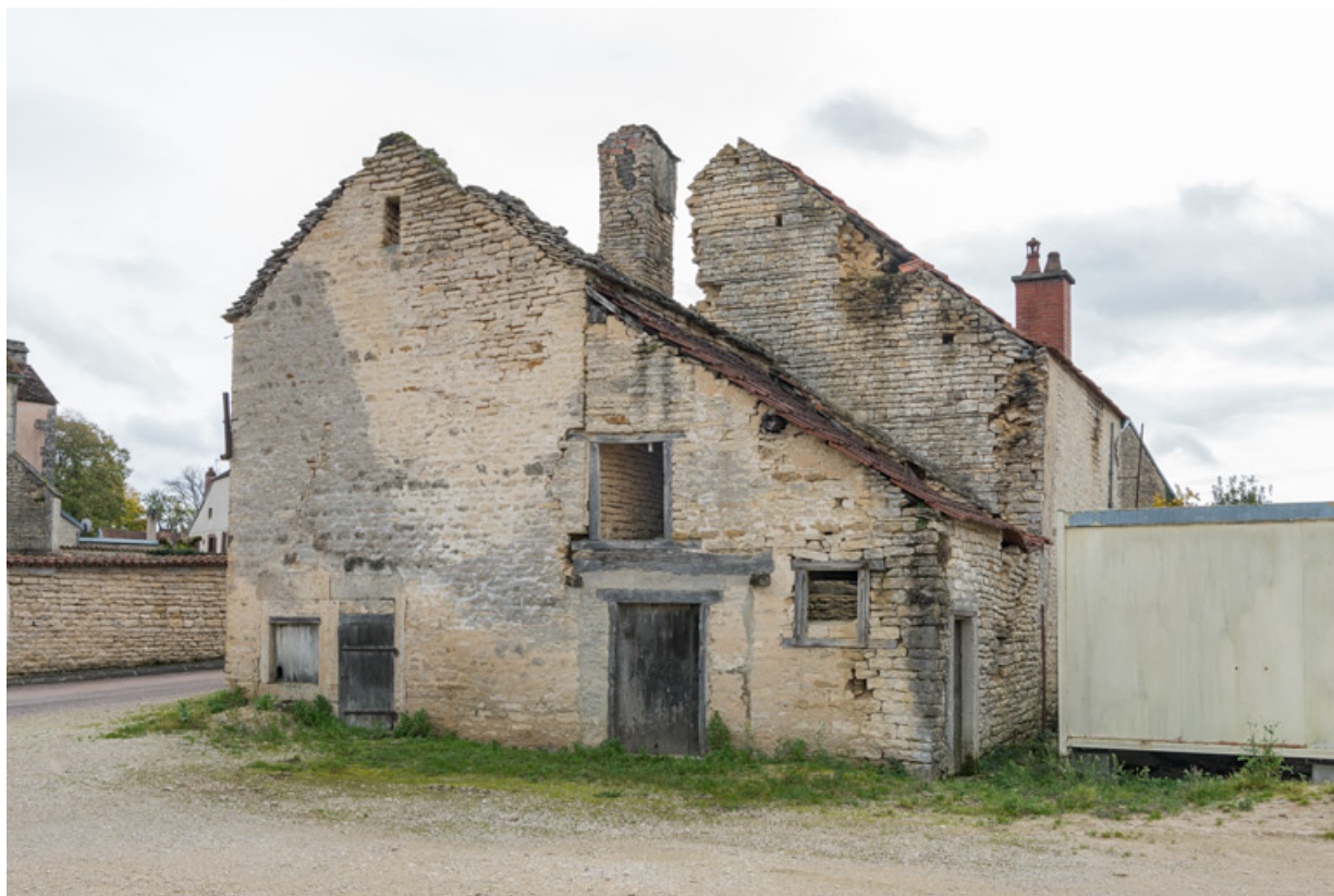
Vue du mur pignon sud.
