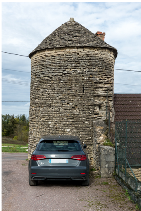
Vue de la tour depuis le sud.
