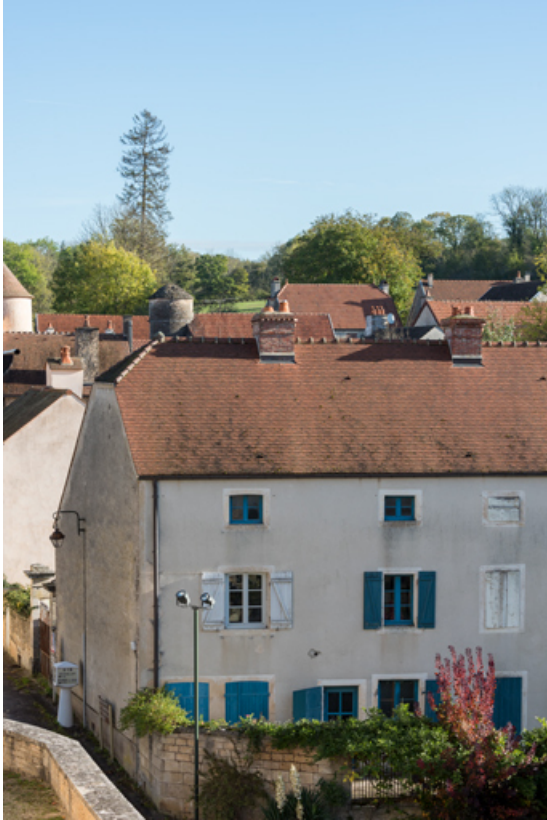
Vue de la tour depuis l'ouest.
