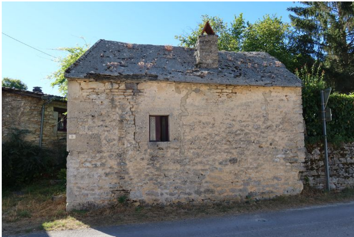
Vue de la façade depuis le nord-est.
