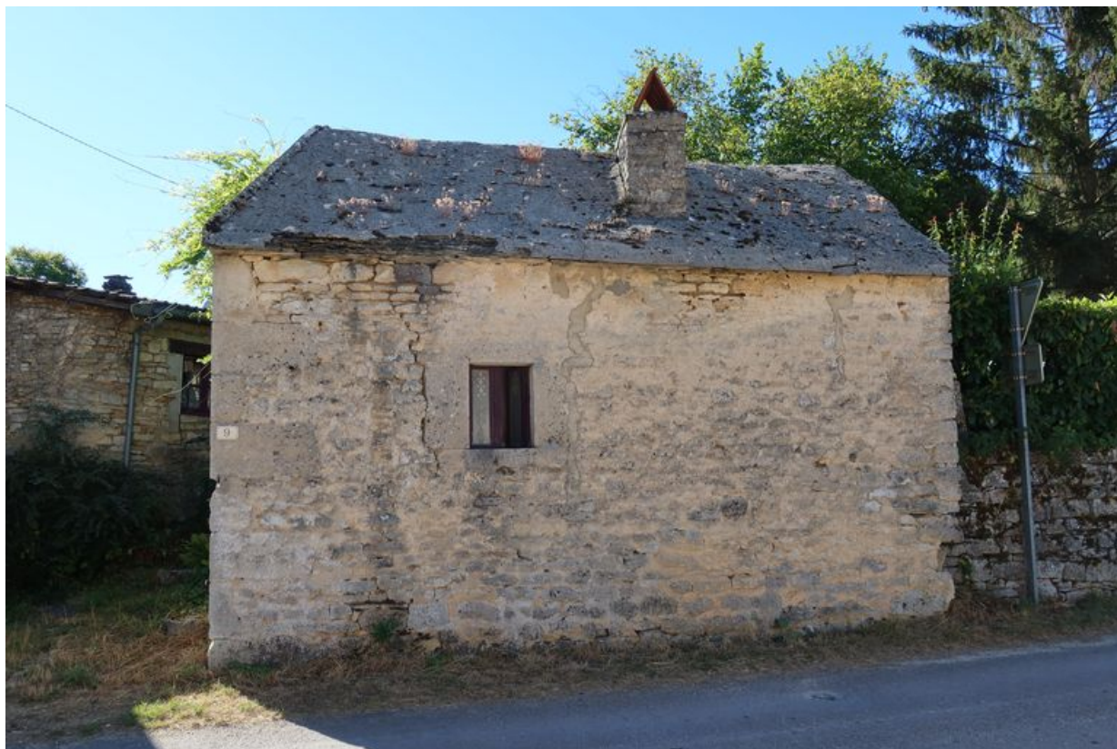
Vue de la façade depuis le nord-est.
