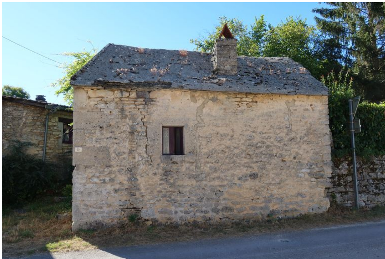
Vue de la façade depuis le nord-est.
