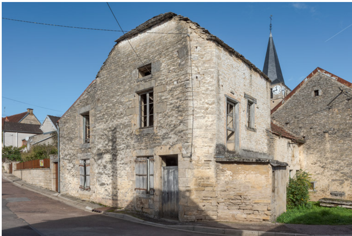
Vue d'ensemble depuis l'angle sud-est.
