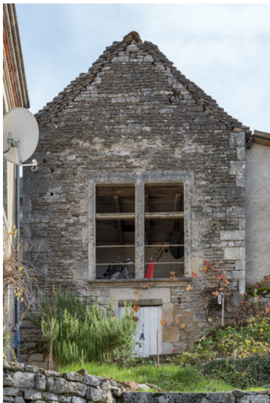
Vue du mur pignon nord.
