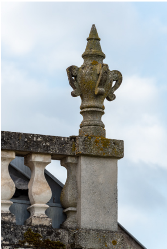
Élévation latérale droite : motif d'amortissement.
