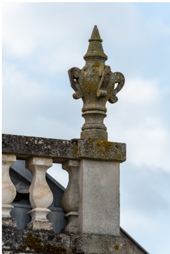
Élévation latérale droite : motif d'amortissement.
