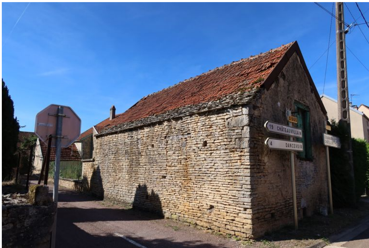
Vue d'ensemble de la remise depuis le nord-est.
