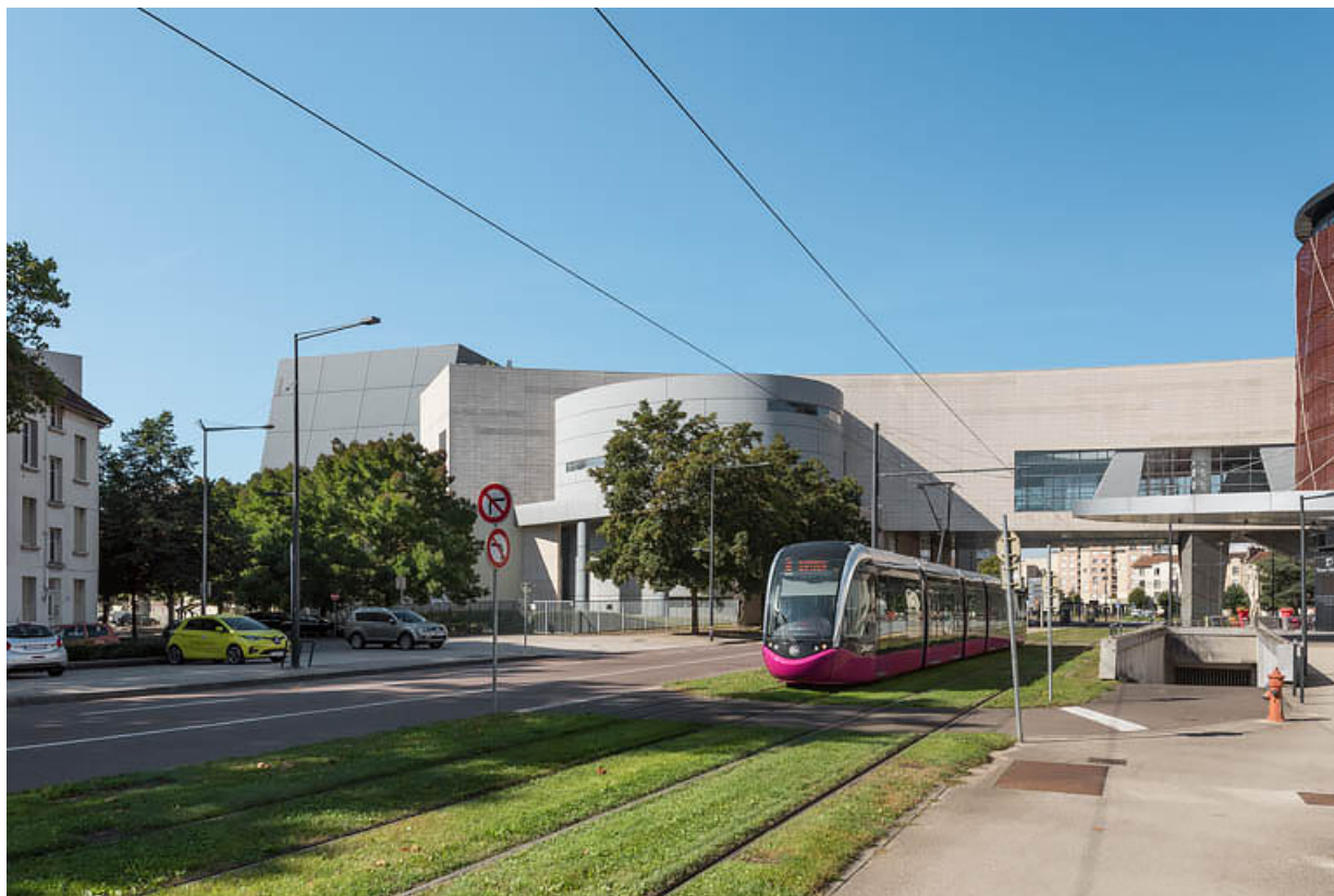
Vue d'ensemble depuis l'est, avec tramway. 21, Dijon
