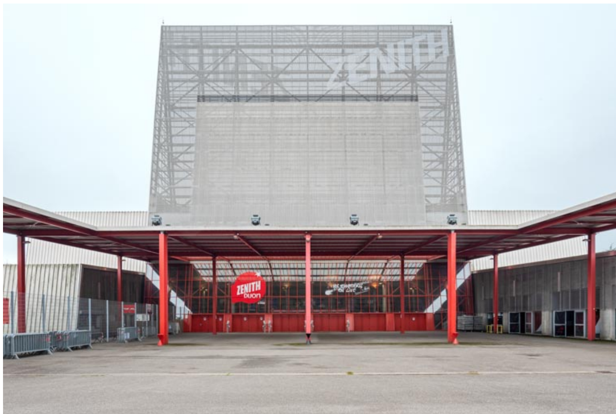
Corps principal, avec portiques et façade-écran. 21, Dijon
