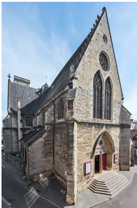
Façade occidentale, de trois quarts gauche.
