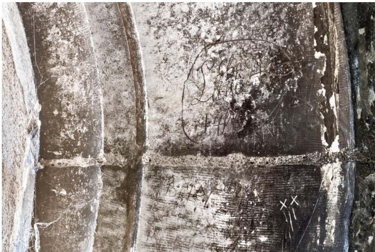
Comble, graffitis gravés : Charles Lagout [?] 1863 et Delanraut Lucien. 21, Dijon, 15 rue Danton
