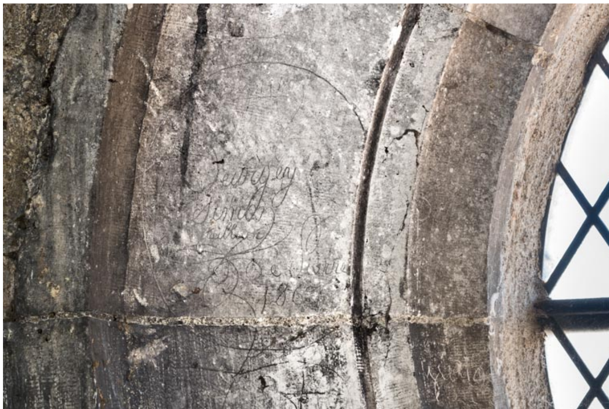
Comble, graffiti gravé : Deurgey Simon, tailleur de pierre, 1863. 21, Dijon, 15 rue Danton
