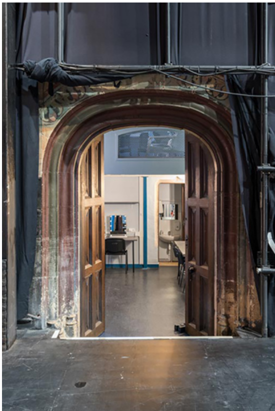
Tour nord, rez-de-chaussée : accès à la loge d'acteur côté jardin. 21, Dijon, 15 rue Danton
