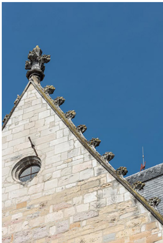
Façade orientale : pignon avec amortissement et crochets.
