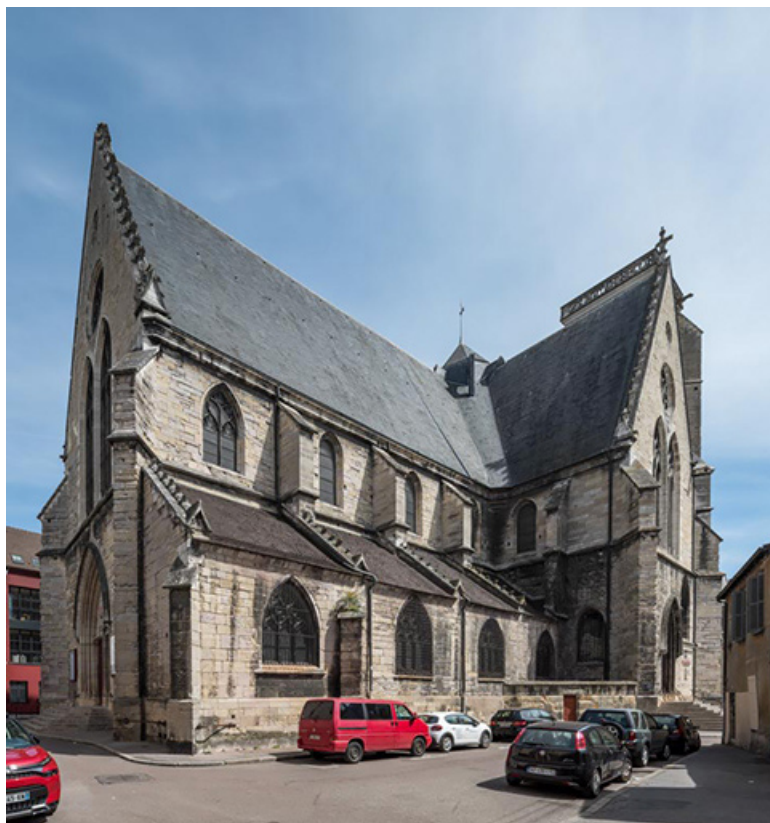
Façade sud, de trois quarts gauche.
