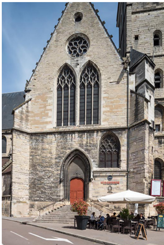
Façade sud : extrémité du transept.
