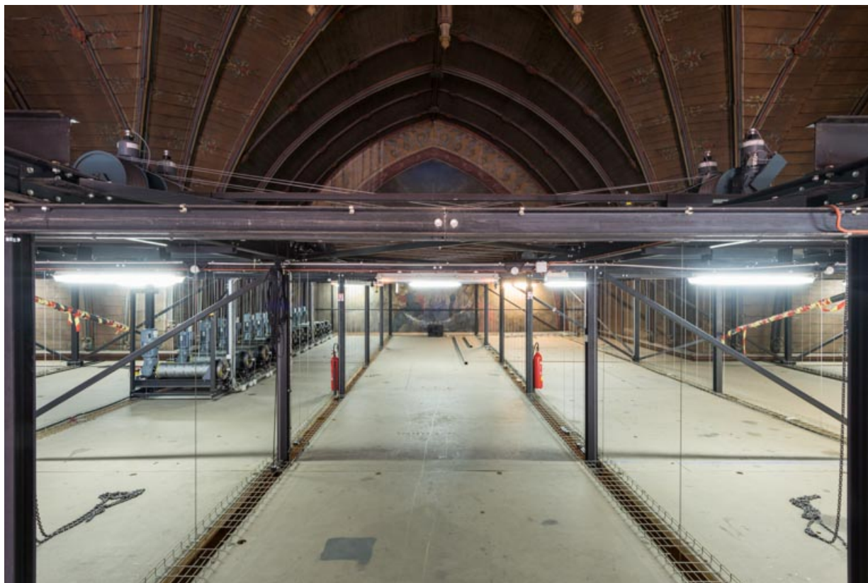
Croisée du transept : cintres du théâtre. Vue prise en direction du chevet oriental. Le décor peint est partiellement visible. 21, Dijon, 15 rue Danton
