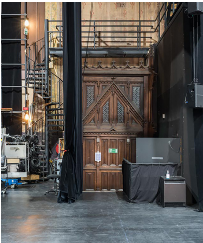
Théâtre : coulisse côté cour (sud), avec porte du transept et accès aux passerelles. 21, Dijon, 15 rue Danton
