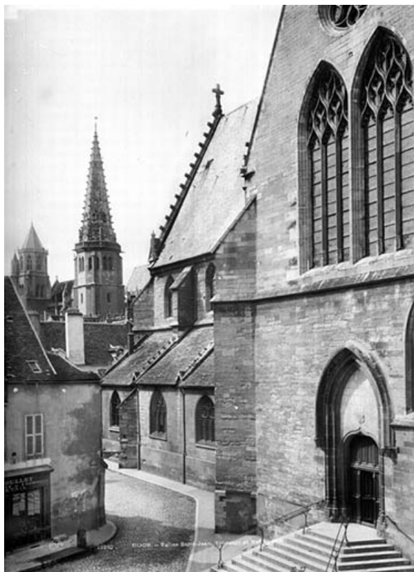
Façade sud : transept et partie ouest. 1905. 21, Dijon, 15 rue Danton
