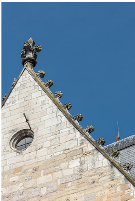
Façade orientale : pignon avec amortissement et crochets.
