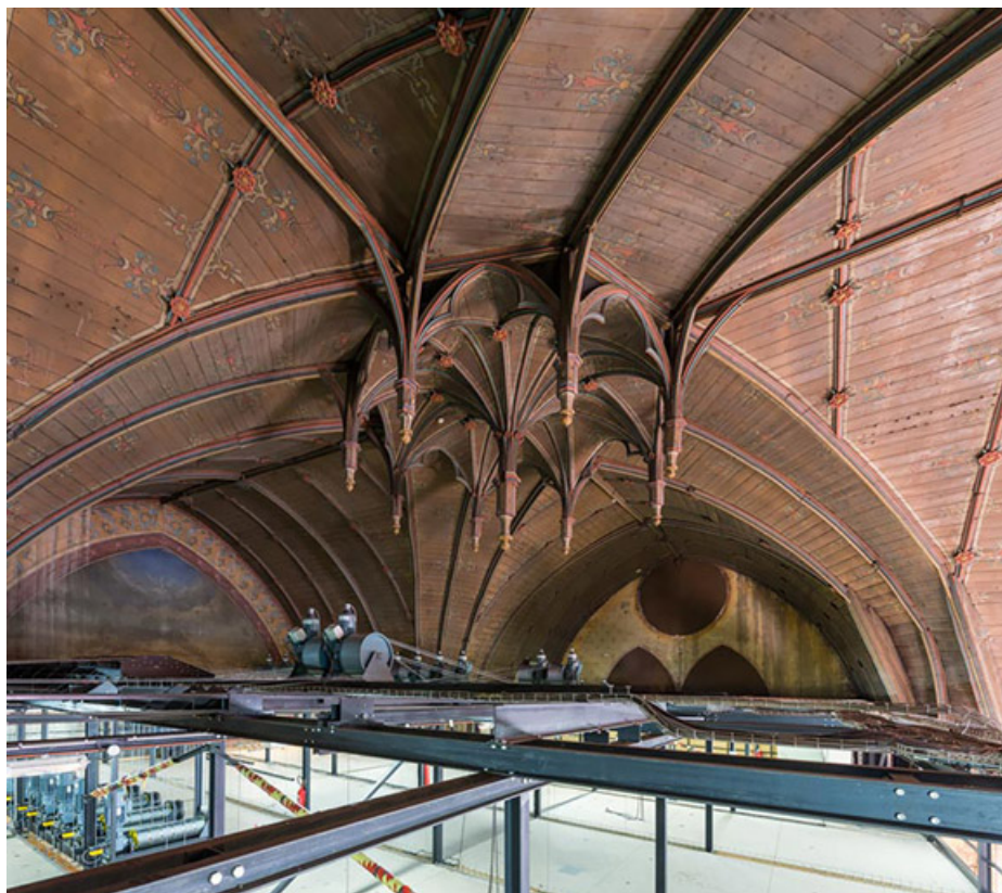
Croisée du transept : charpente lambrissée.
