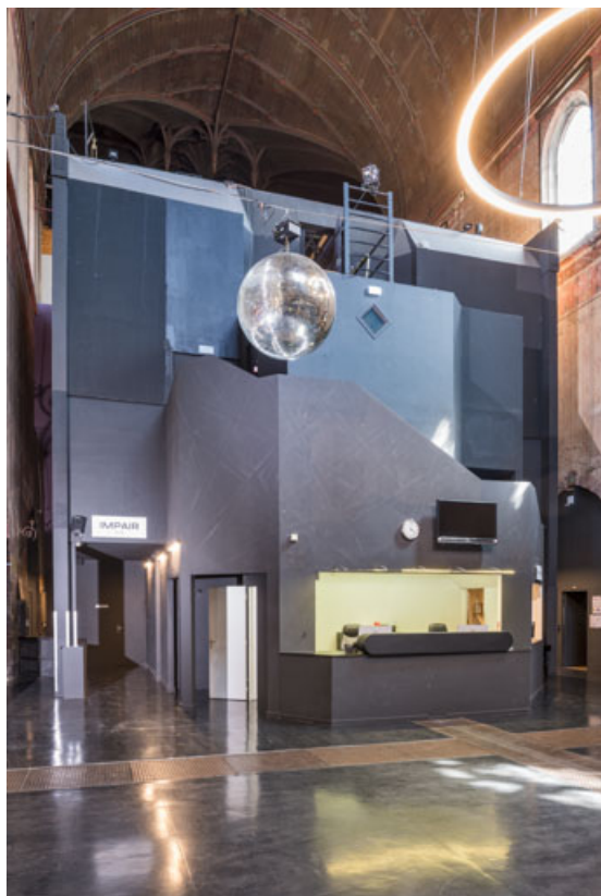
Entrée de la nef, avec la billetterie du théâtre, vue de trois quarts. Le concept de "boîte dans la boîte" est clairement lisible. 21, Dijon, 15 rue Danton
