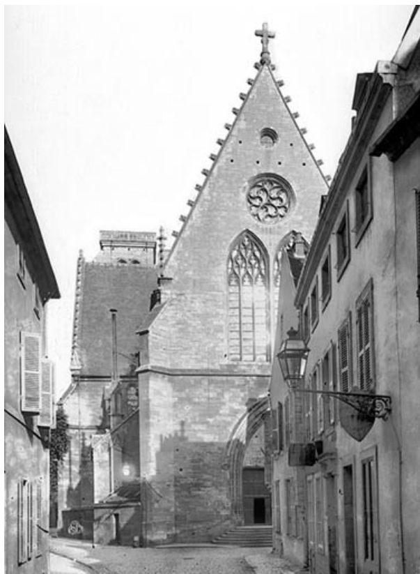
Ensemble ouest [façade antérieure, depuis la rue Danton]. 1905. 21, Dijon, 15 rue Danton
