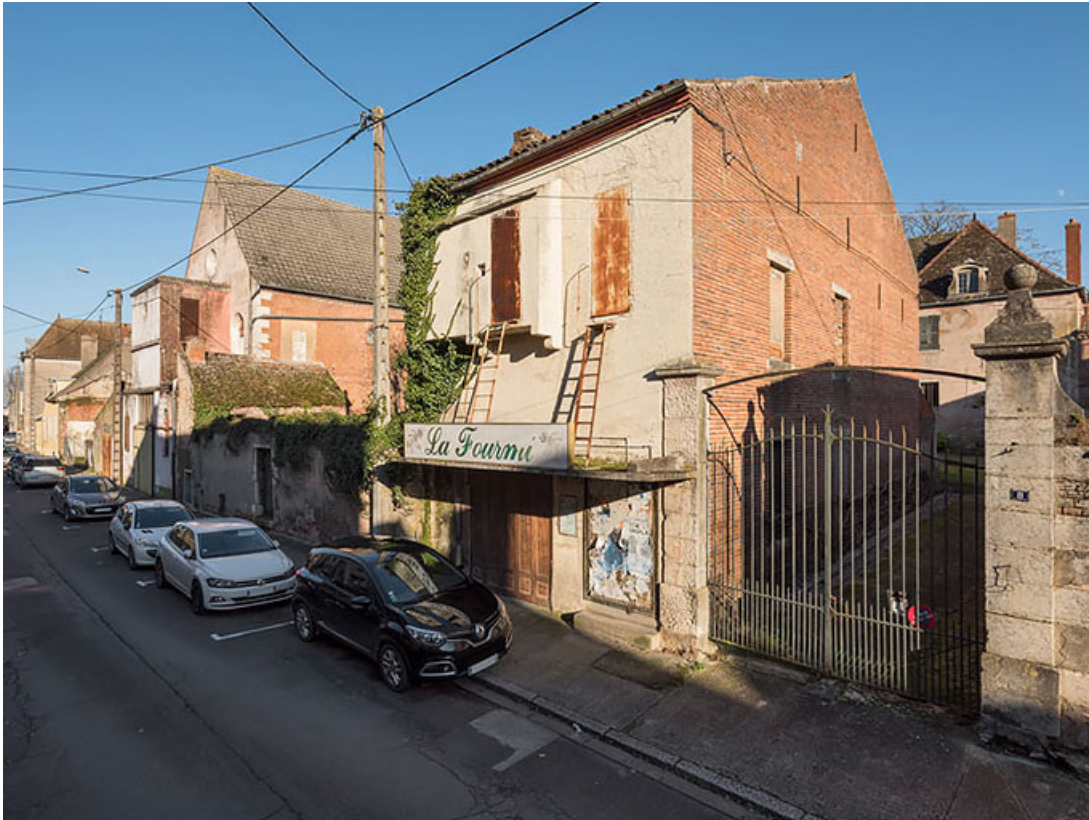
Vue d'ensemble, depuis le sud. La salle dite des Capucines est visible au second plan. 21, Seurre, 10 rue des Lombards
