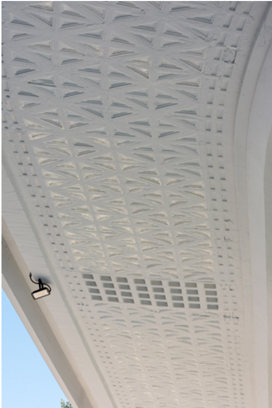
Face inférieure de l'auvent en béton armé.
