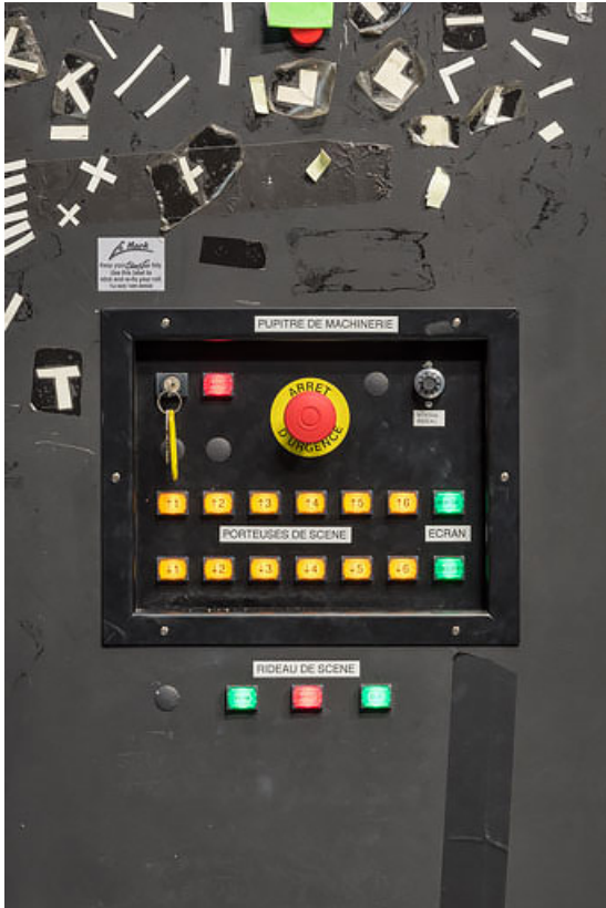
Pupitre de commande de la machinerie.
