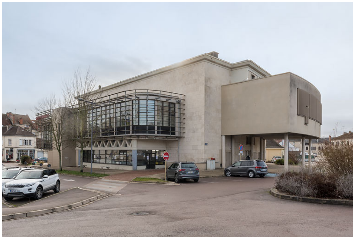
Façades postérieure et latérale gauche. 21, Châtillon-sur-Seine place du 8 Mai
