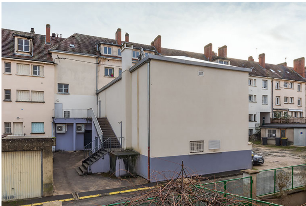
Façade postérieure, avec la salle 1 au 1er plan.
