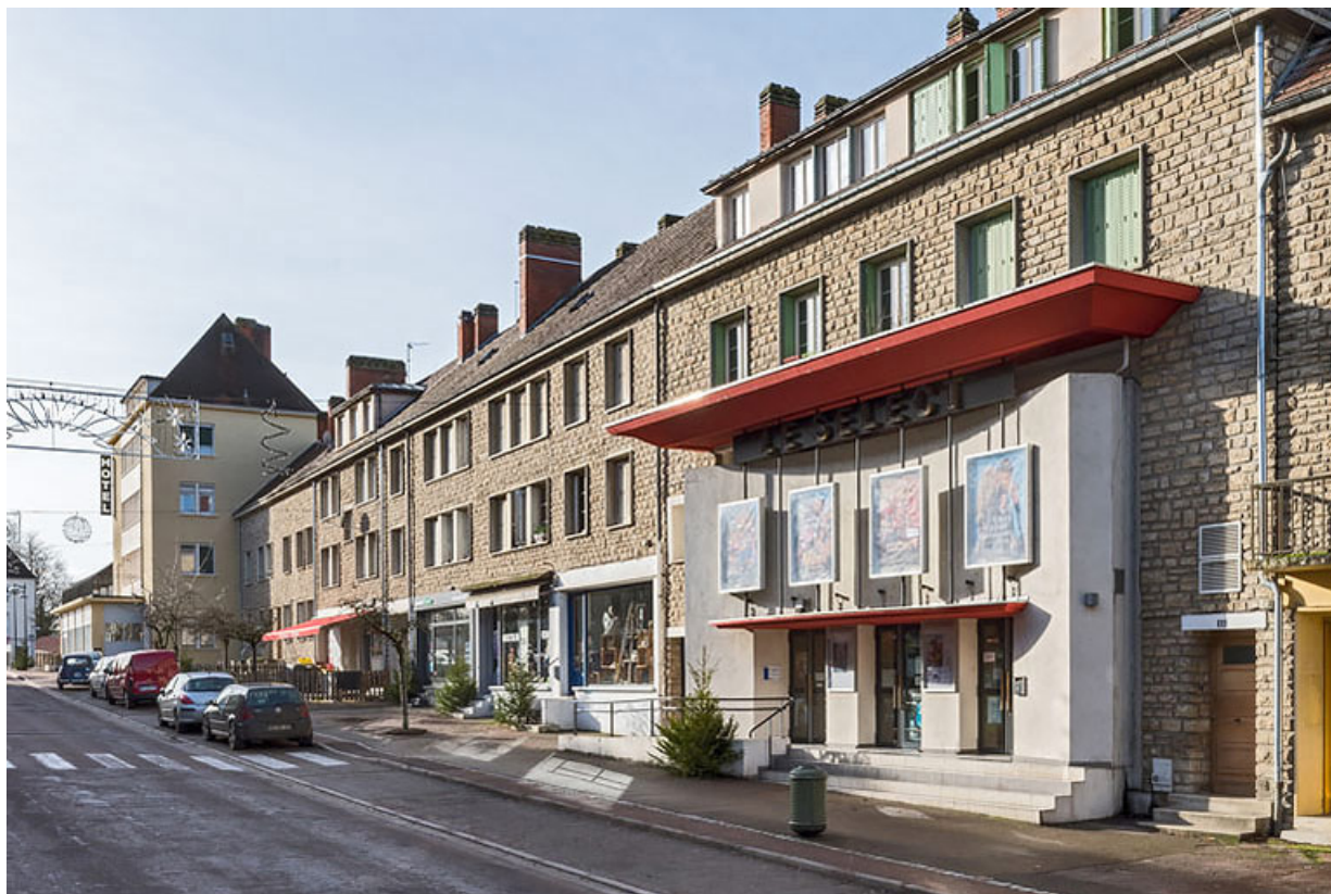
Vue d'ensemble, dans la rue du Maréchal de Lattre. 21, Châtillon-sur-Seine, 46 rue du Maréchal de Lattre
