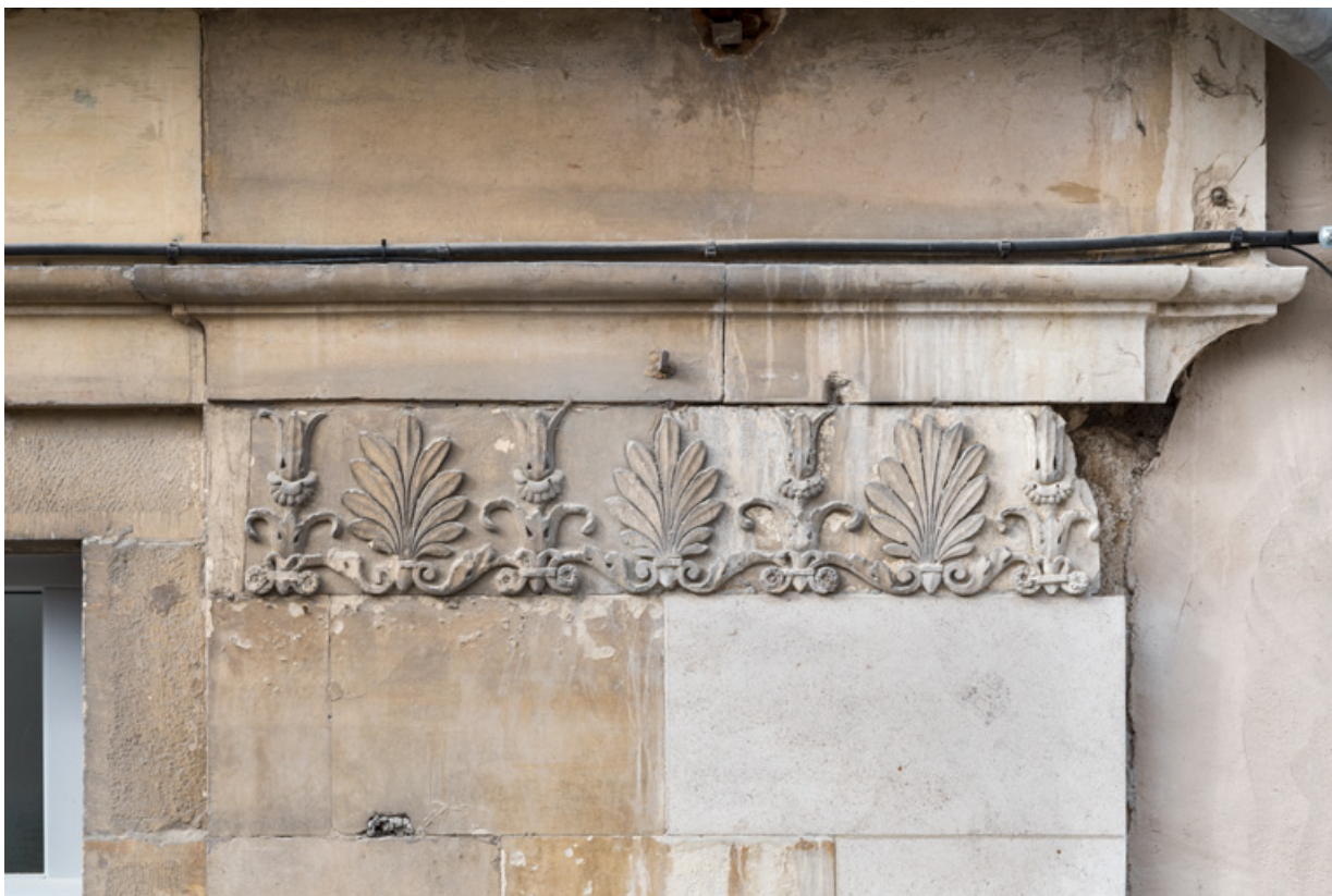
Façade antérieure, 7e et dernier pilastre (à droite) : guirlande sculptée.
