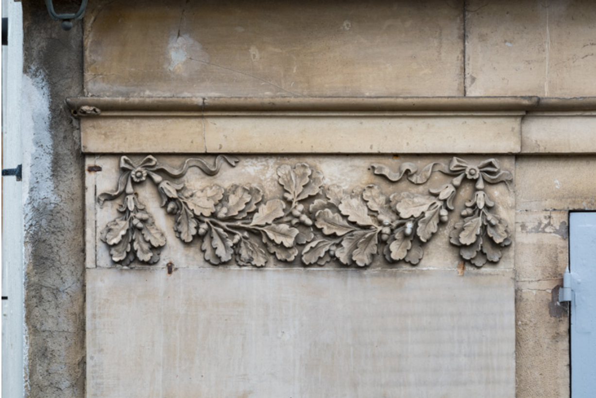
Façade latérale gauche, 1er pilastre (à gauche) : guirlande sculptée. 21, Semur-en-Auxois, 11 place de l' Ancienne Comédie
