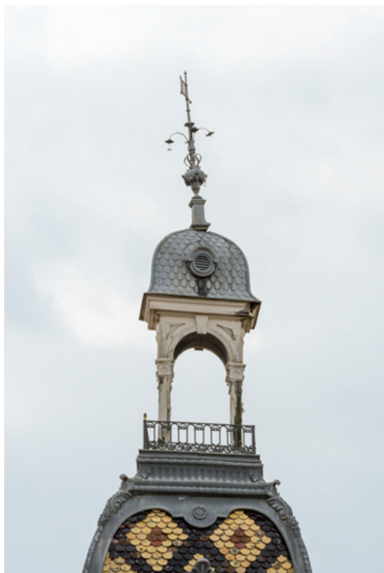
Galerie : lanterneau sur le pavillon d'entrée. 21, Chevigny-en-Valière, 2 rue Mercey
