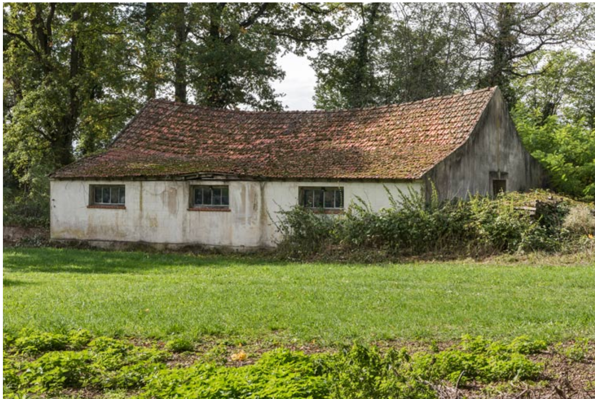
Etable : vue d'ensemble, depuis le nord-est.
