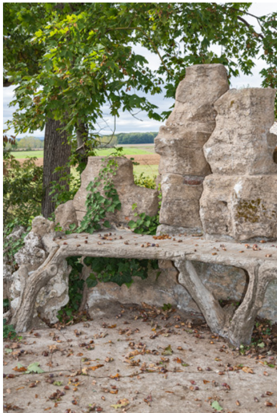
Grotte : banc en béton sur la terrasse.
