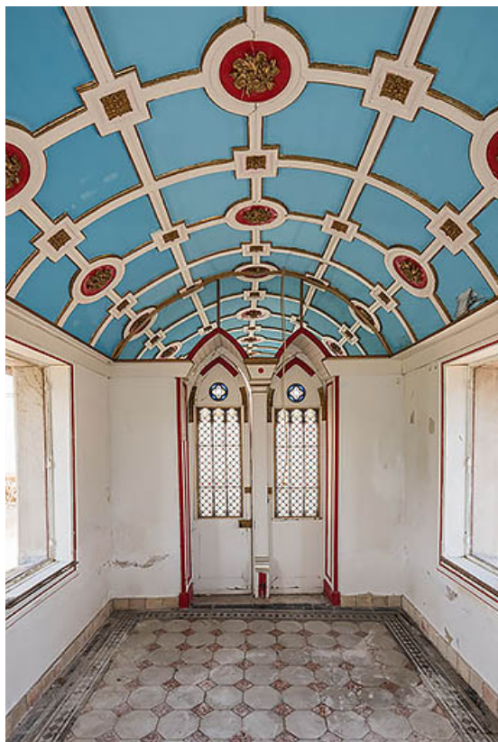
Chapelle : vue intérieure vers l'entrée.
