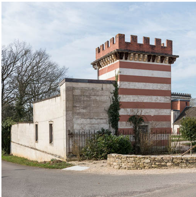
"Château neuf" : la "Tour du Four" et l' "appartement des bains", depuis la route au nord-est (vue resserrée). 21, Chevigny-en-Valière, 2 rue Mercey
