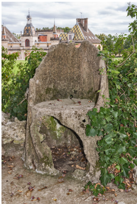
Grotte : fauteuil en béton sur la terrasse.
