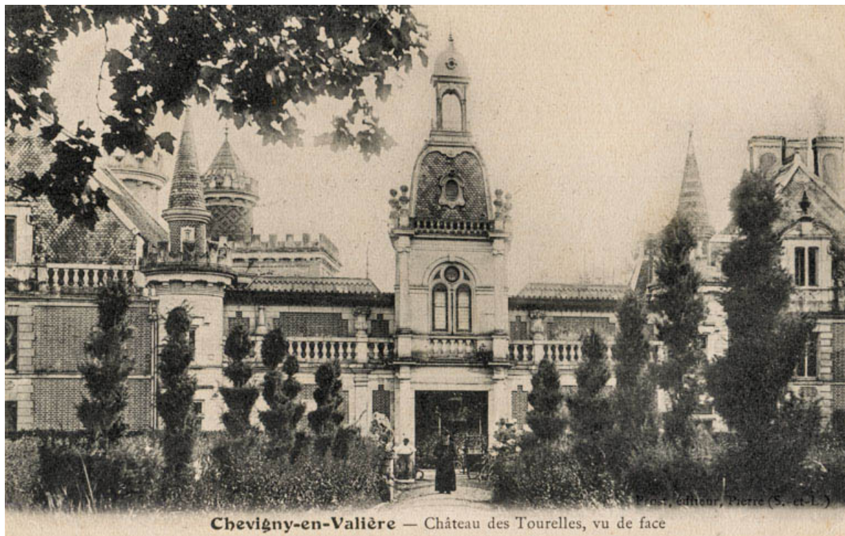
Chevigny-en-Valière - Château des Tourelles, vu de face. S.d. [limite 19e siècle 20e siècle, avant 1905]. 21, Chevigny-en-Valière, 2 rue Mercey
