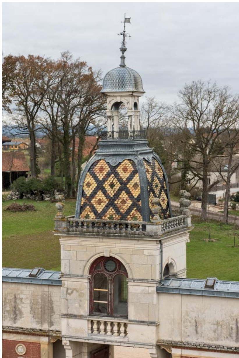
Galerie : pavillon d'entrée, depuis le "Donjon".
