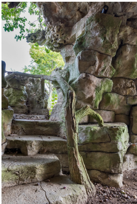
Grotte : départ de la rampe d'escalier.
