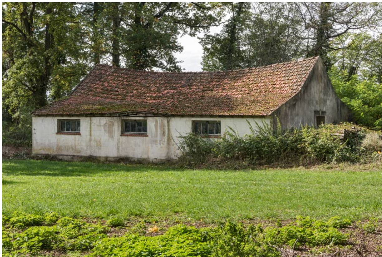
Etable : vue d'ensemble, depuis le nord-est.
