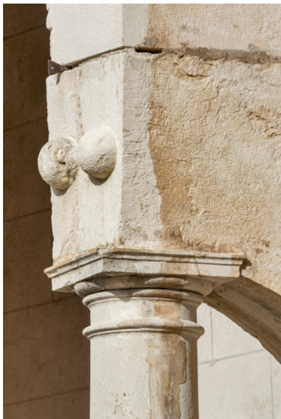
Galerie : supports côté cour (chapiteau et boules apotropaïques).
