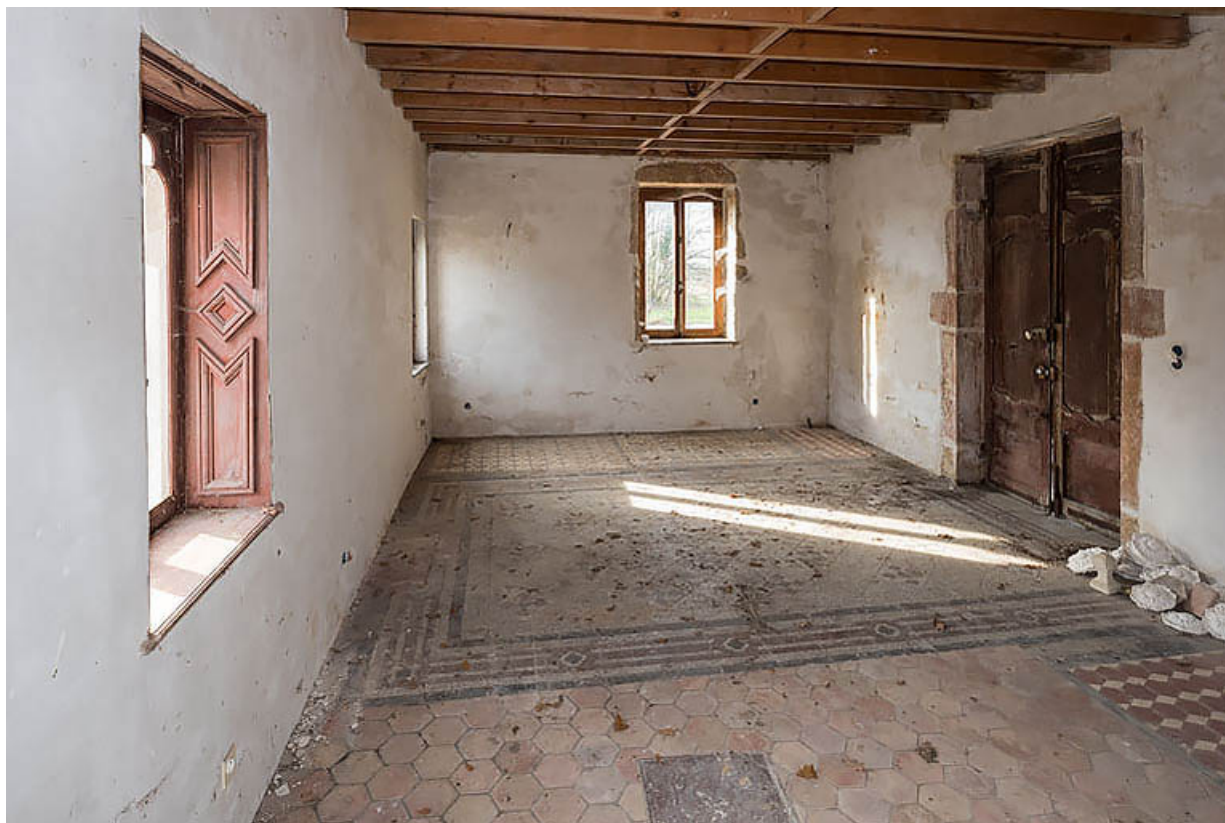
"Château neuf" : intérieur au rez-de-chaussée de l' "appartement des bains". 21, Chevigny-en-Valière, 2 rue Mercey
