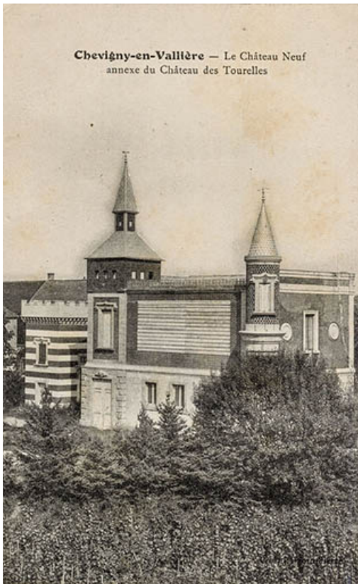
Chevigny-en-Vallière - Le Château Neuf, annexe du Château des Tourelles. S.d. [limite 19e siècle 20e siècle, avant 1905]. 21, Chevigny-en-Vallière, 2 rue Mercey
