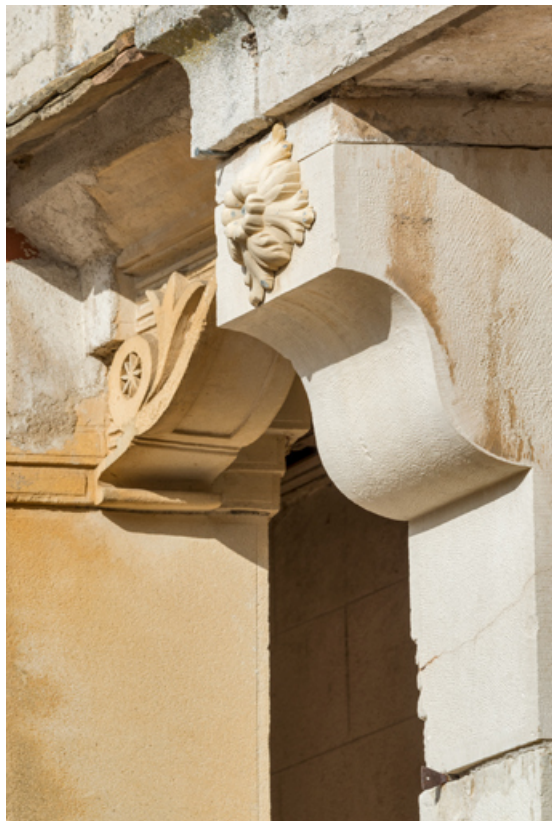
Galerie : supports côté cour (corbeaux).
