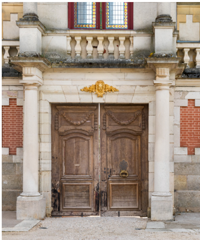
Galerie : porte cochère, vantaux fermés. La porte provient d'un hôtel particulier de la rue d'Enfer, à Paris. 21, Chevigny-en-Valière, 2 rue Mercey
