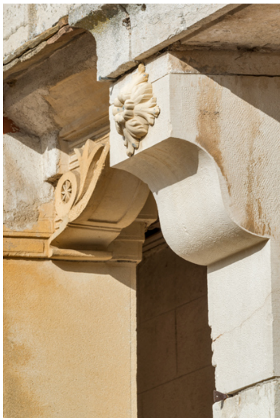
Galerie : supports côté cour (corbeaux). 21, Chevigny-en-Valière, 2 rue Mercey
