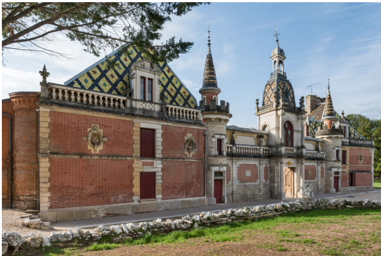
Élévation antérieure, de trois quarts gauche.
