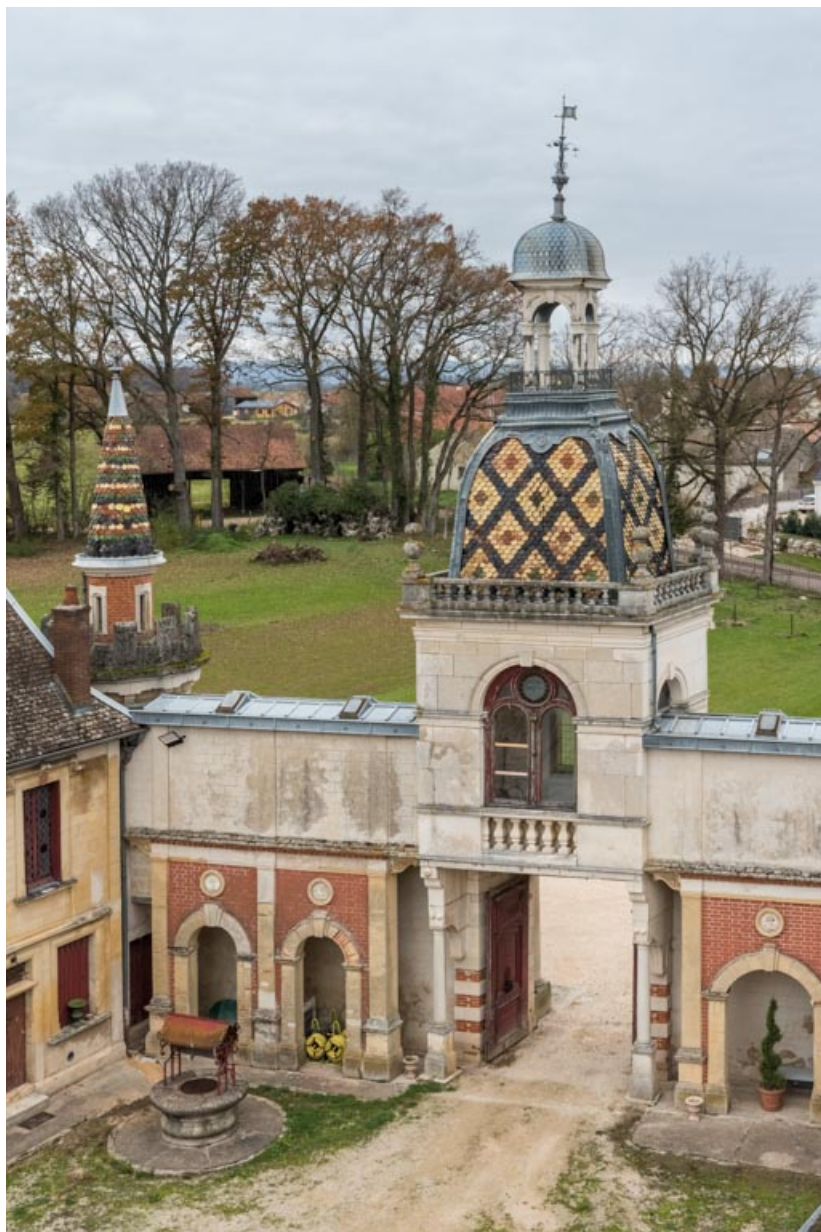
Galerie et puits : vue plongeante depuis le "Donjon".
