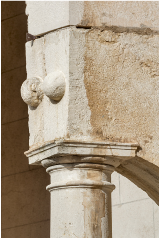
Galerie : supports côté cour (chapiteau et boules apotropaïques). 21, Chevigny-en-Valière, 2 rue Mercey
