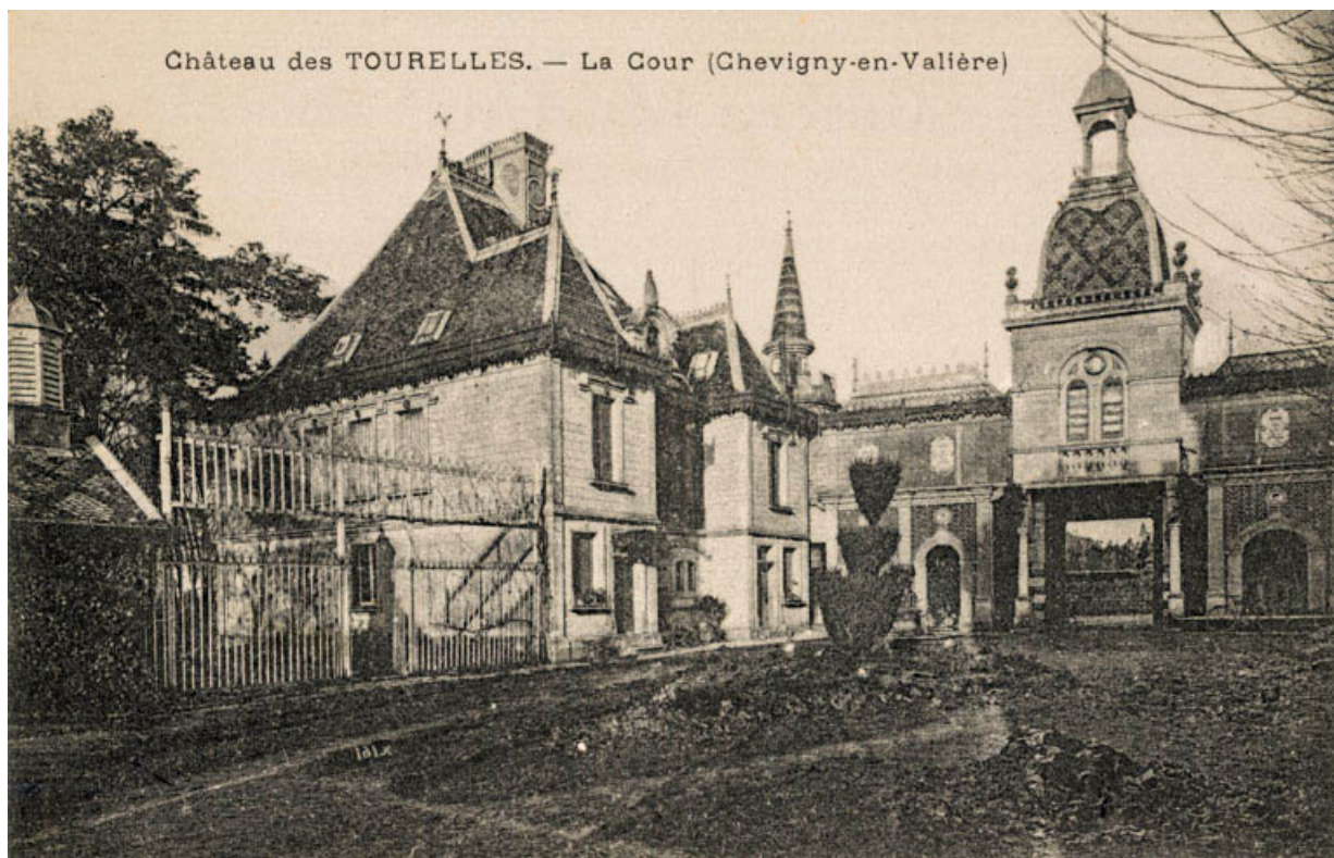
Château des Tourelles. - La Cour (Chevigny-en-Valière). S.d. [1re moitié 20e siècle].
