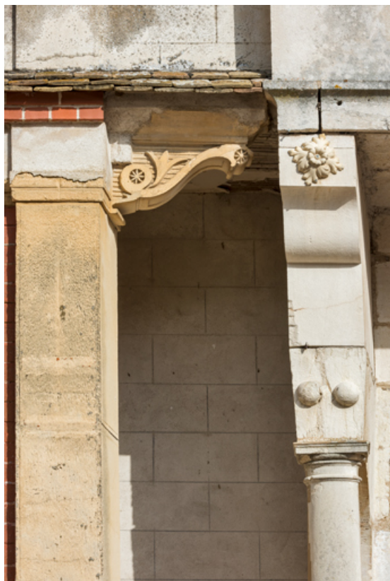
Galerie : supports côté cour.
