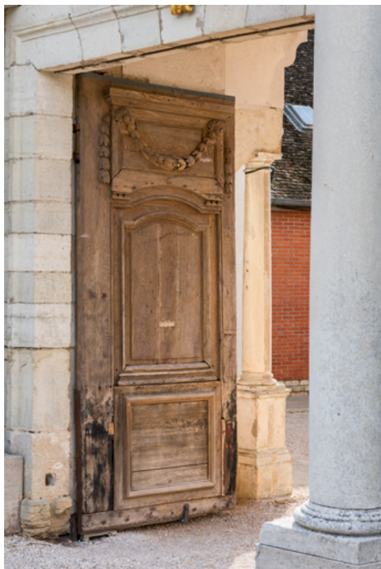
Galerie : vantail de la porte cochère. 21, Chevigny-en-Valière, 2 rue Mercey
