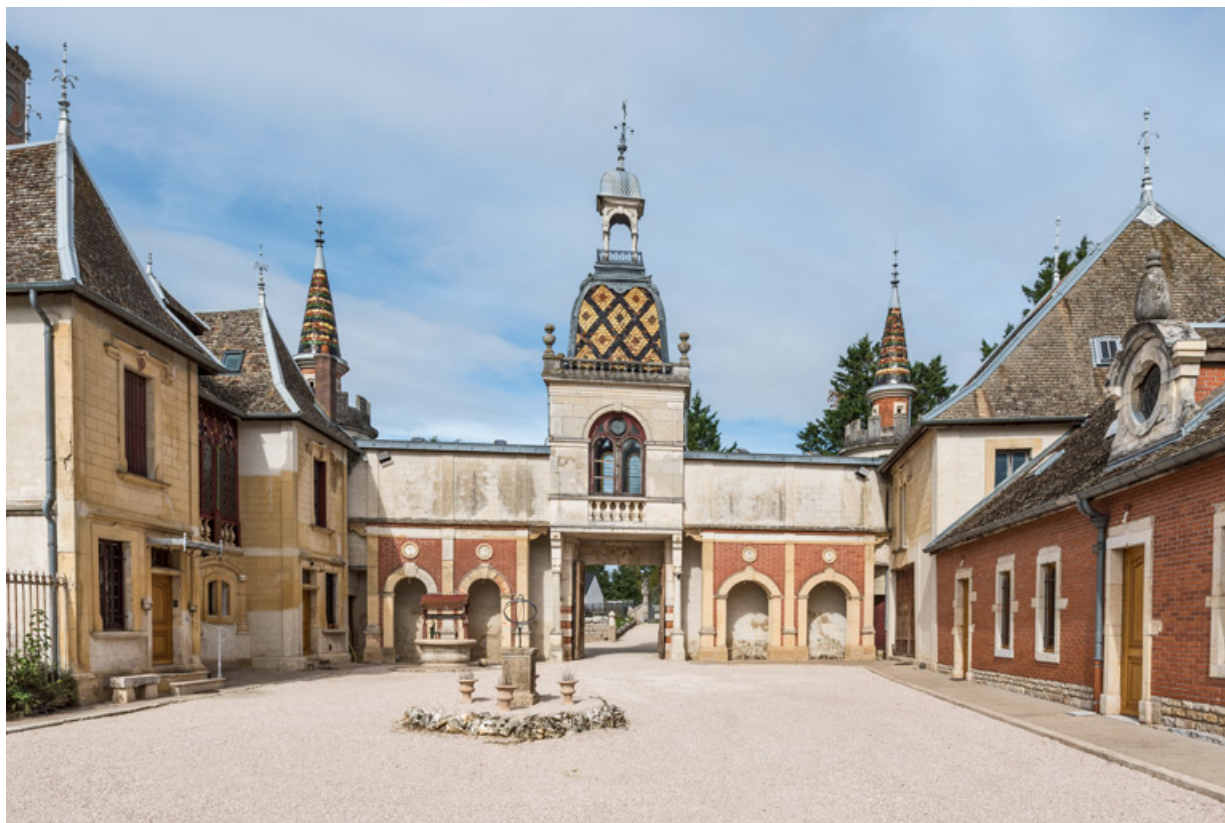
Élévation sur cour : demeure (à gauche), galerie et communs (à droite). 21, Chevigny-en-Vallière, 2 rue Mercey
