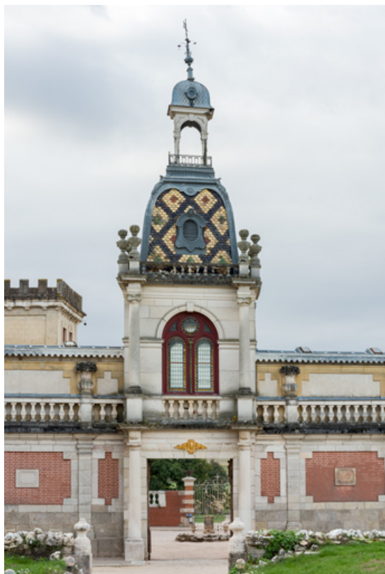
Galerie : pavillon d'entrée.
