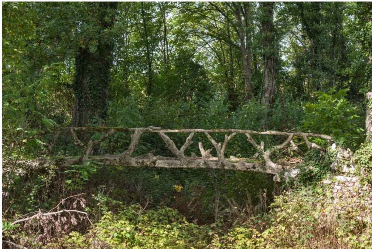
Parc : passerelle et pièce d'eau dans l'angle sud-ouest.
