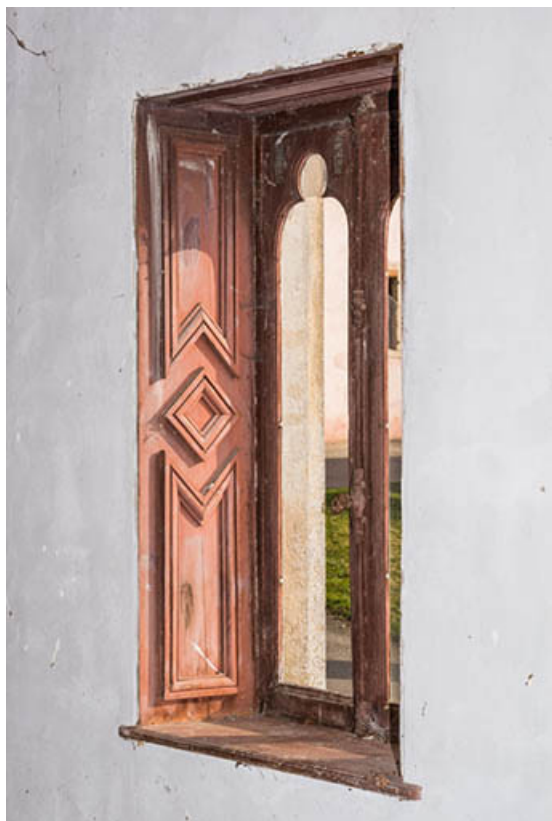
"Château neuf" : boiserie d'ébrasement de fenêtre dans l' "appartement des bains". 21, Chevigny-en-Valière, 2 rue Mercey
