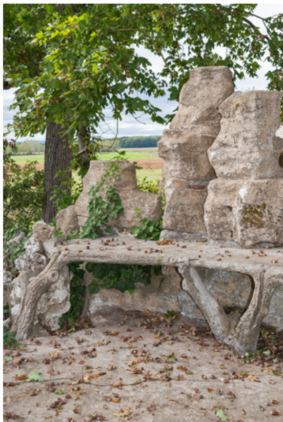
Grotte : banc en béton sur la terrasse.
