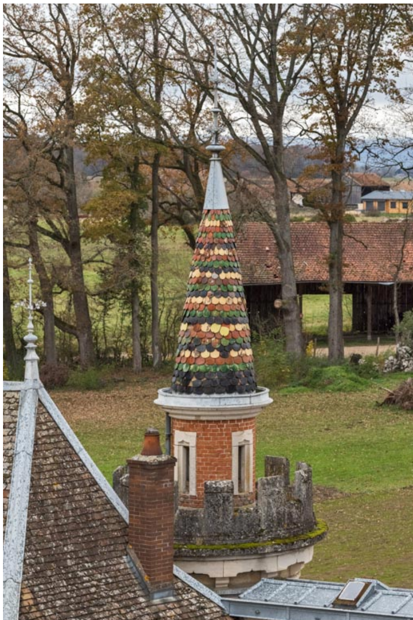
Galerie : tourelle ouest, depuis le "Donjon".
