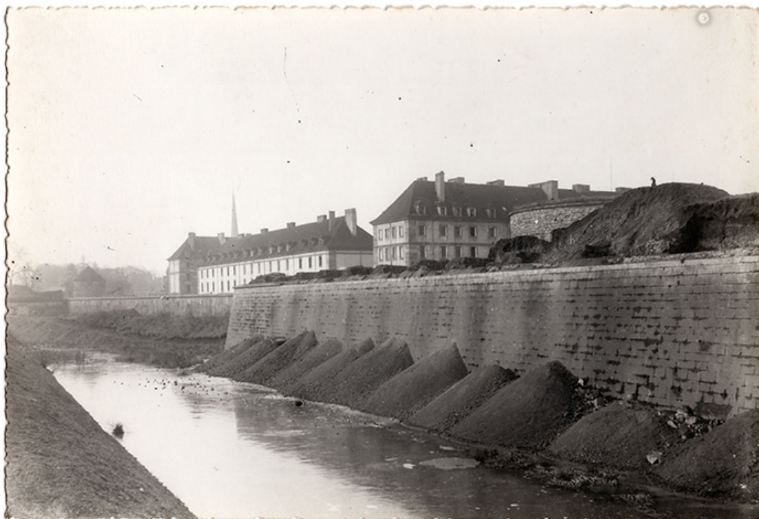
[Escarpe du bastion du Cygne et courtine du front est avec fossé inondé]. S.d [1er quart 20e siècle]. 21, Auxonne
