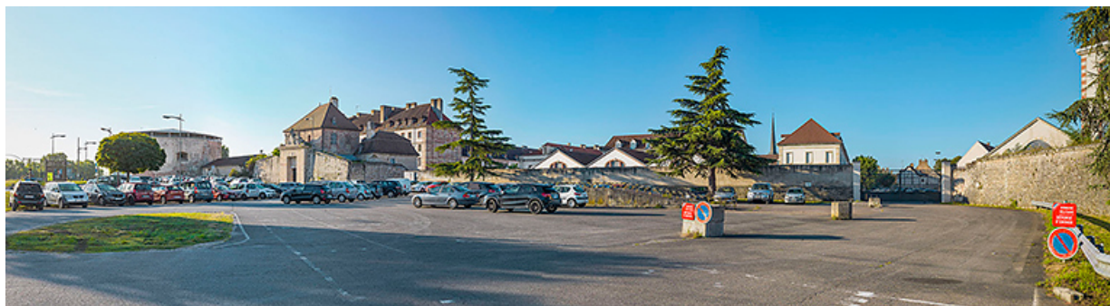
Le front nord de la place. De gauche à droite : la tour du Cygne, la porte Royale et le bastion Royal. 21, Auxonne
