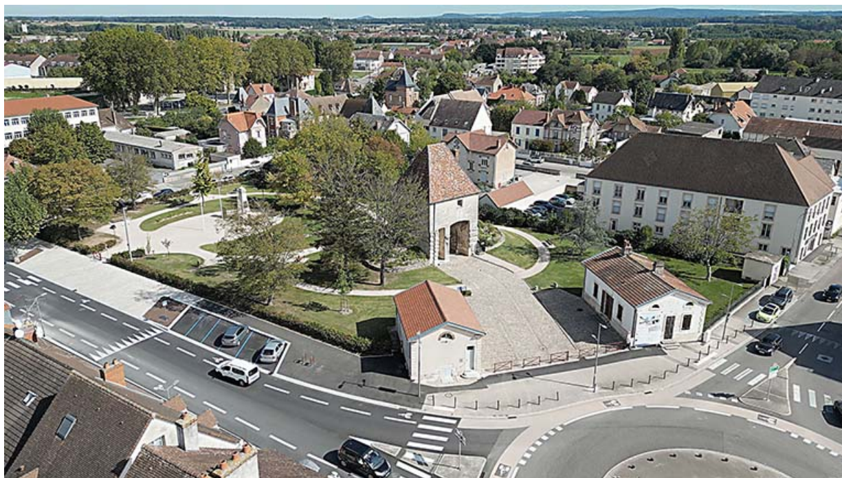
Vue aérienne de la porte de Comté. 21, Auxonne
