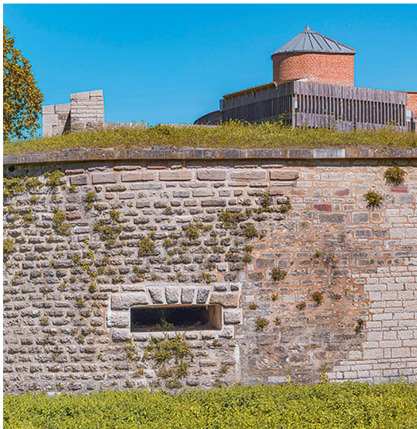
La tour basse des moulins du château.
