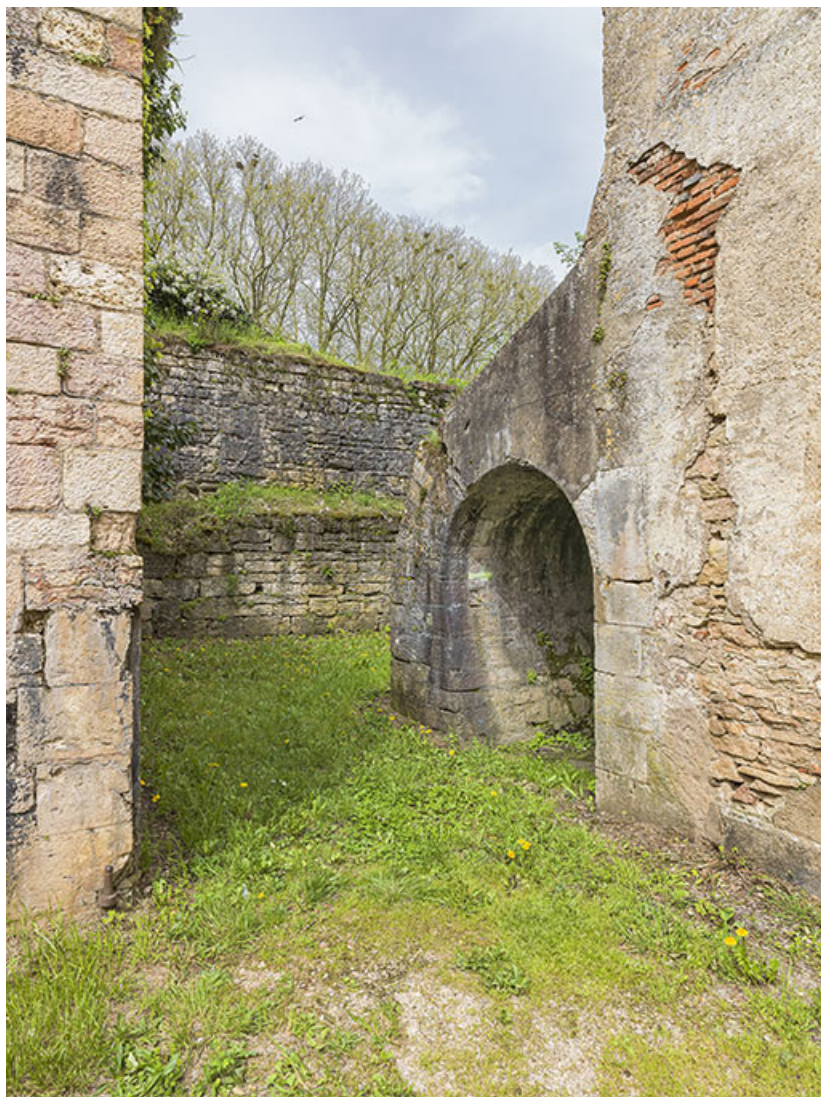
Galerie voûtée adossée à la caserne ouest du château. 21, Auxonne
