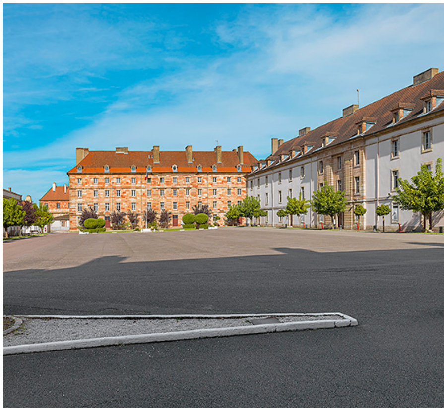
Les casernes d'infanterie construites vers 1760. 21, Auxonne
