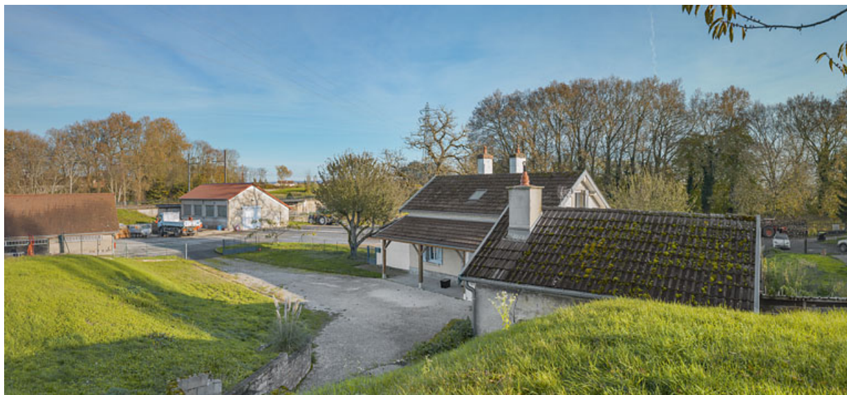
Vue d'ensemble de la maison et des hangars de l'atelier de VNF.
