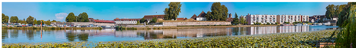
Le front de Saône depuis la rive droite de la rivière.
