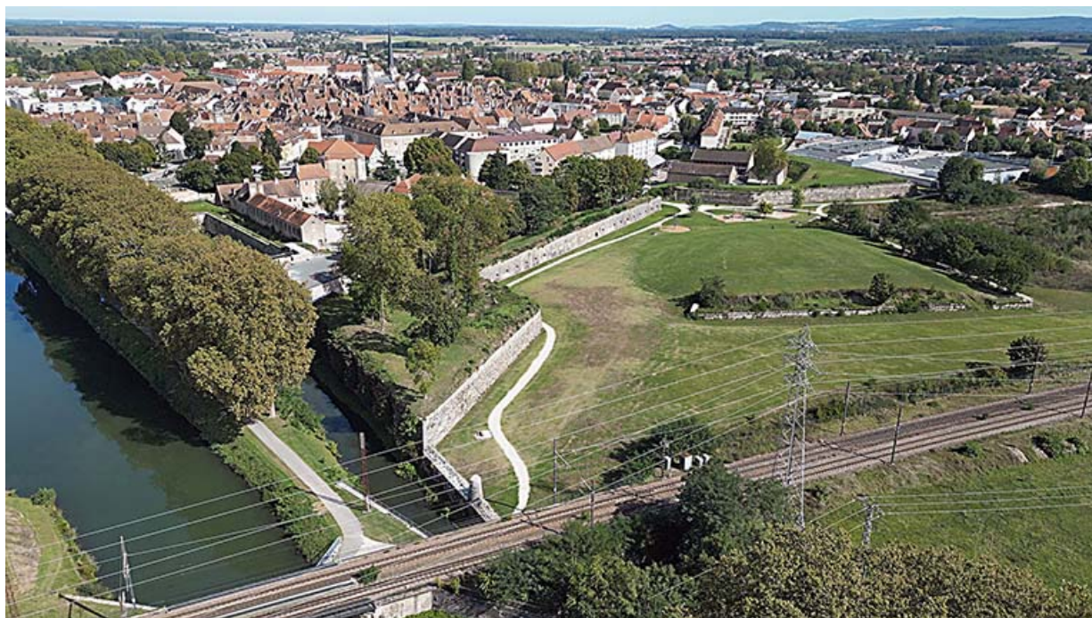
Vue aérienne du front sud.
