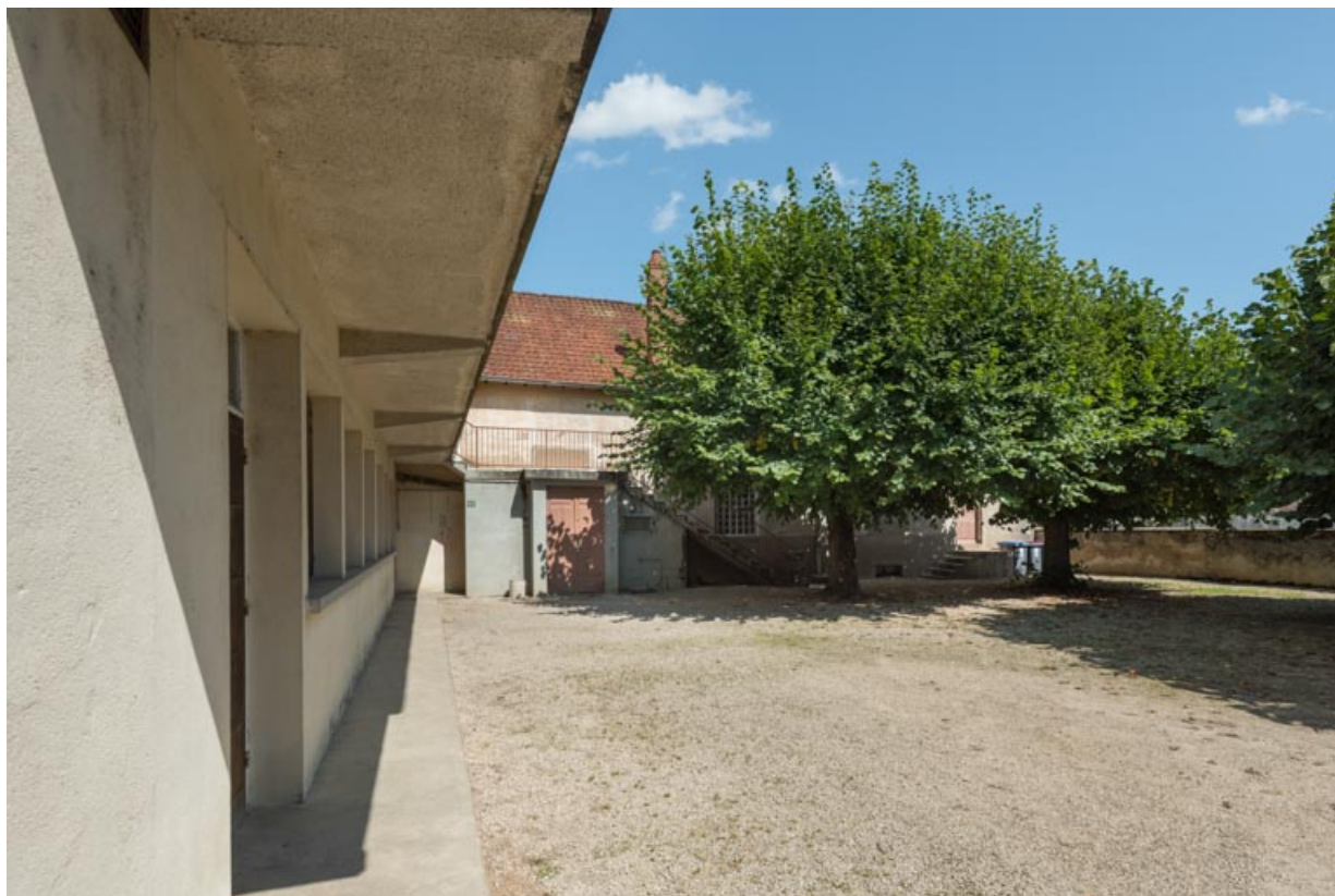
Cinéma : façade latérale droite.
