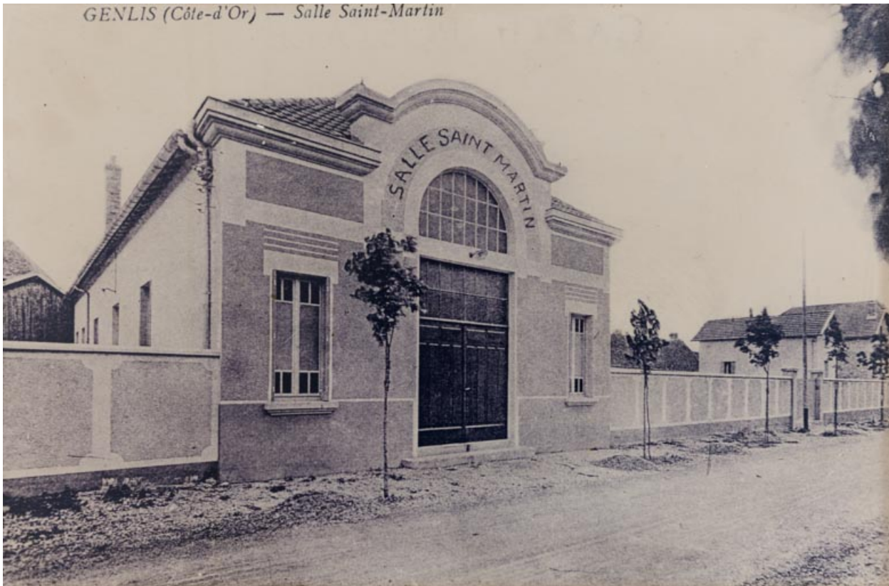
Genlis (Côte-d'Or) - Salle Saint-Martin [façade antérieure vue de trois quarts gauche]. S.d. [2e quart 20e siècle]. 21, Genlis, 3 rue Aristide Briand
