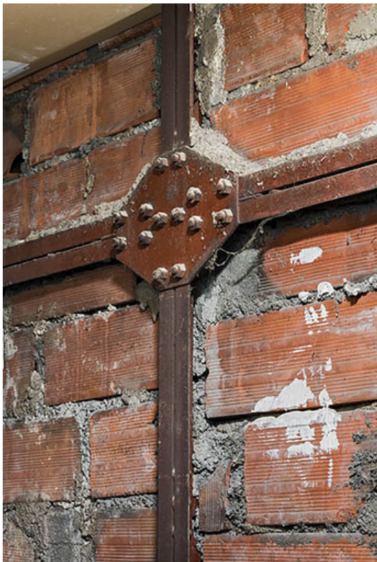
Détail du pan de fer d'un mur.
