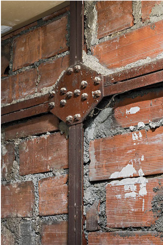
Détail du pan de fer d'un mur.
