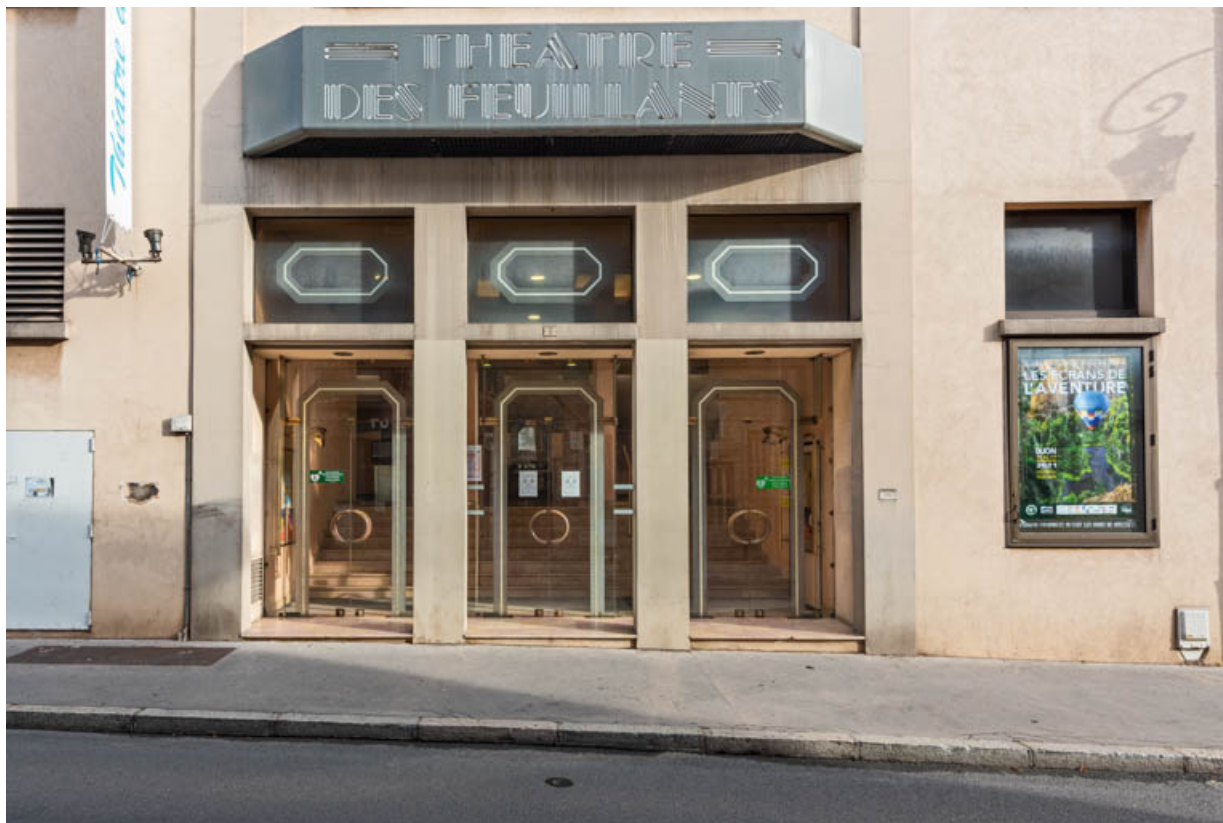
Façade antérieure : entrée.
