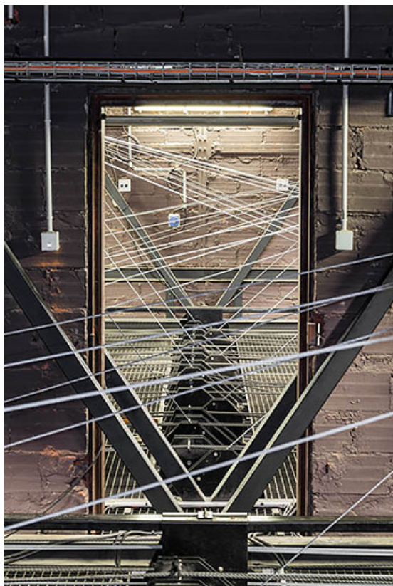
Cage de scène : grill (cadrage vertical).
