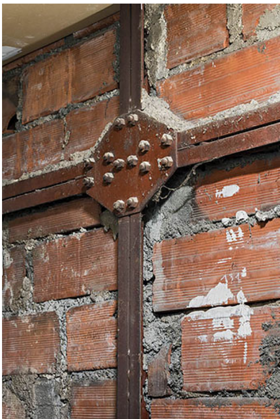
Détail du pan de fer d'un mur.
