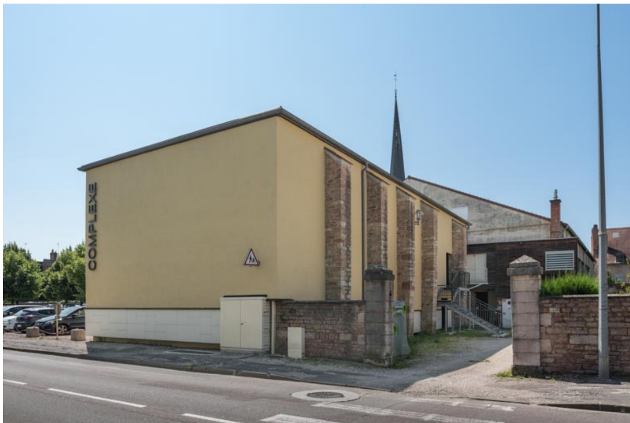
Façades postérieure et latérale droite.
