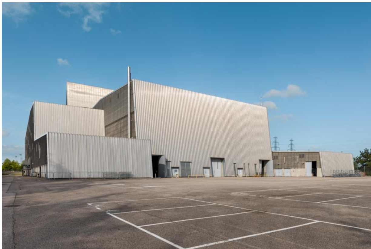
Façade postérieure, de trois quarts gauche. 21, Dijon rue de Colchide, lieudit : la Toison d'Or
