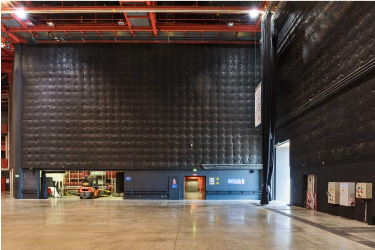
Salle : murs côté jardin et du lointain (à droite). 21, Dijon rue de Colchide, lieudit : la Toison d'Or
