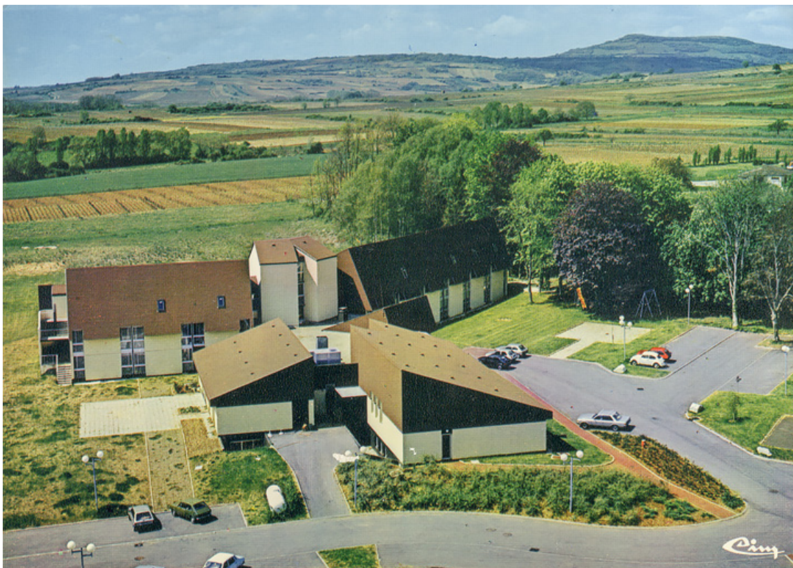
Centre thermal de 1978. 21, Santenay
