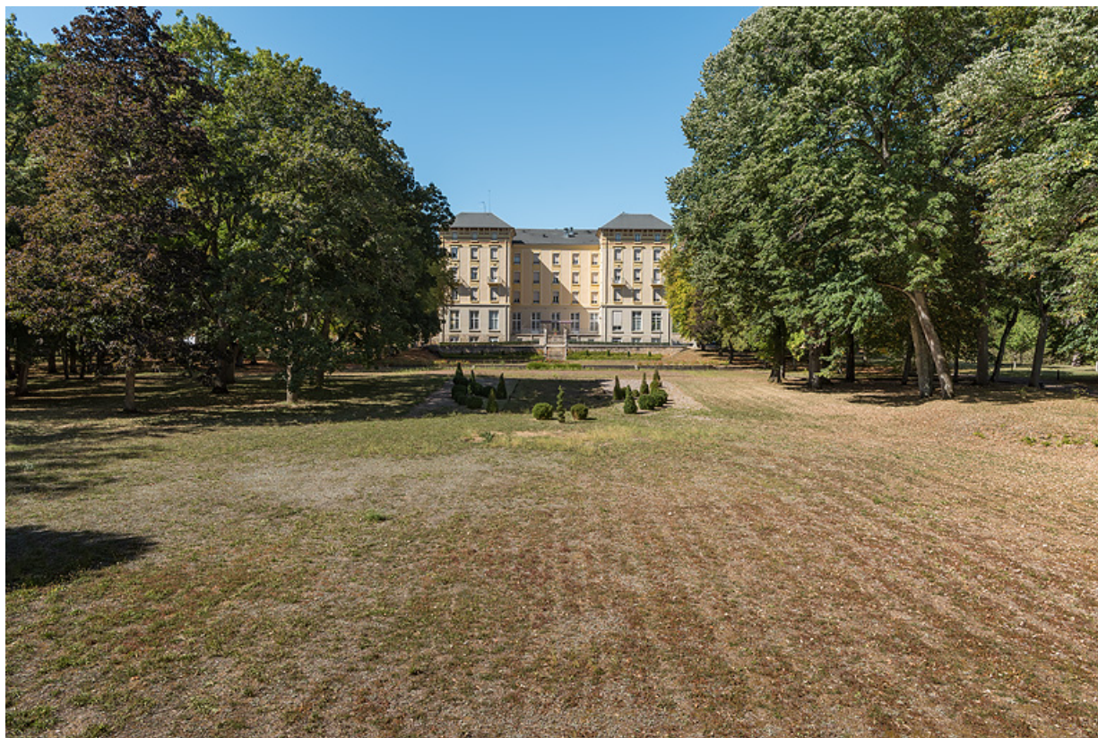
Vue d'ensemble en direction de l'hôtel.
