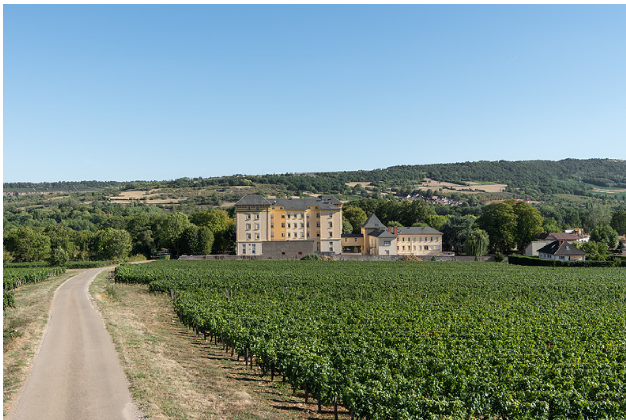
Chemin du potet en direction du Grand Hôtel des Bains.
