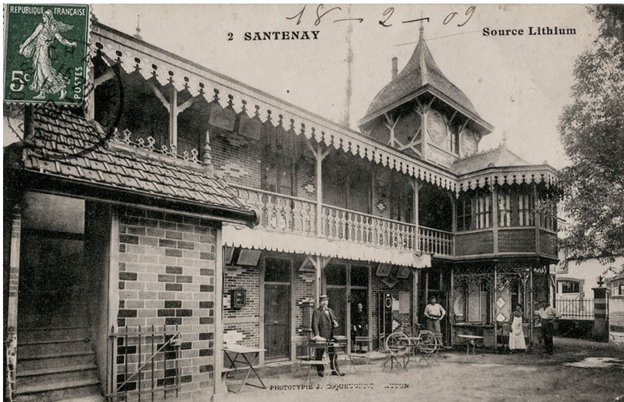
Établissement thermal de la fin du 19e siècle, cabines sur deux niveaux et buvette. 21, Santenay avenue des Sources
