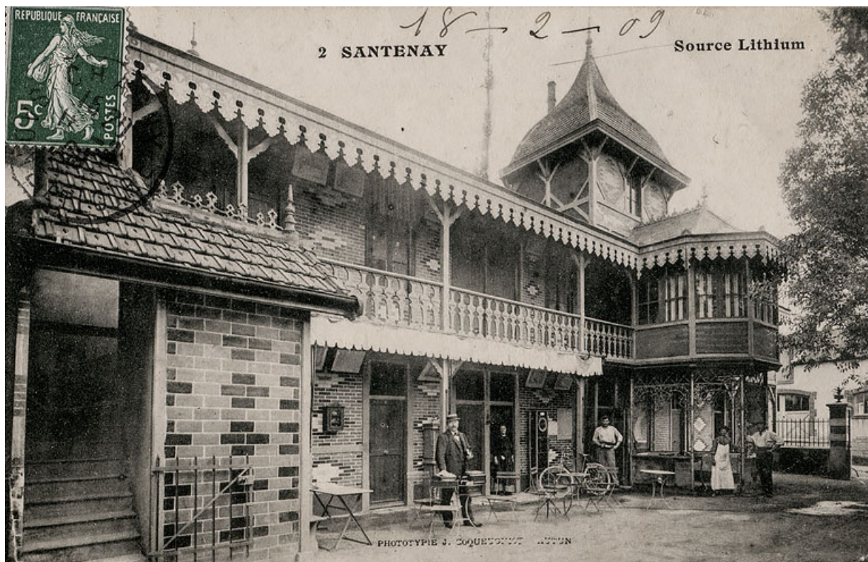
Établissement thermal de la fin du 19e siècle, cabines sur deux niveaux et buvette.
