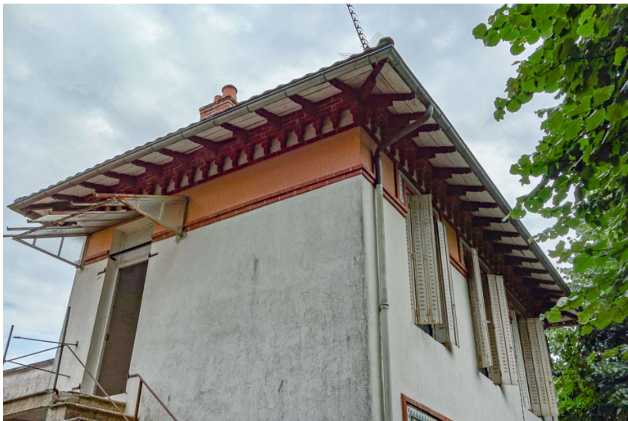
Élévation du pavillon du gardien, fenêtres de l'étage et toiture.
