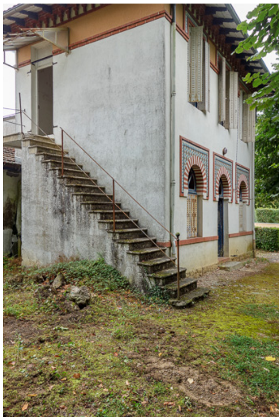
Élévation du pavillon du gardien, vue depuis le sud-ouest. 21, Santenay avenue des Sources
