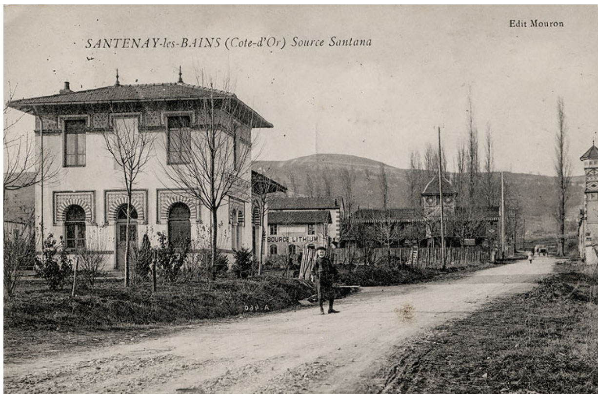
Vue ancienne, depuis le sud-est.
