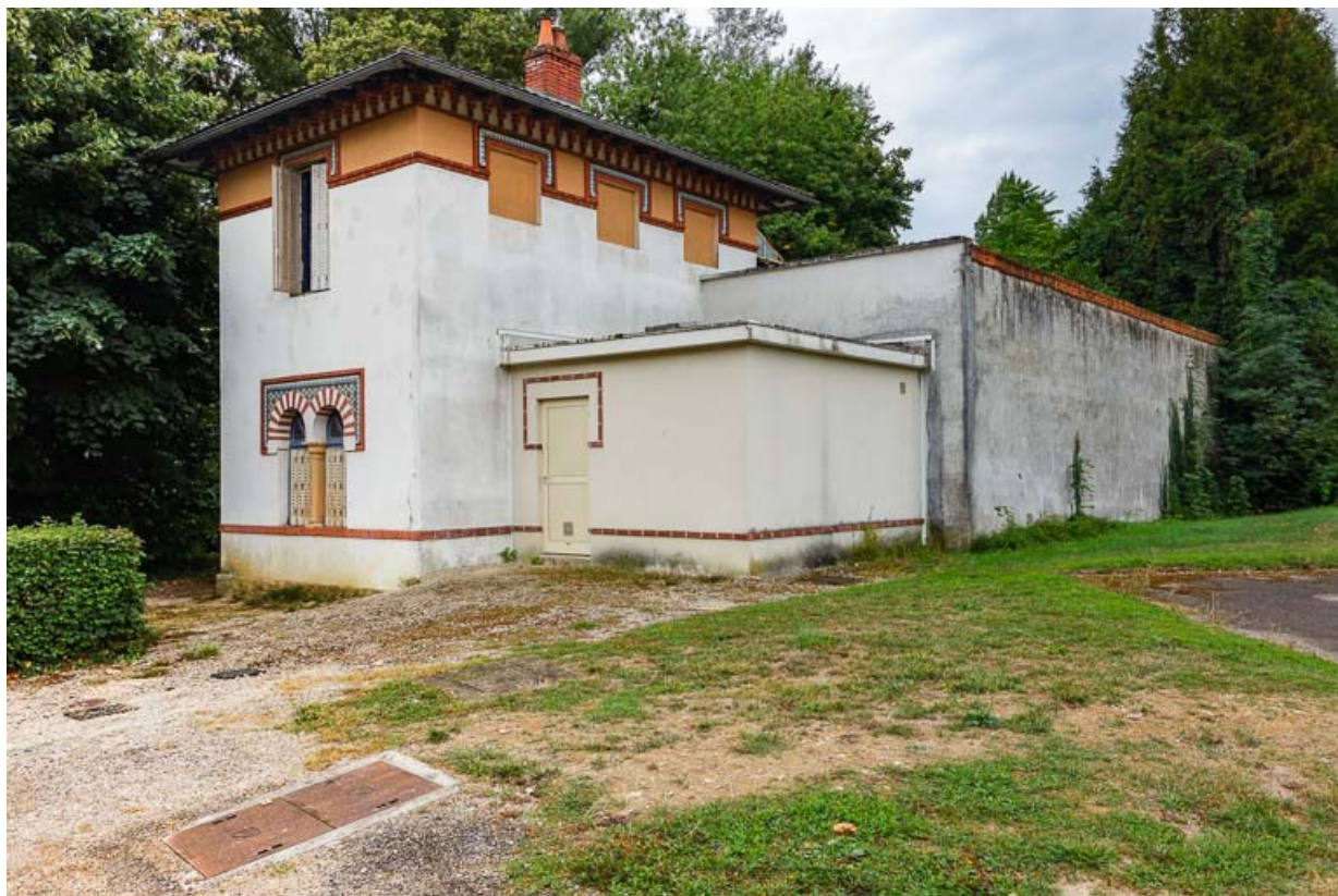
Emplacement du pavillon de la source (détruit et remplacé par une construction tardive).
