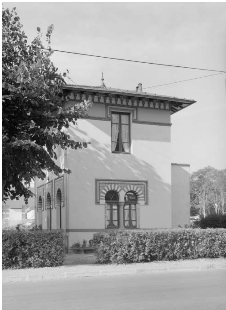
Pavillon de la source Santana.
