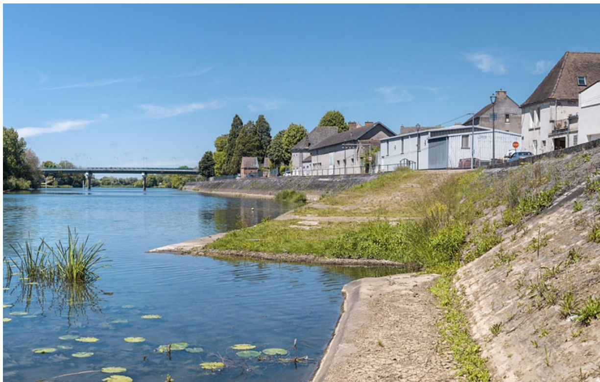
Les quais se poursuivent en aval du pont : rampe d'accès à la rivière.
