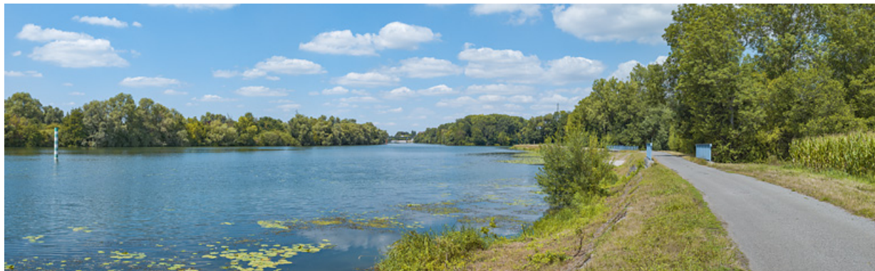
Vue d'ensemble des deux ponceaux, rive gauche.
