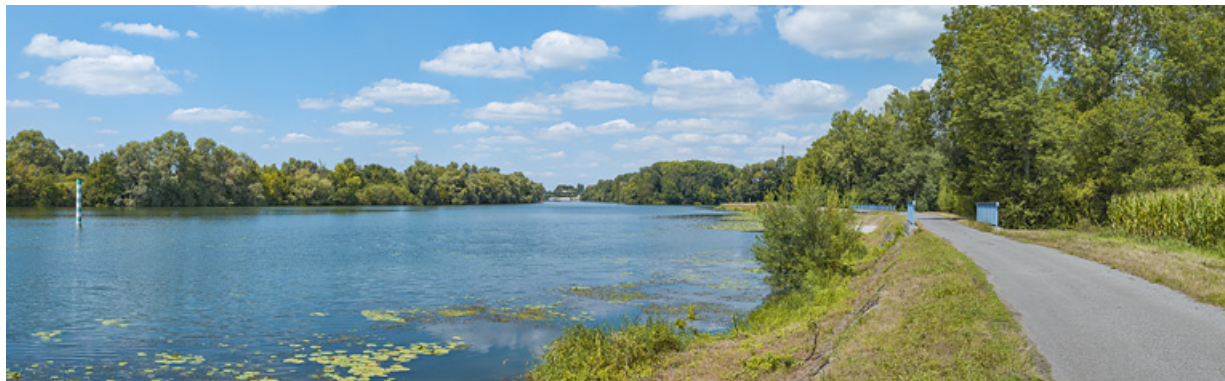
Vue d'ensemble des deux ponceaux, rive gauche.
