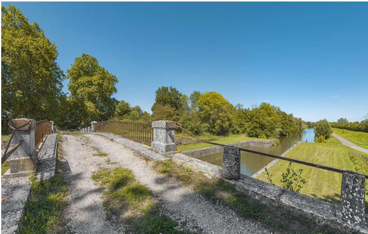
Vue d'ensemble du pont et de l'ancienne dérivation de Seurre.
