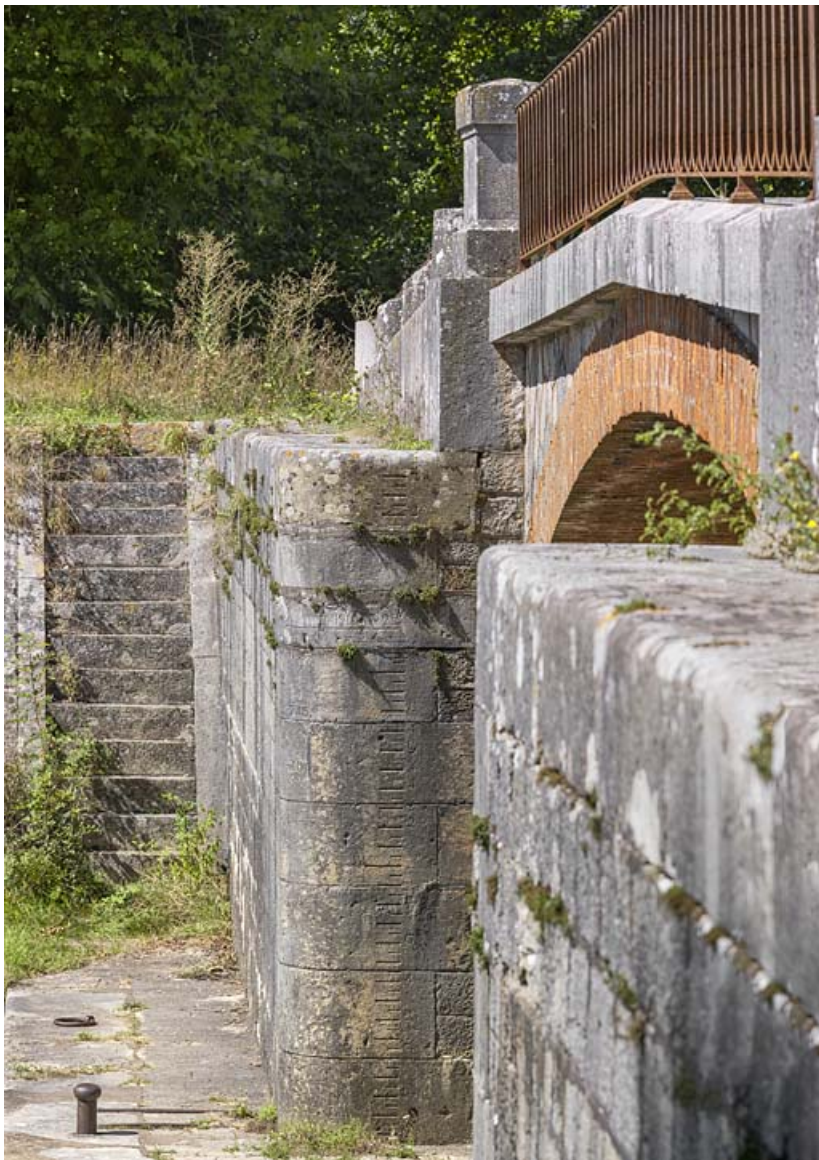
Détail de la voûte en brique, du garde-corps du pont et de l'échelle de crue sur la culée. 21, Trugny, lieudit : PK 184
