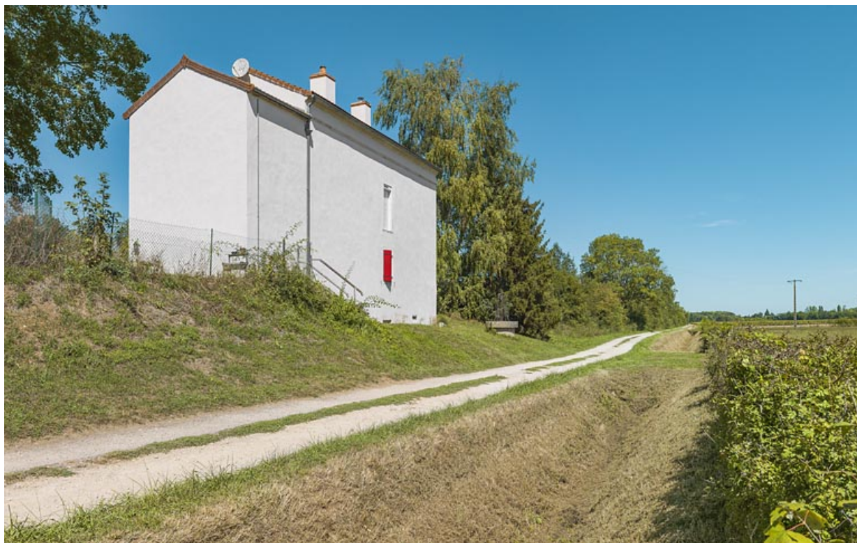
La maison éclusière de 3/4 : pignon de l'annexe latérale droite et face arrière. 21, Trugny, lieudit : PK 184
