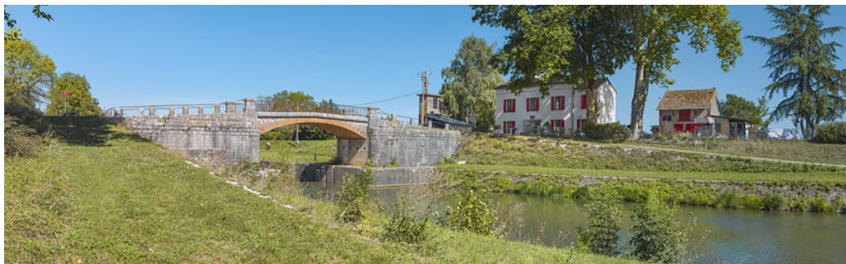
Vue d'ensemble du site, avec au centre, le pont sur écluse et à droite la maison éclusière et ses dépendances.
