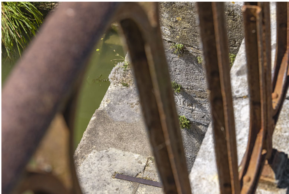
Détail de l'échelle de crue sur la culée du pont.
