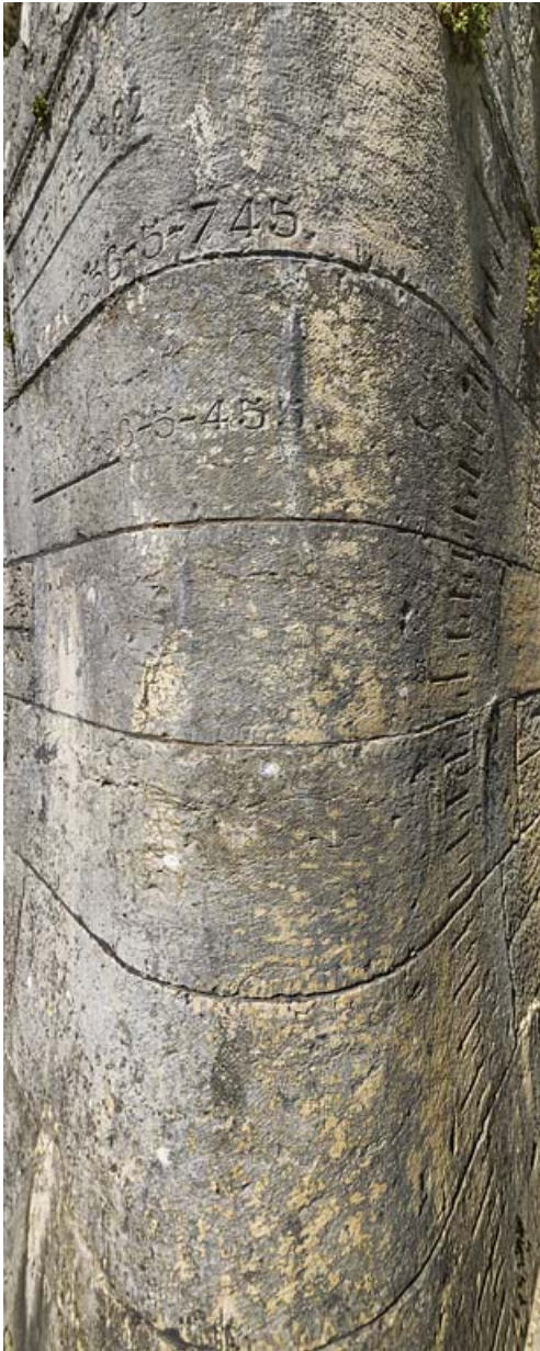
Détail de l'échelle de crue sur la culée du pont.
