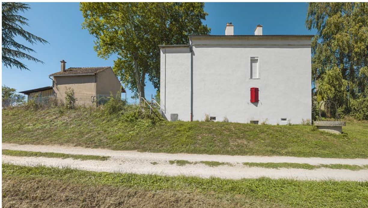
La maison éclusière : face arrière.
