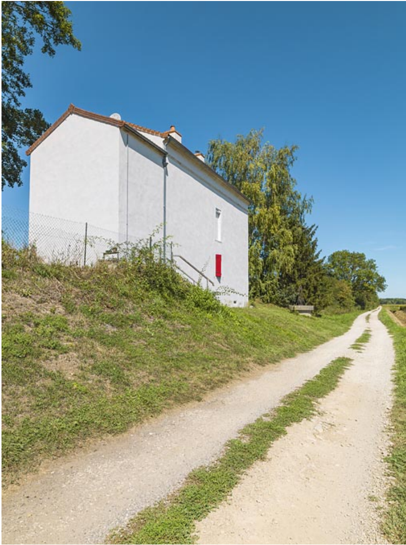
La maison éclusière de 3/4 : pignon de l'annexe latérale droite, face arrière et puits. 21, Trugny, lieudit : PK 184
