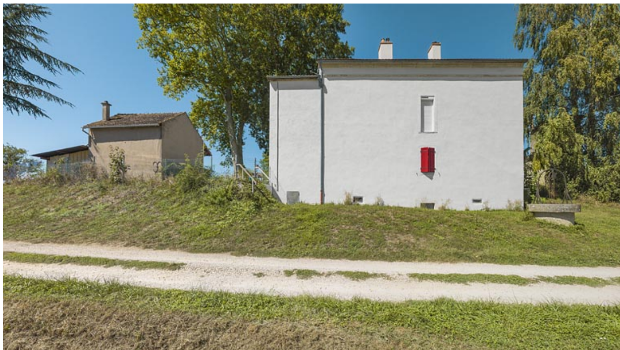
La maison éclusière : face arrière.
