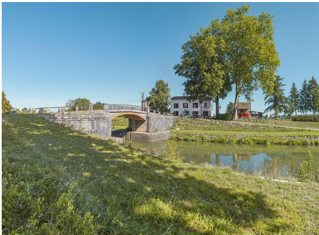
Vue d'ensemble du site, avec au centre, le pont sur écluse et à droite la maison éclusière et ses dépendances. 21, Trugny, lieudit : PK 184
