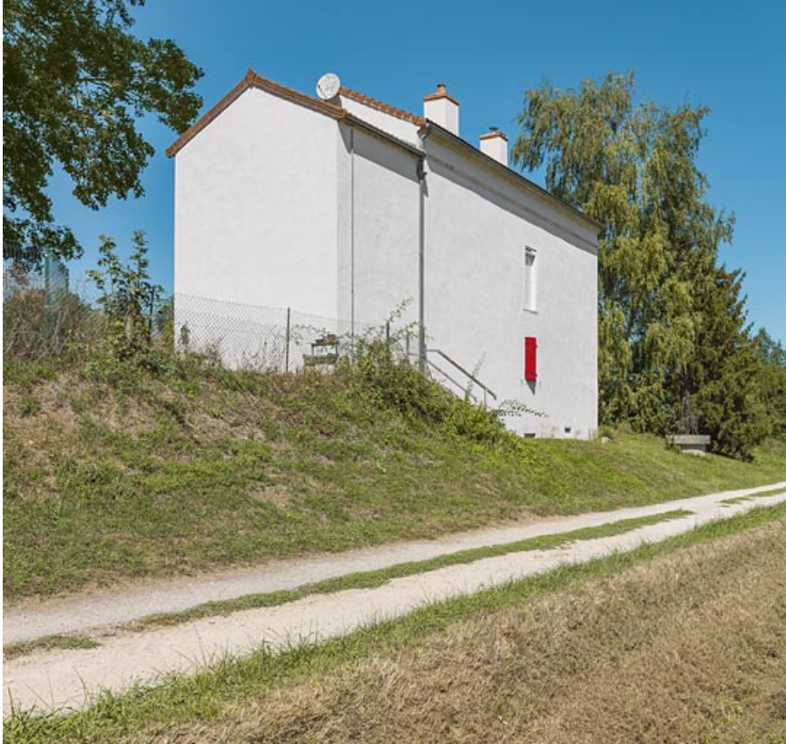
La maison éclusière de 3/4 : pignon de l'annexe latérale droite et face arrière. 21, Trugny, lieudit : PK 184
