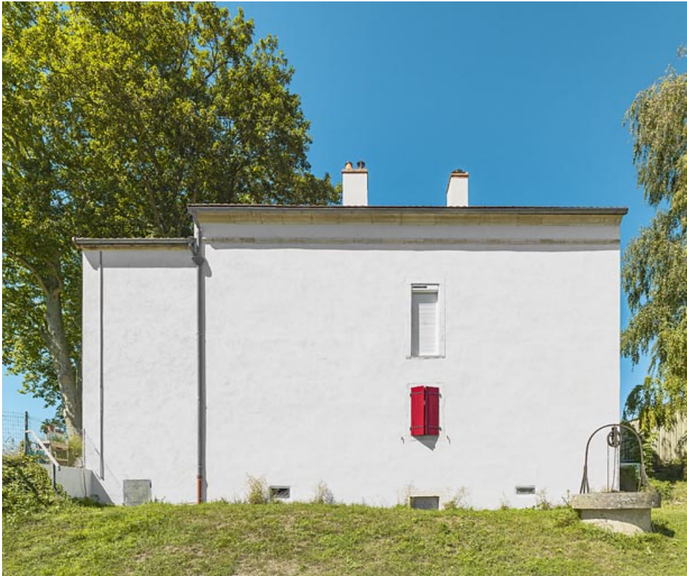
La maison éclusière : face arrière.
