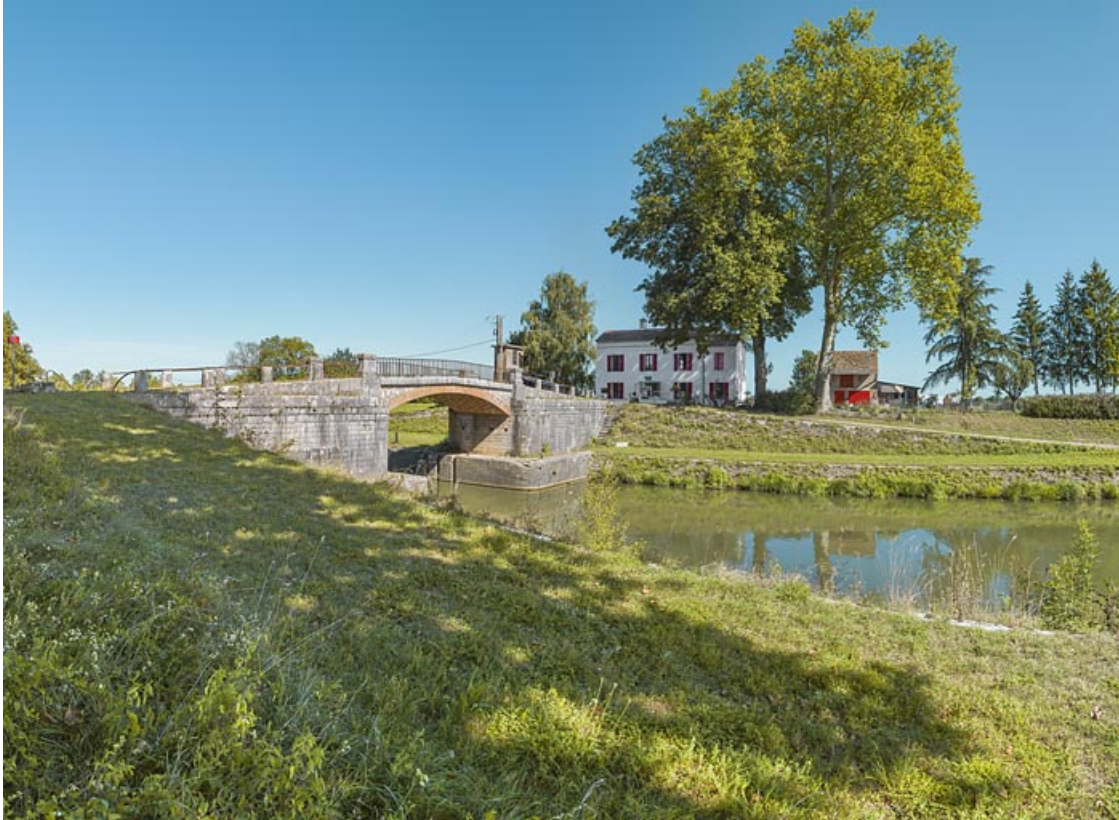
Vue d'ensemble du site, avec au centre, le pont sur écluse et à droite la maison éclusière et ses dépendances. 21, Trugny, lieudit : PK 184
