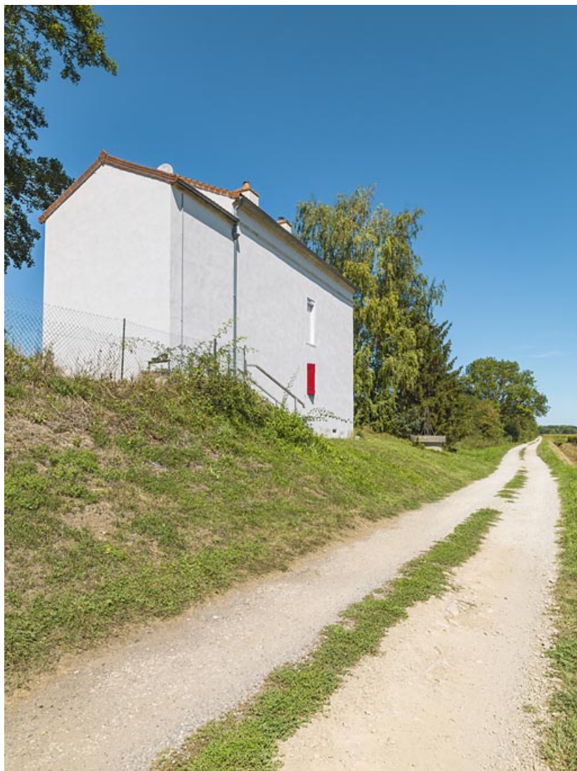
La maison éclusière de 3/4 : pignon de l'annexe latérale droite, face arrière et puits. 21, Trugny, lieudit : PK 184
