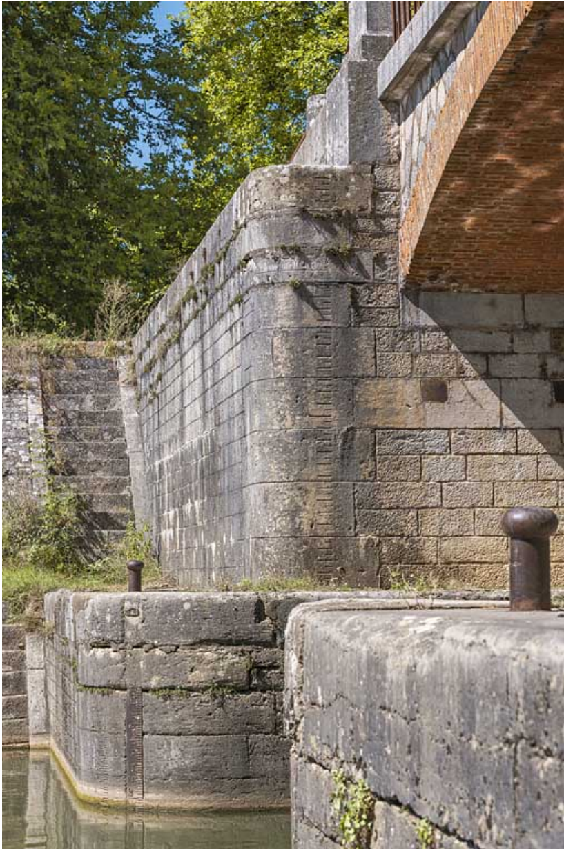
Echelle de crue sur la culée du pont et escaliers.
