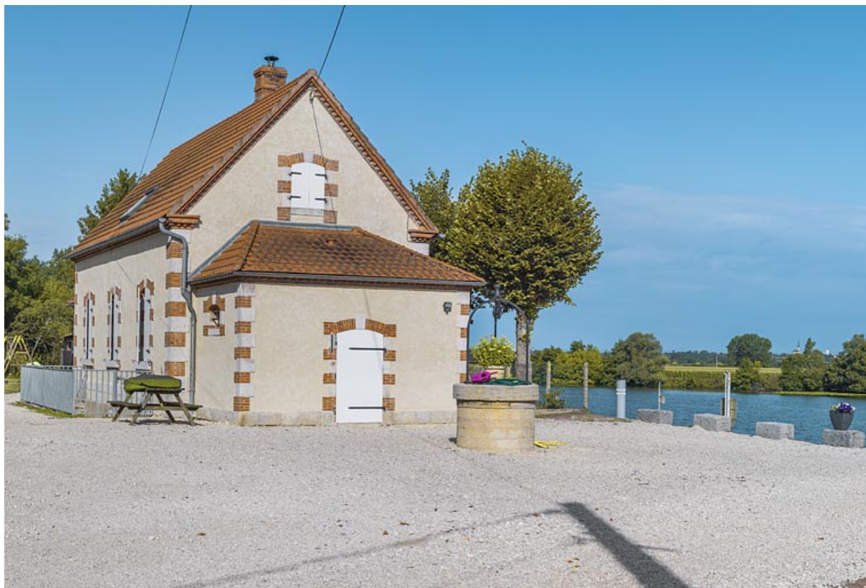
Vue de 3/4 : annexe latérale et face arrière. Au premier plan, le puits. 21, Trugny, lieudit : PK 185
