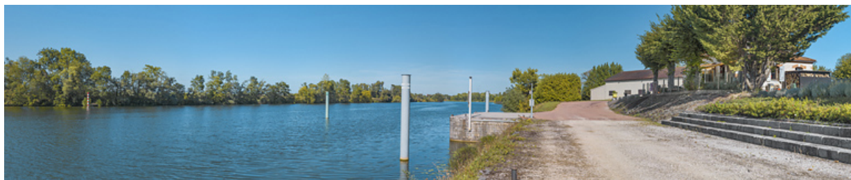
Le site de l'ancien barrage et la maison du barragiste, d'aval. Au fond, le bâtiment de VNF.
