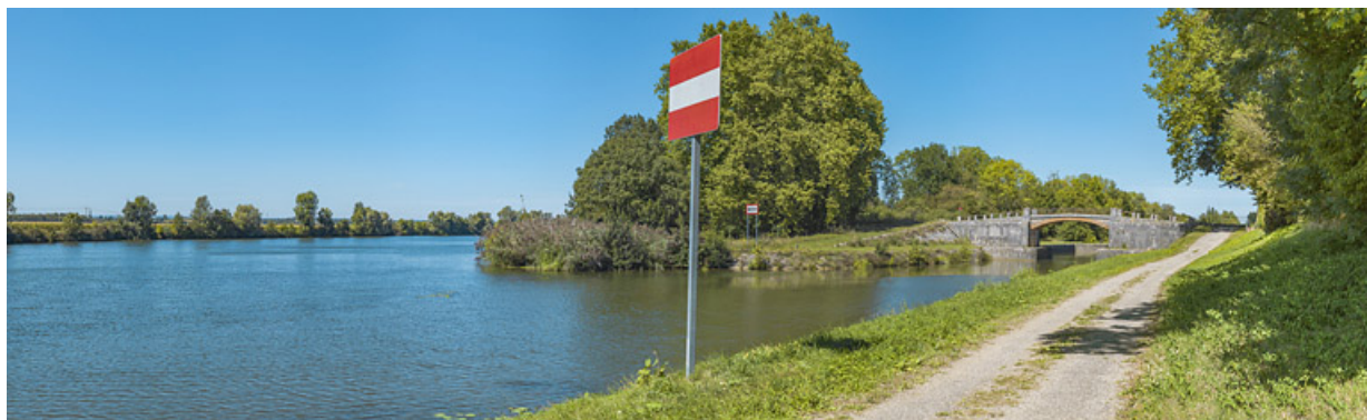
La fin de l'ancien bief, à la sortie du site d'écluse de Seurre. A gauche, la Saône. 21, Trugny, lieu-dit : PK 185
