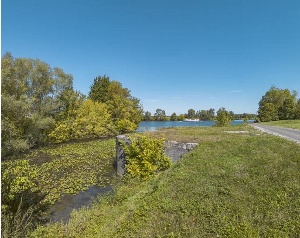
Les vestiges de la porte de garde de l'ancienne dérivation de Seurre. En arrière-plan, la Saône. 21, Trugny, lieudit : PK 185
