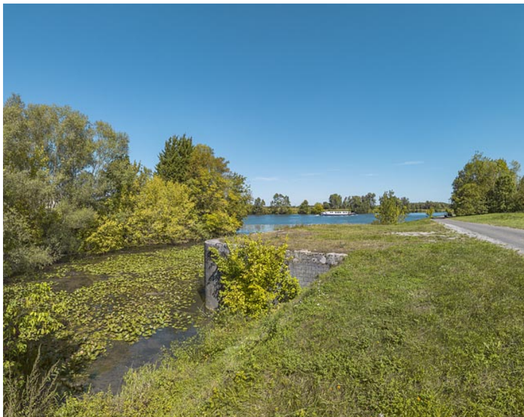
Les vestiges de la porte de garde de l'ancienne dérivation de Seurre. En arrière-plan, la Saône. 21, Trugny, lieudit : PK 185
