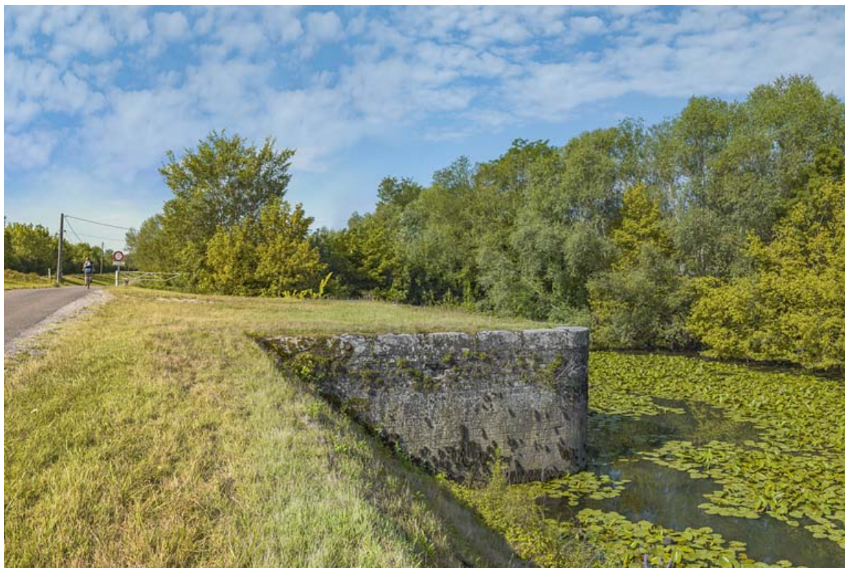
Les vestiges de la porte de garde de l'ancienne dérivation de Seurre. A gauche, le chemin de halage. 21, Trugny, lieudit : PK 185
