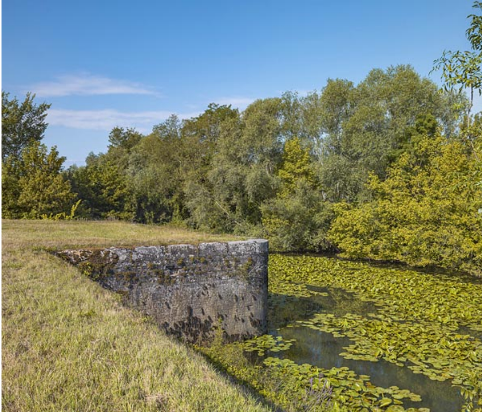
Les vestiges de la porte de garde de l'ancienne dérivation de Seurre.
