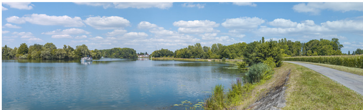
Vue d'ensemble d'aval des aménagements de rive à hauteur de Jallanges. En arrière-plan, la ville de Seurre. 21, Jallanges, lieudit : PK 186
