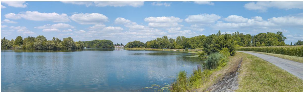
Vue d'ensemble d'aval des aménagements de rive à hauteur de Jallanges. En arrière-plan, la ville de Seurre. 21, Jallanges, lieudit : PK 186
