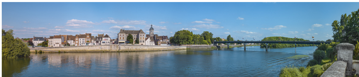
La ville de Seurre et ses quais et le nouveau pont, vus depuis la culée de l'ancien pont.
