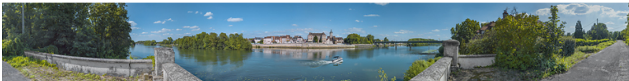
La ville de Seurre et ses quais, vus depuis l'ancienne culée du pont.
