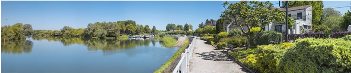
Vue d'ensemble depuis la digue de halage. A gauche, l'ancien lit de la Saône (hors dérivation). 21, Lechâtelet
