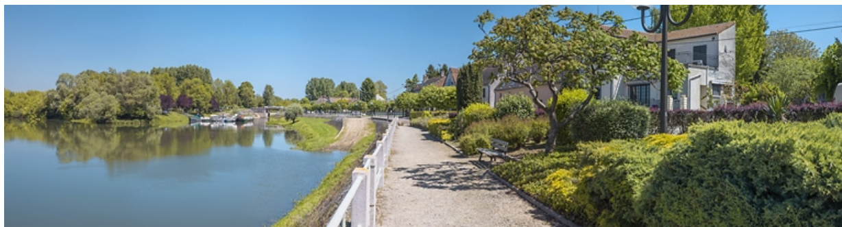
Vue d'ensemble de la digue de halage, en aval du site d'écluse et le long de la commune. 21, Lechâtelet
