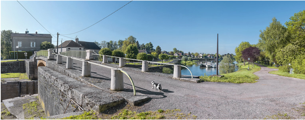
Vue d'ensemble de la commune sur la rive gauche de la Saône. Au premier plan le pont sur le site de l'écluse. 21, Lechâtelet
