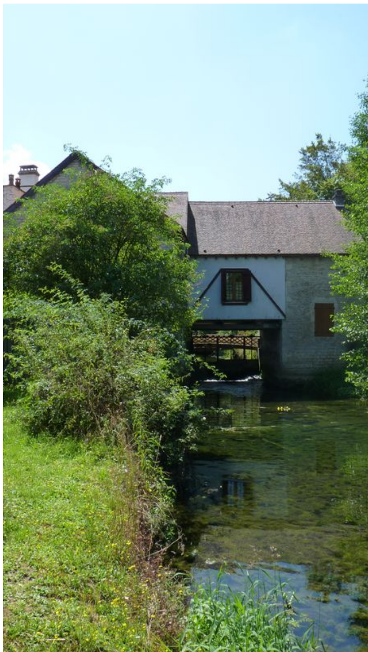
Vue du moulin depuis l'ouest.
