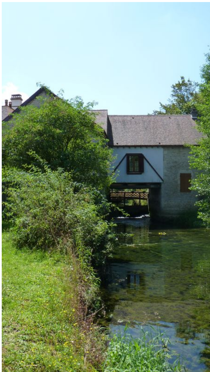
Vue du moulin depuis l'ouest.
