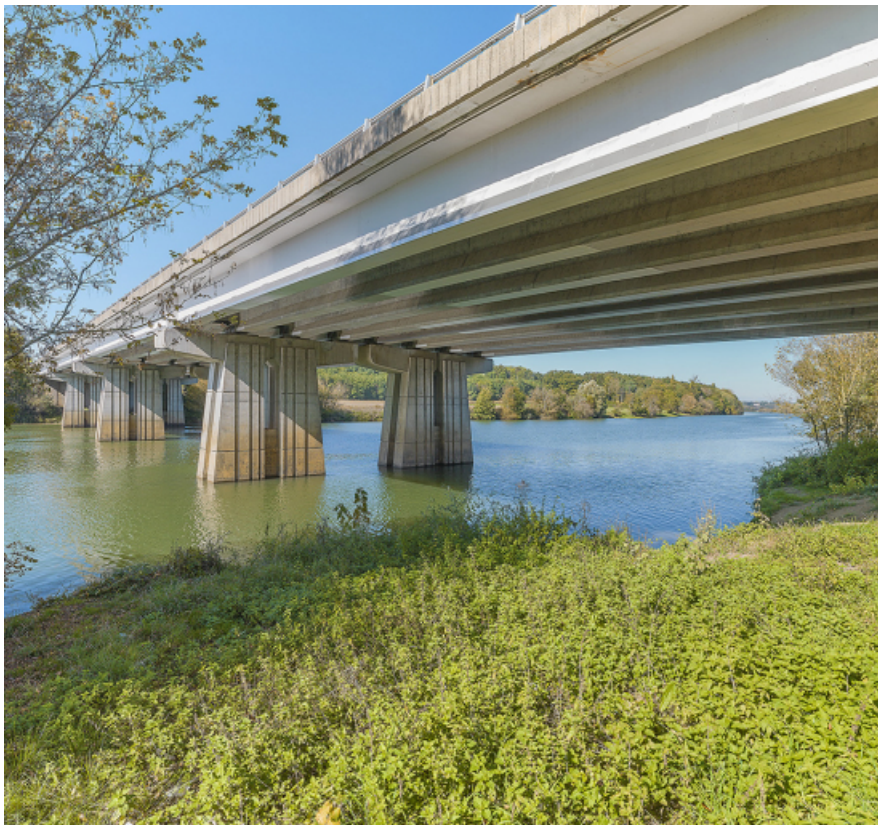
Vue rapprochée des piles et du tablier.
