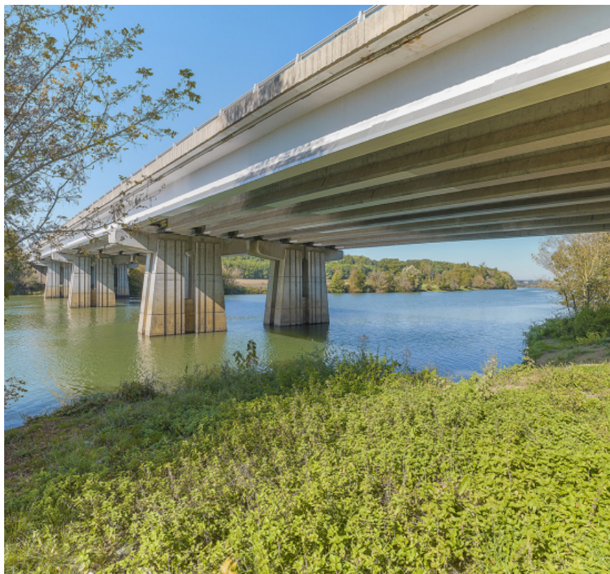
Vue rapprochée des piles et du tablier.
